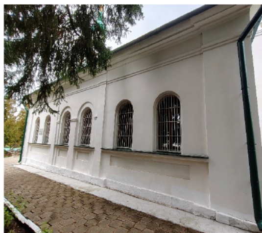
Южный фасад трапезной
