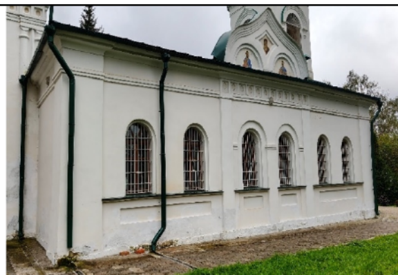
Трапезная. Северный фасад
