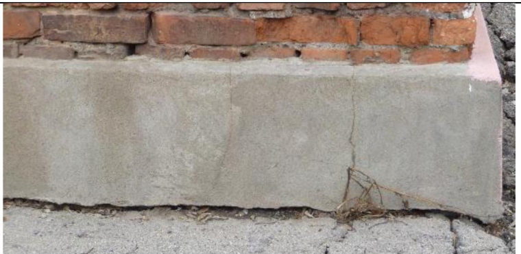
Фрагмент цоколя юго-западного фасада
