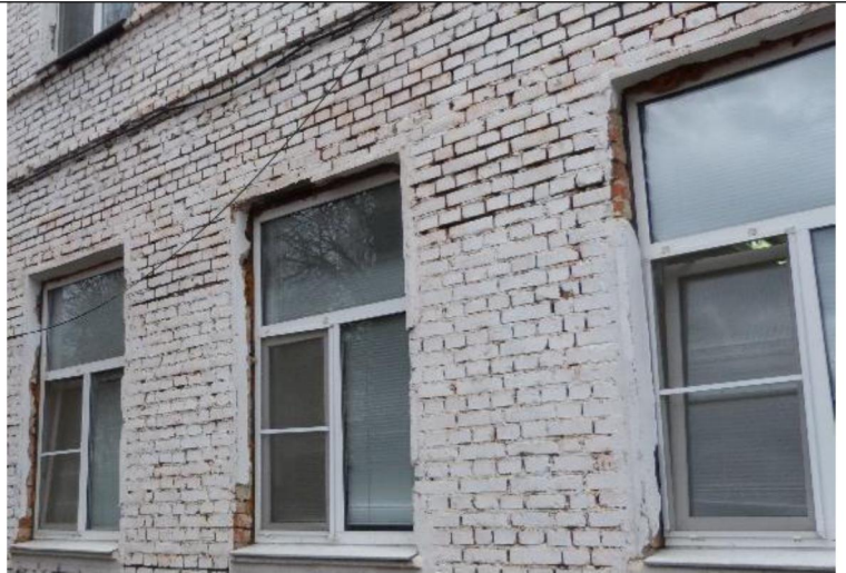
Фрагмент северо-западного фасада
