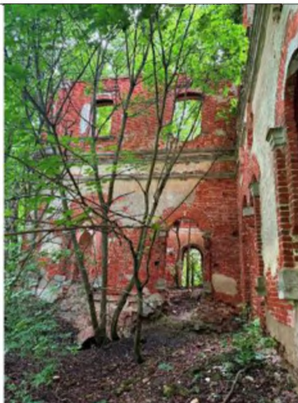
Западный фасад северного флигеля-ризалита
