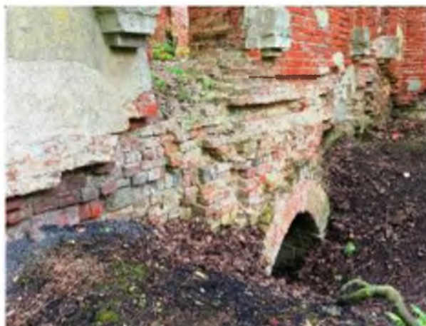
Вход в подвал
