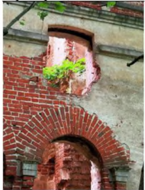
Фрагмент северного фасада
