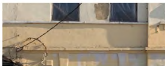
Фрагмент северо-западного фасада
