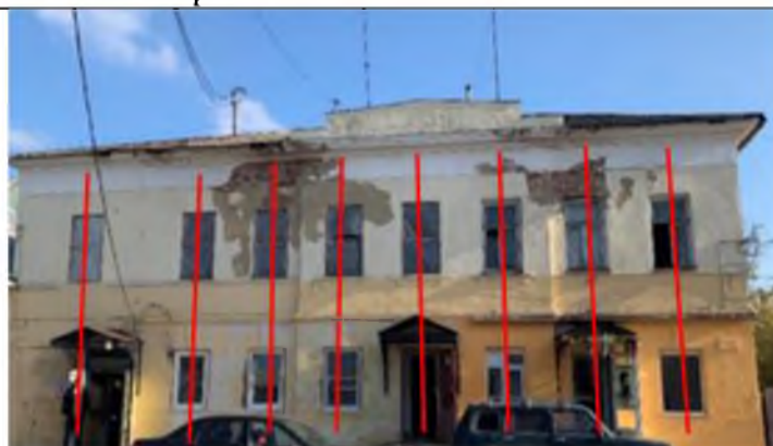
Северо-западный фасад здания
