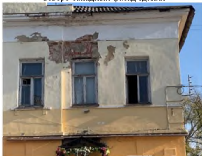
Фрагмент северо-западного фасада Клинчатые оконные перемычки
