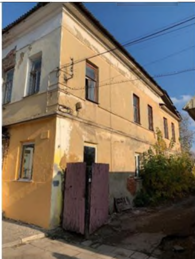
Фрагмент юго-западного фасада
