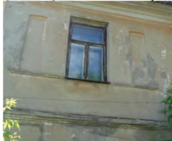
Фрагмент юго-восточного фасада Прямоугольные ниши, подоконная филленка
