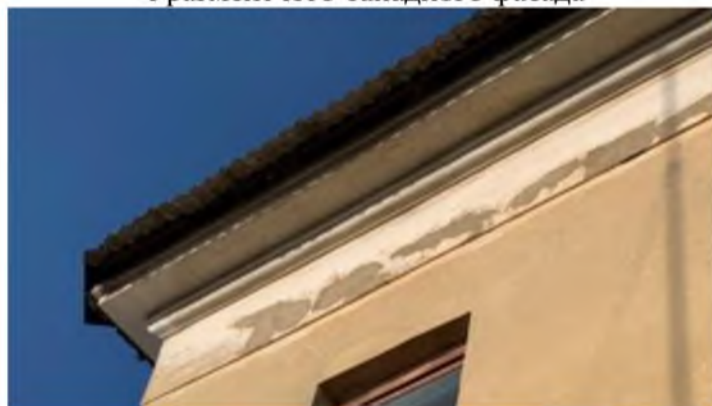
Фрагмент юго-западного фасада. Венчающий карниз
