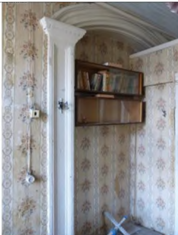
Деревянное оформление арочного проема
