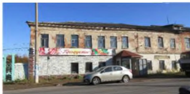
Вид на историческую (лит. А) часть здания
