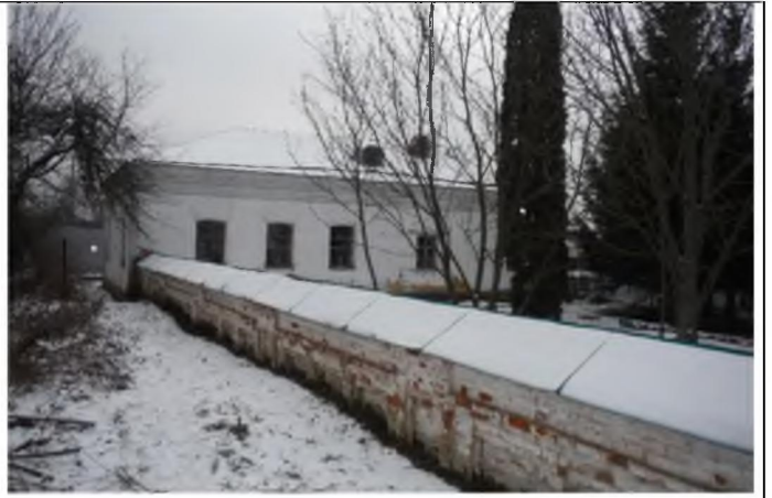
Восточный и северный фасады
