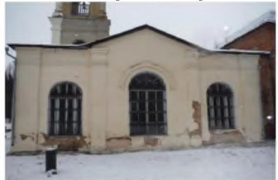
Южный фасад трапезной
