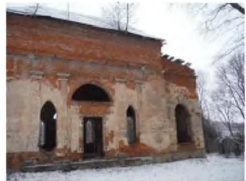
Южный фасад четверика
