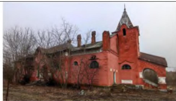
Общий вид юго-восточного фасада
