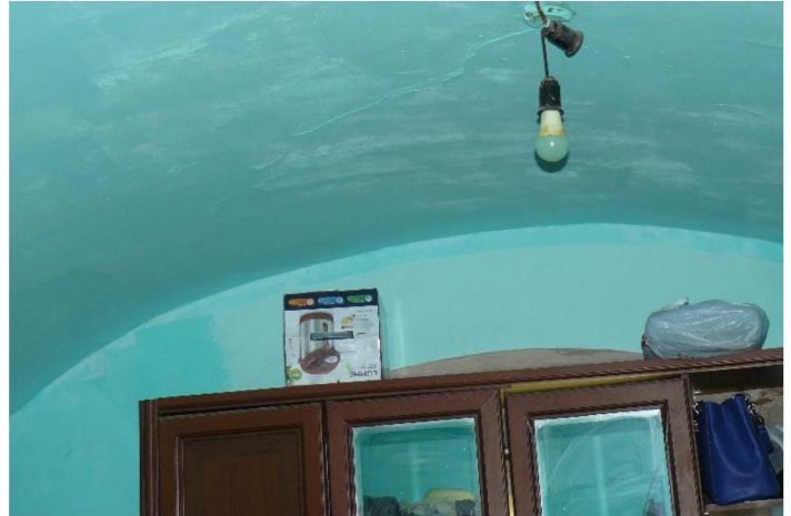
Сводчатое перекрытие первого этажа
