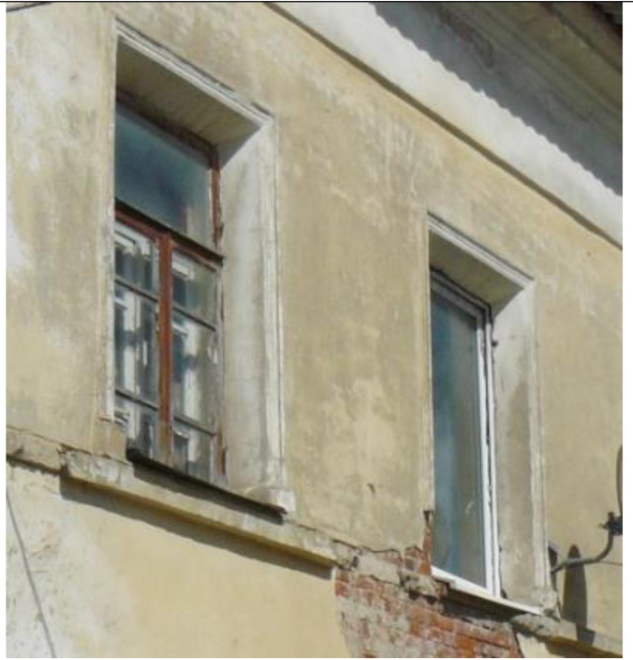
Рамочные профилированные наличники на подставах оконных проёмов второго этажа. Фрагмент юго-западного фасада лит. А
