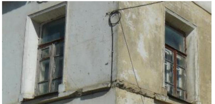
Западный угол здания, оконные заполнения
