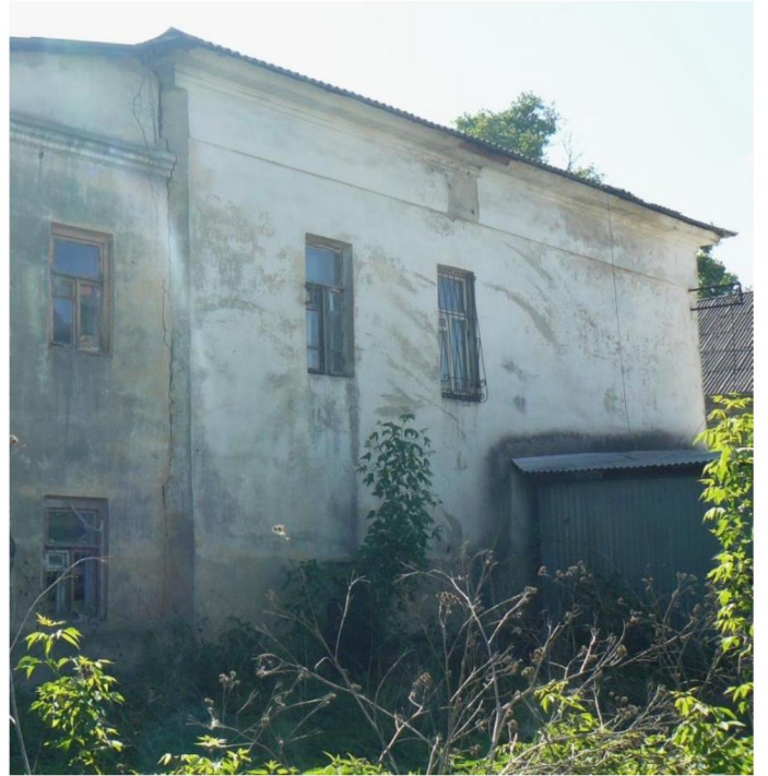
Северо-восточный фасад лит. А
