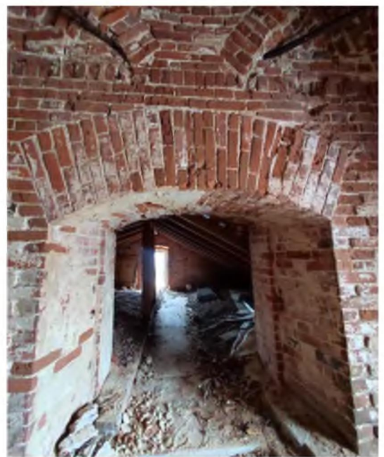
Дверной проём 2-го яруса колокольни (южная стена)
