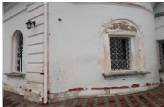
Фрагмент восточного фасада трапезной. Прямоугольный оконный проём южного придела
