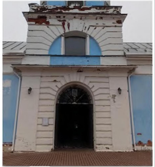
Проёмы западного фасада колокольни (1-й и 2-й ярусы)
