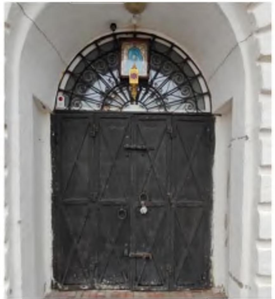
Металлическая кованая дверь главного входа, кованая решётка фрамуги
