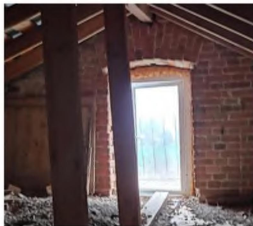
Фрагмент чердачного пространства трапезной. Лучковый дверной проём южного фронтона
