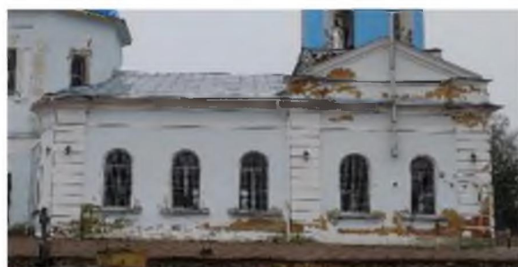
Северный фасад трапезной
