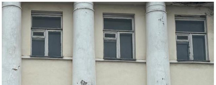
Фрагмент северо-западного фасада
