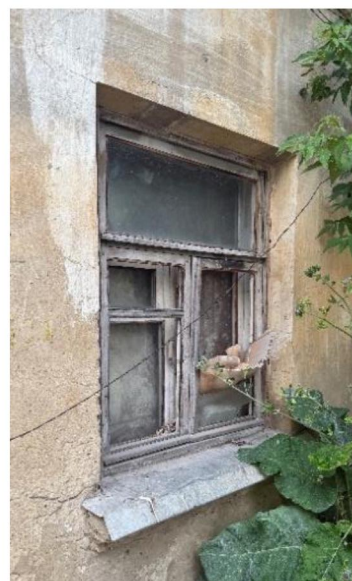
Оконный проем первого этажа юго-восточного фасада
