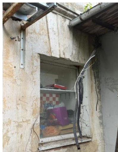
Оконный проем первого этажа северо-восточного фасада
