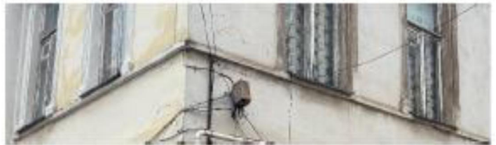
Фрагмент северо-западного и юго-западного фасадов
