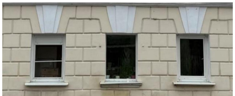
Оконные проемы первого этажа северо-западного фасада
