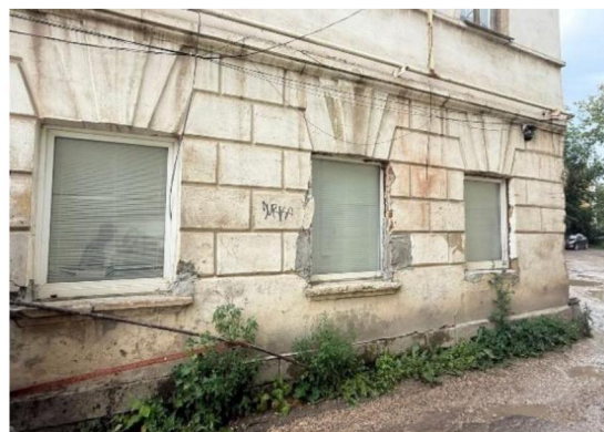
Оконные проемы первого этажа юго-западного фасада
