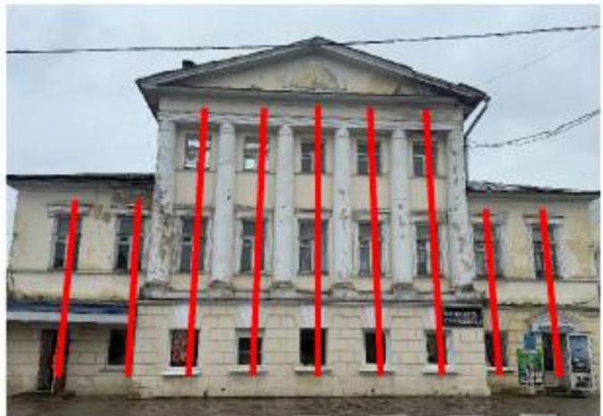
Фрагмент северо-западного фасада
