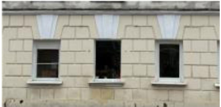
Фрагмент первого этажа северо-западного фасада
