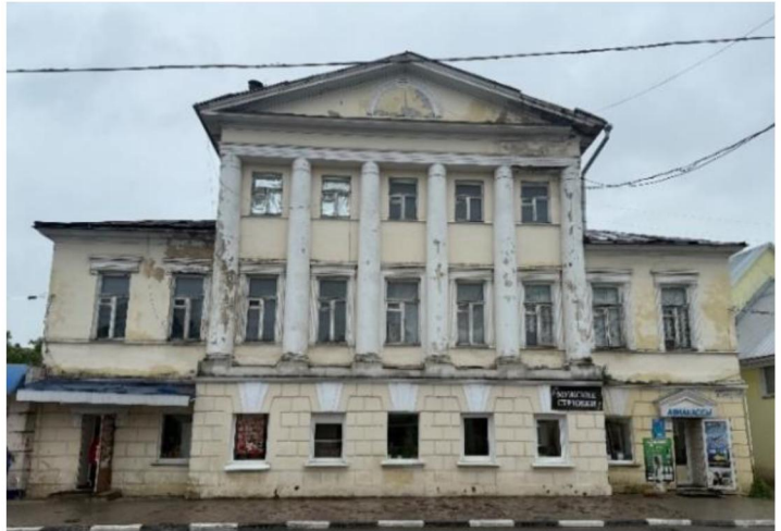
Северо-западный фасад здания
