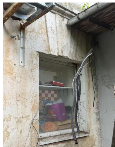
Оконный проем первого этажа северо-восточного фасада
