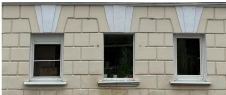
Оконные проемы первого этажа северо-западного фасада
