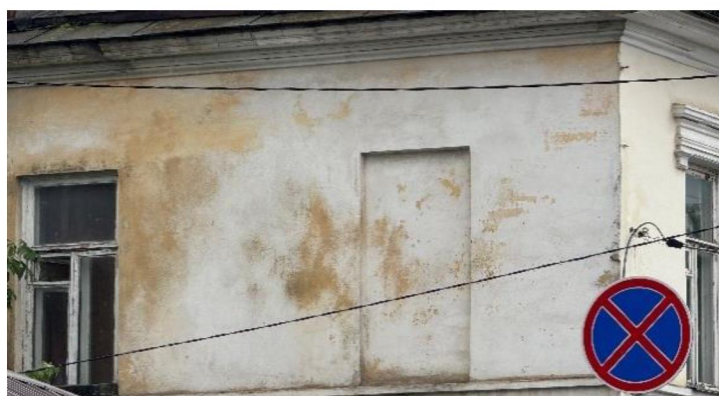
Фрагмент северо-восточного фасада
