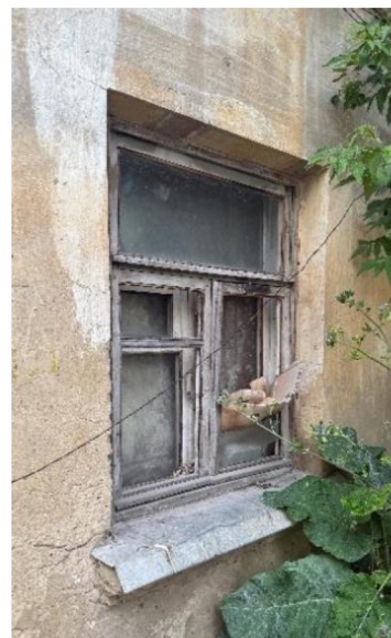
Оконный проем первого этажа юго-восточного фасада
