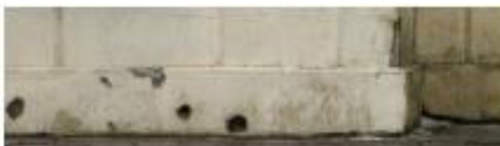
Фрагмент северо-западного фасада
