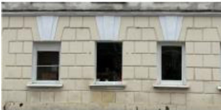
Фрагмент первого этажа северо-западного фасада
