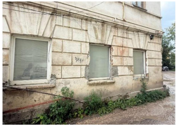
Оконные проемы первого этажа юго-западного фасада
