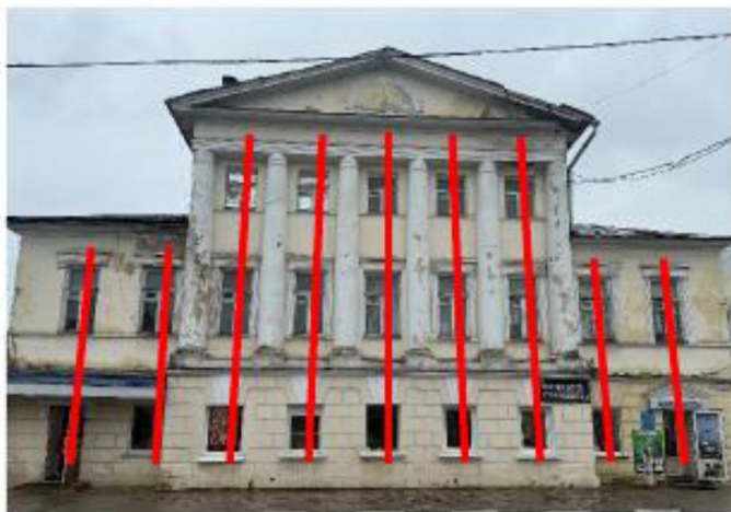
Фрагмент северо-западного фасада
