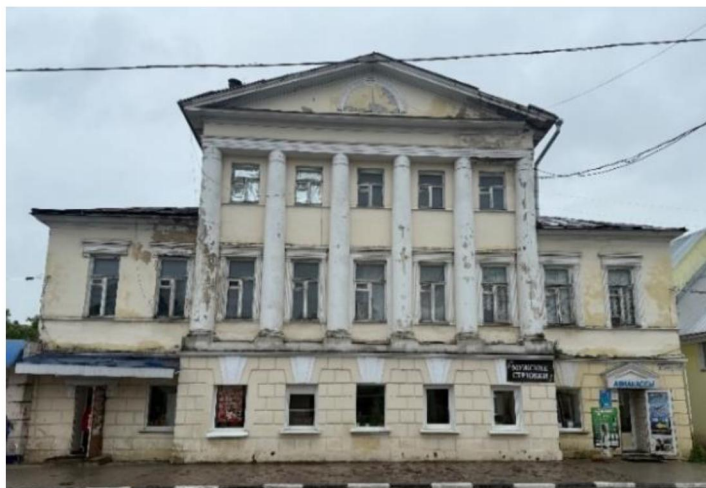
Северо-западный фасад здания
