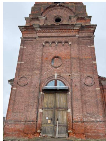
Колокольня. Первый ярус. Вид с запада.
