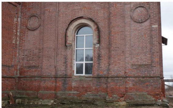
Фрагмент стены с проемом первого яруса колокольни.
