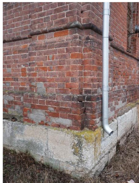
Угловая раскреповка пилястр трапезной.
