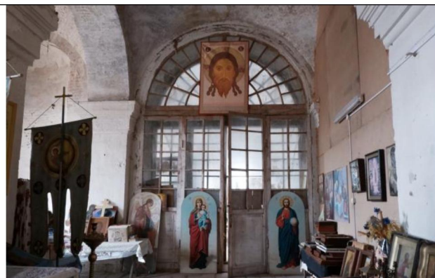
Фрагмент помещения трапезной. Вид на арку в четверик.
