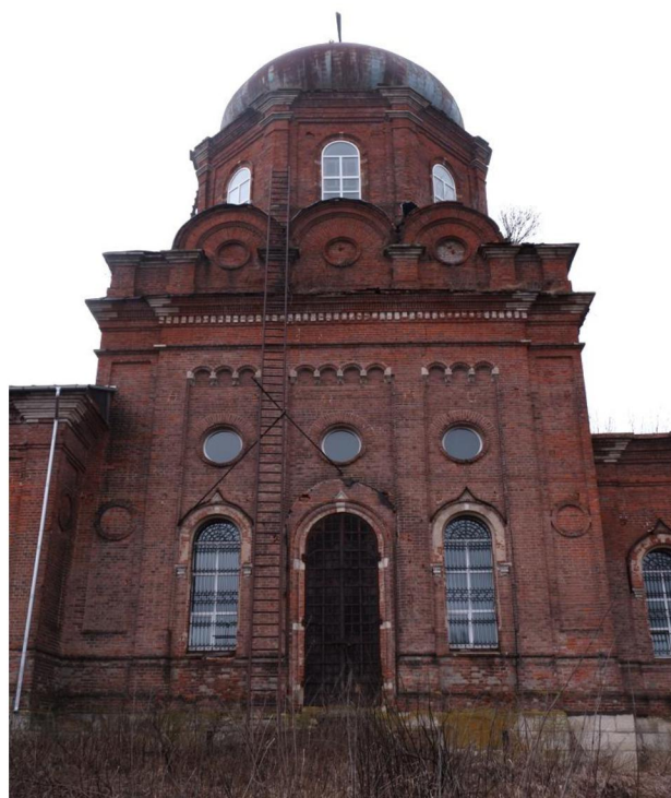
Общий вид четверика церкви. Южный фасад.
