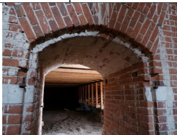
Проем в стене первого яруса колокольни.
