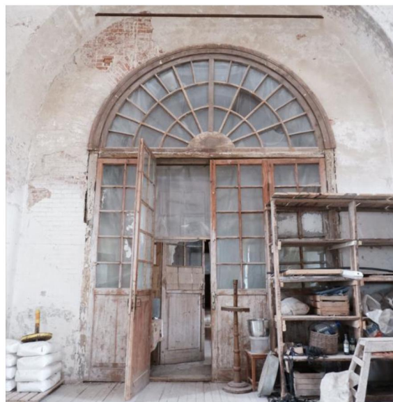
Вид на заполнение проема со стороны четверика.
