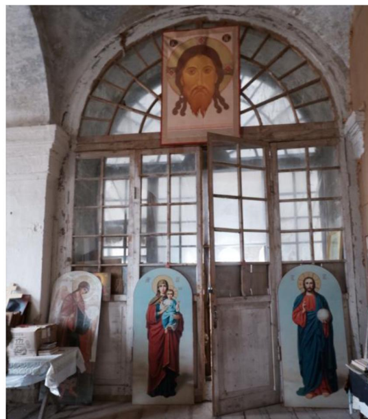
Вид на заполнение проема со стороны трапезной.
