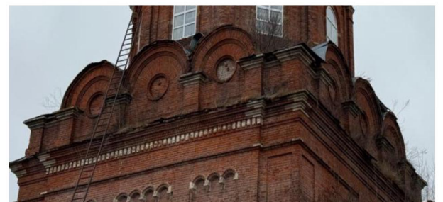
Аттики на фасадах четверика. Общий вид.
