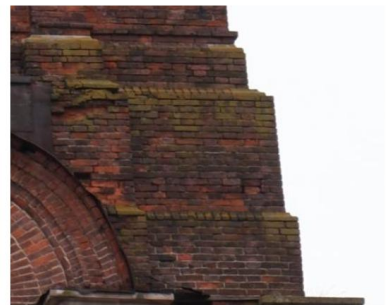
Второй ярус. Ступенчатое основание.
