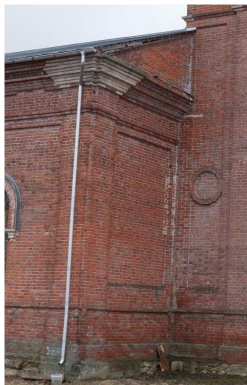
Фрагмент западного фасада трапезной.
