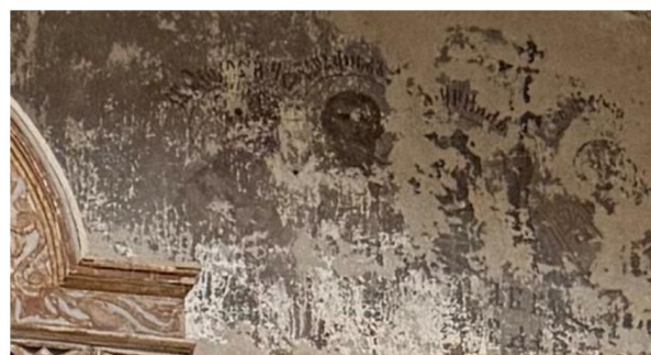
Фрагмент росписи на восточной стене четверика.
