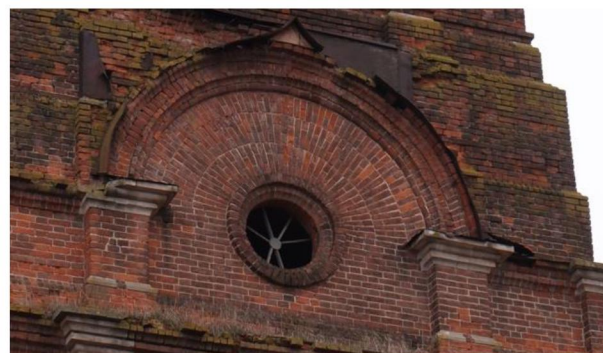
Проем аттика первого яруса колокольни.
