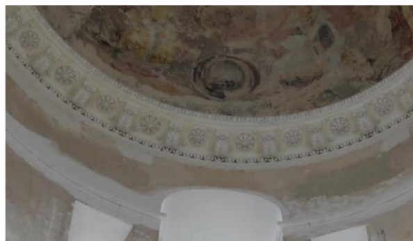
Фрагмент карниз в завершении барабана
