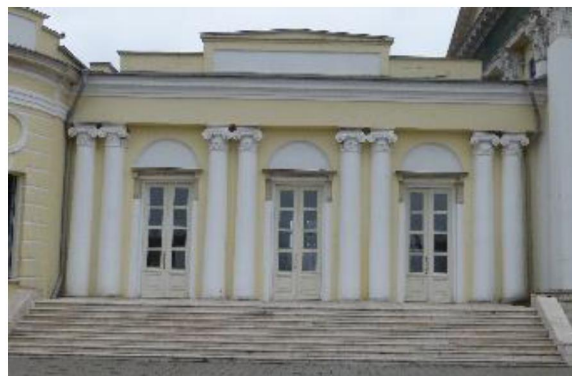
Южный фасад галереи-перехода
