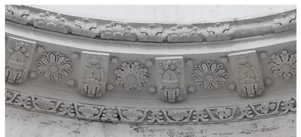
Фрагмент карниз в основании барабана
