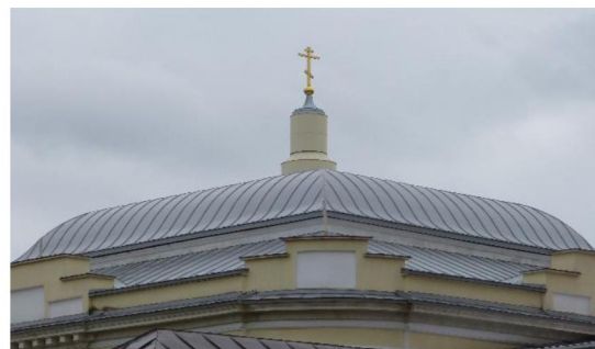
Вид на крышу трапезной с северо-запада
