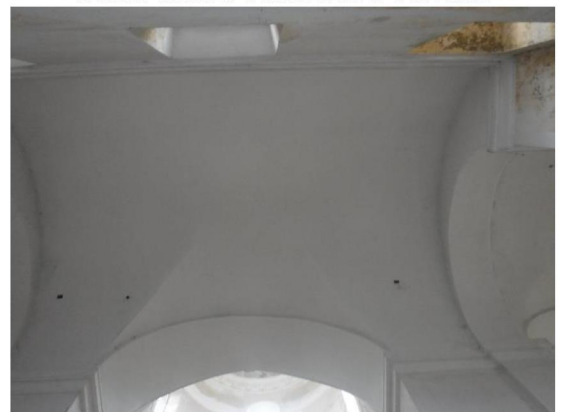
Цилиндрический свод с распалубкой
