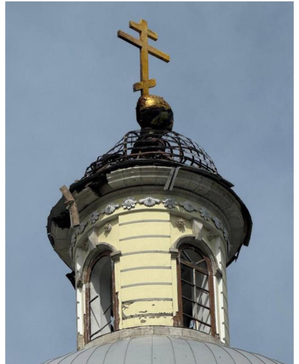
Световой барабан (латернин) основного объёма
