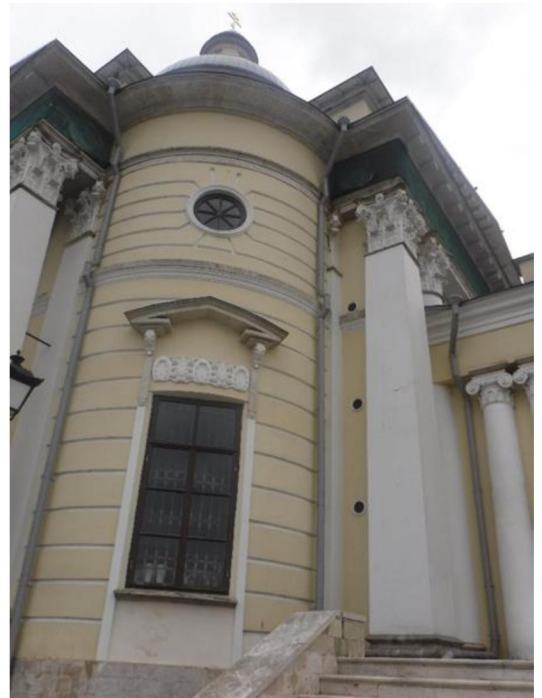
Скругленный угол основного объёма
