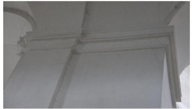
Профилированный карниз столпа
