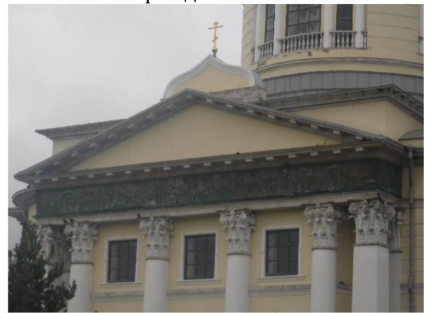
Фрагмент восточного фасада основного объёма
