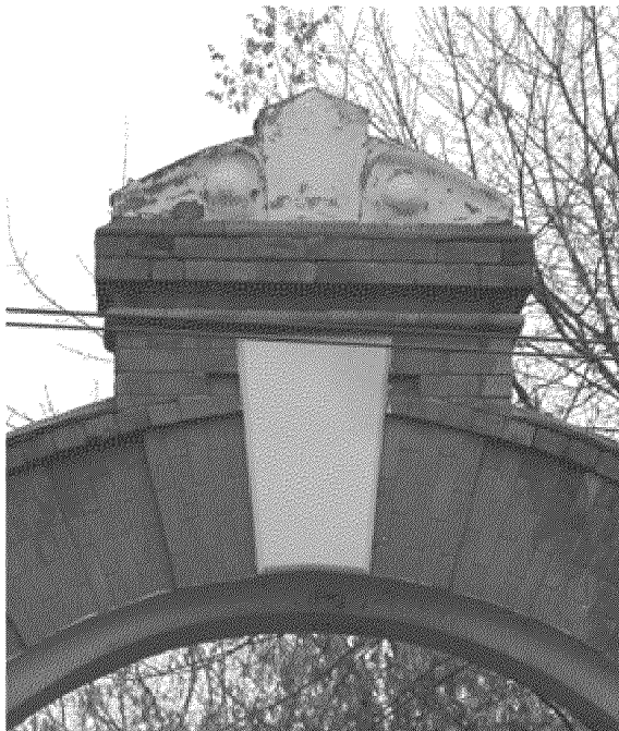
Видовая точка № 7. «Каменные ворота». Фрагмент руста на арочной перемычке
