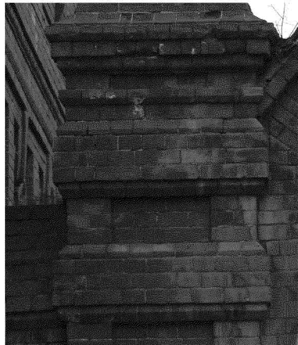
Видовая точка № 8. «Каменные ворота». Фрагмент руста на кирпичных столбах
