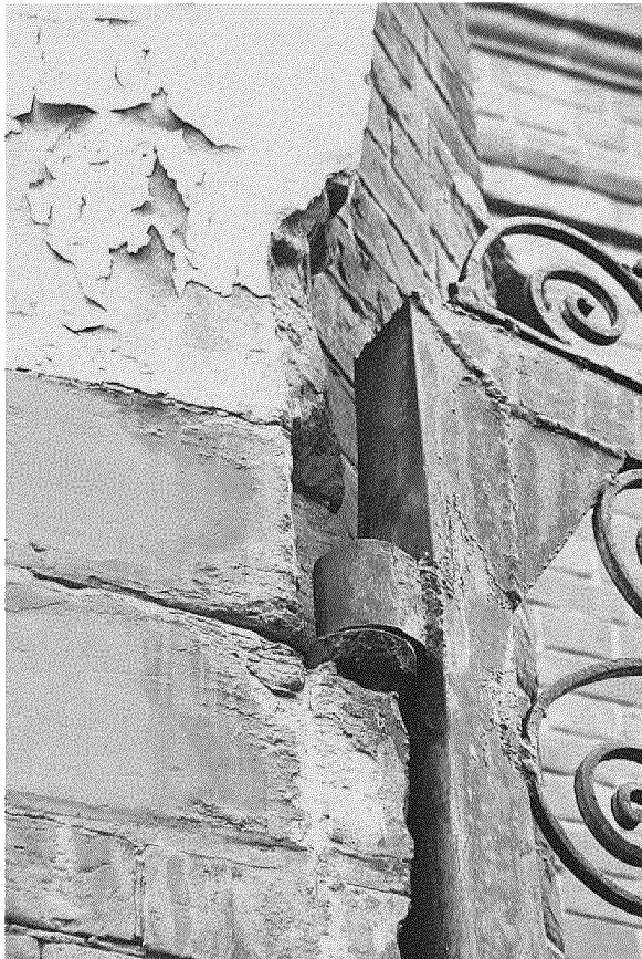
Видовая точка № 5. «Каменные ворота». Фрагмент крепления правой створки на кованый подстав
