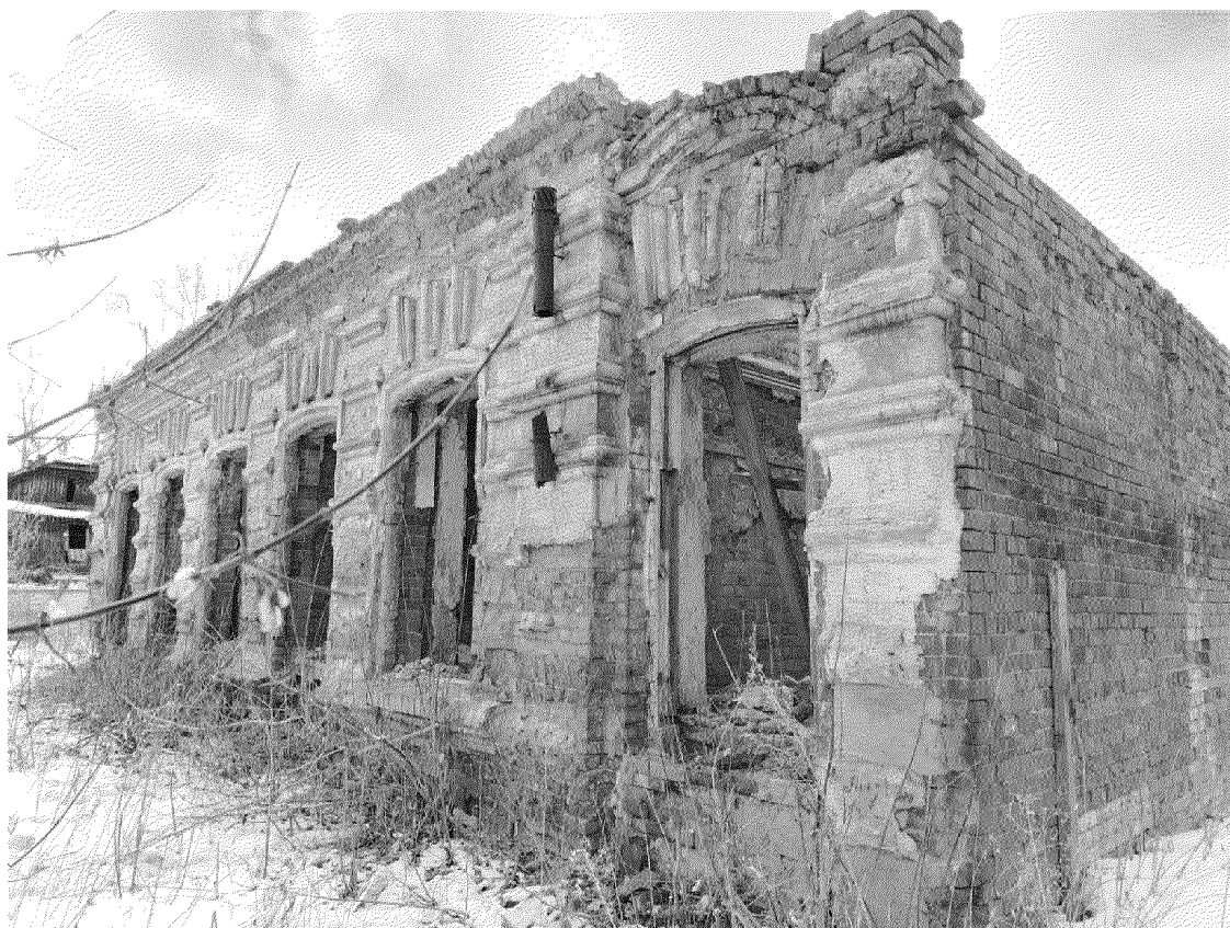
Видовая точка № 4. Вид главного фасада с северо-востока.
