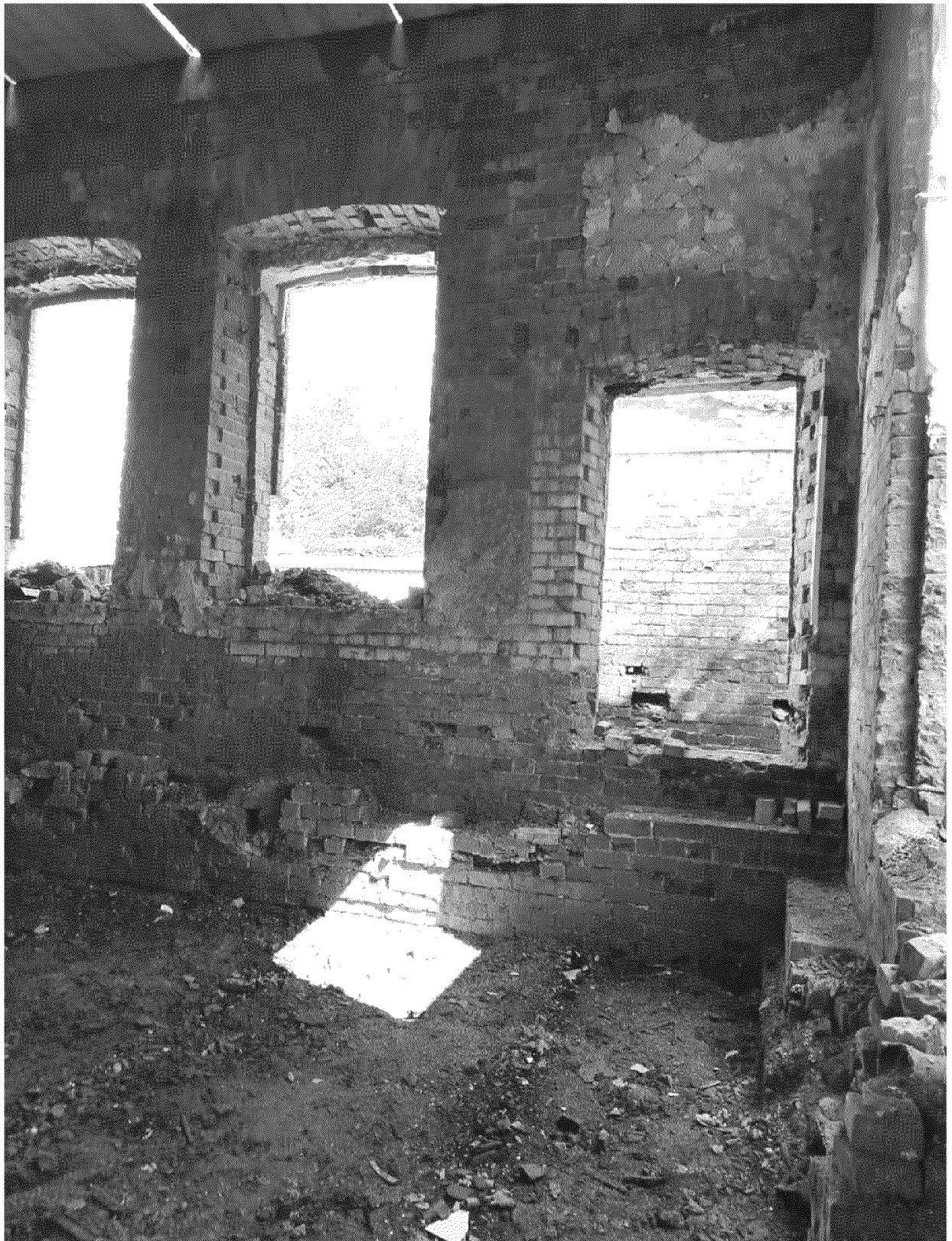
Видовая точка № 16. Фрагмент центрального южного помещения с дверным проемом.
