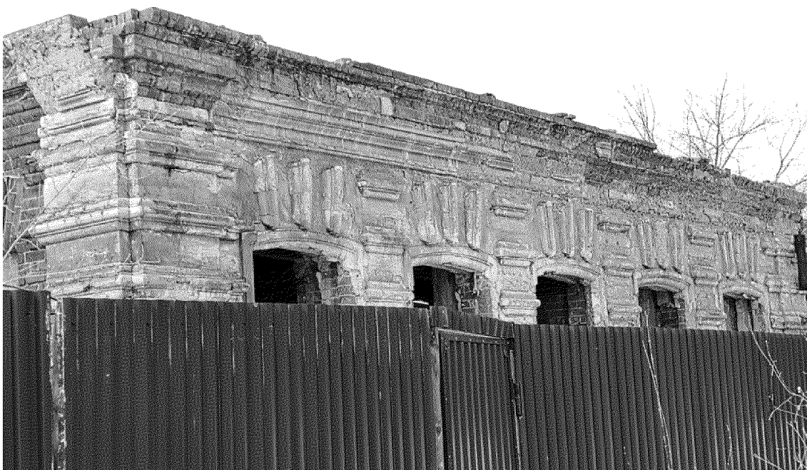
Видовая точка № 2. Вид главного фасада с ул. Свердлова.
