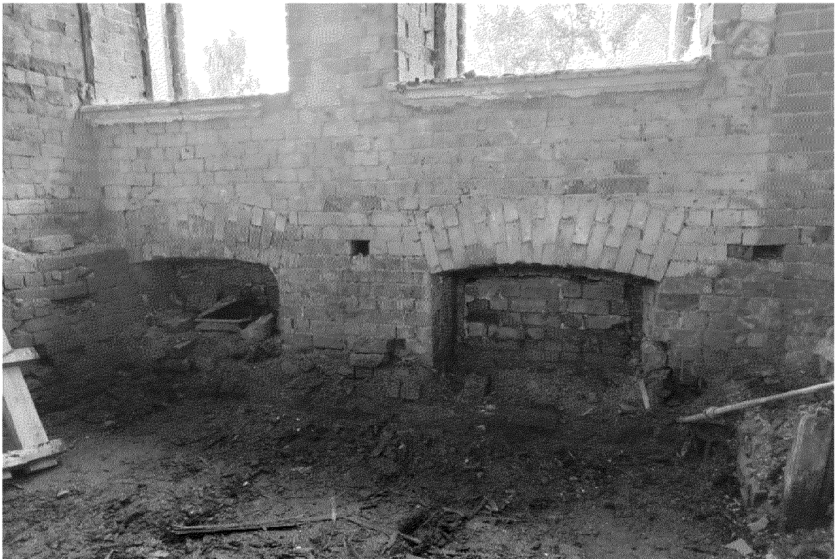
Видовая точка № 14. Оконные проемы подвала центрального южного помещения.
