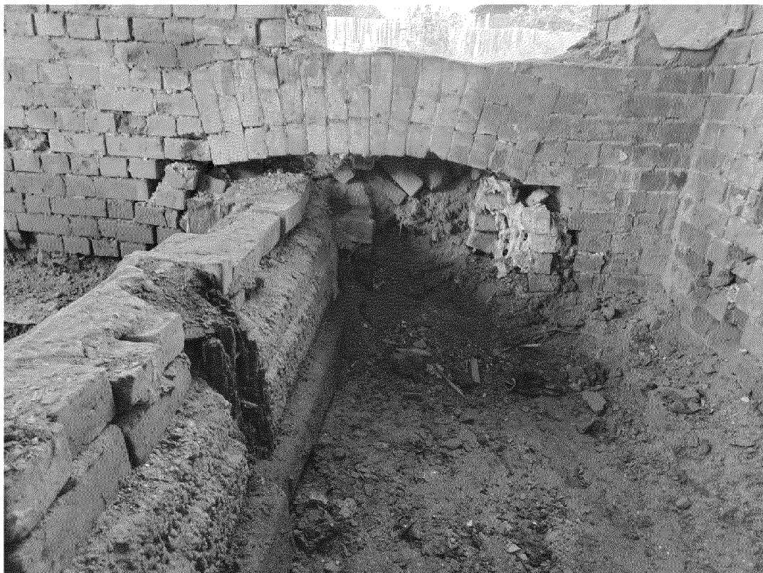
Видовая точка № 15. Перемычка бывшего входа в подвал.
