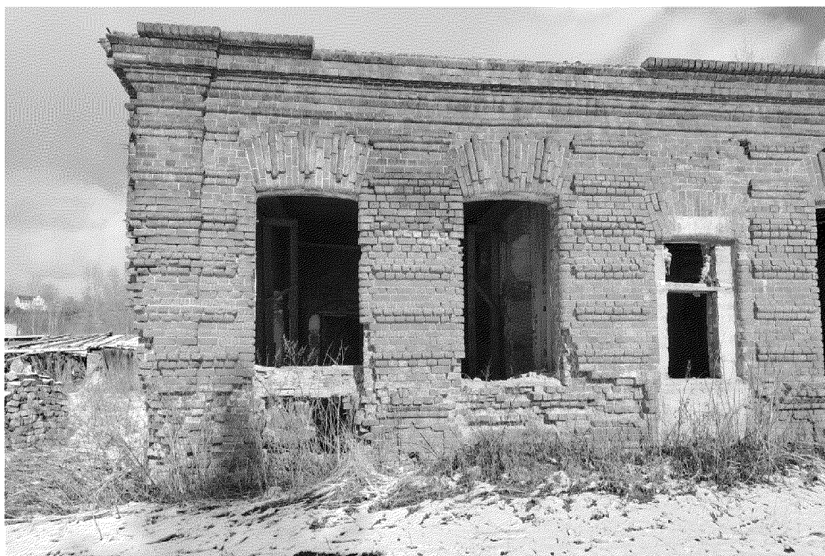
Видовая точка 11. Фрагмент южного фасада.
