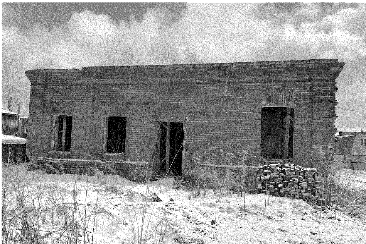
Видовая точка № 9. Западный фасад.
