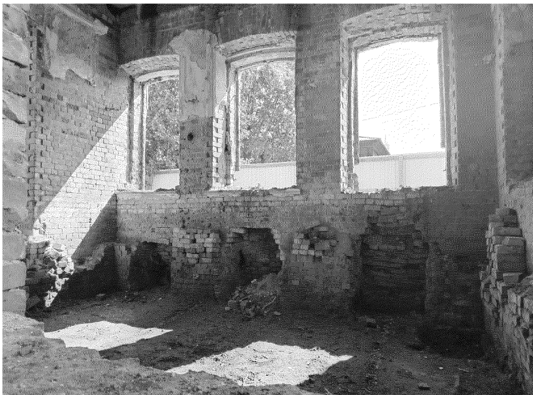
Видовая точка № 12. Внутренний вид юго-восточного помещения.
