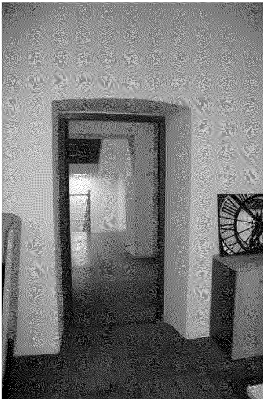
Видовая точка № 41. Дверной проём с лучковой перемычкой в помещении 2-го этажа
