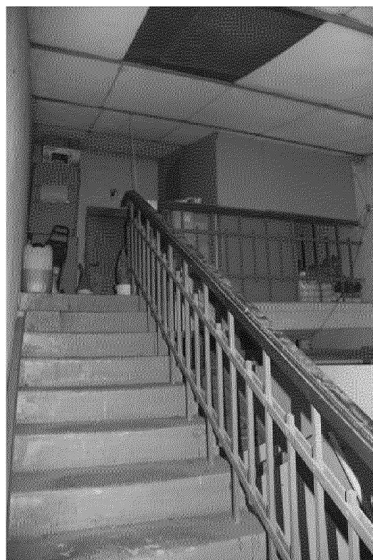
Видовая точка № 46. Лестница на чердак южной части здания
