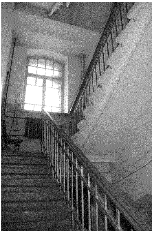
Видовая точка № 18. Подъезд №1. Лестница северной части здания с дворовым входом (1 этаж)
