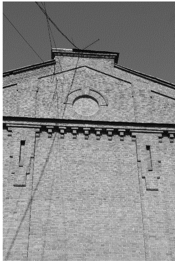
Видовая точка № 5. Фрагмент фронтона торцевого восточного фасада
