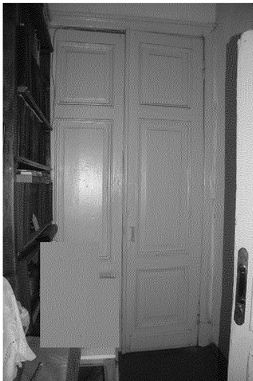
Видовая точка № 22. Подъезд №1. Дверь в жилую комнату (кв. 1-го этажа)
