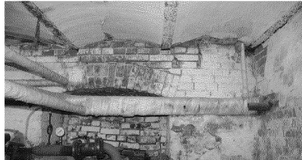
Видовая точка № 30, 31 Подъезд №2. Кирпичный свод (санузел). Перекрытие из кирпичных сводов по металлическим балкам (подвал).
