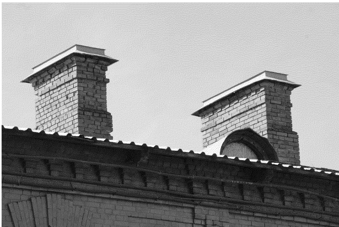
Видовая точка № 51. Кирпичные дымовые трубы
