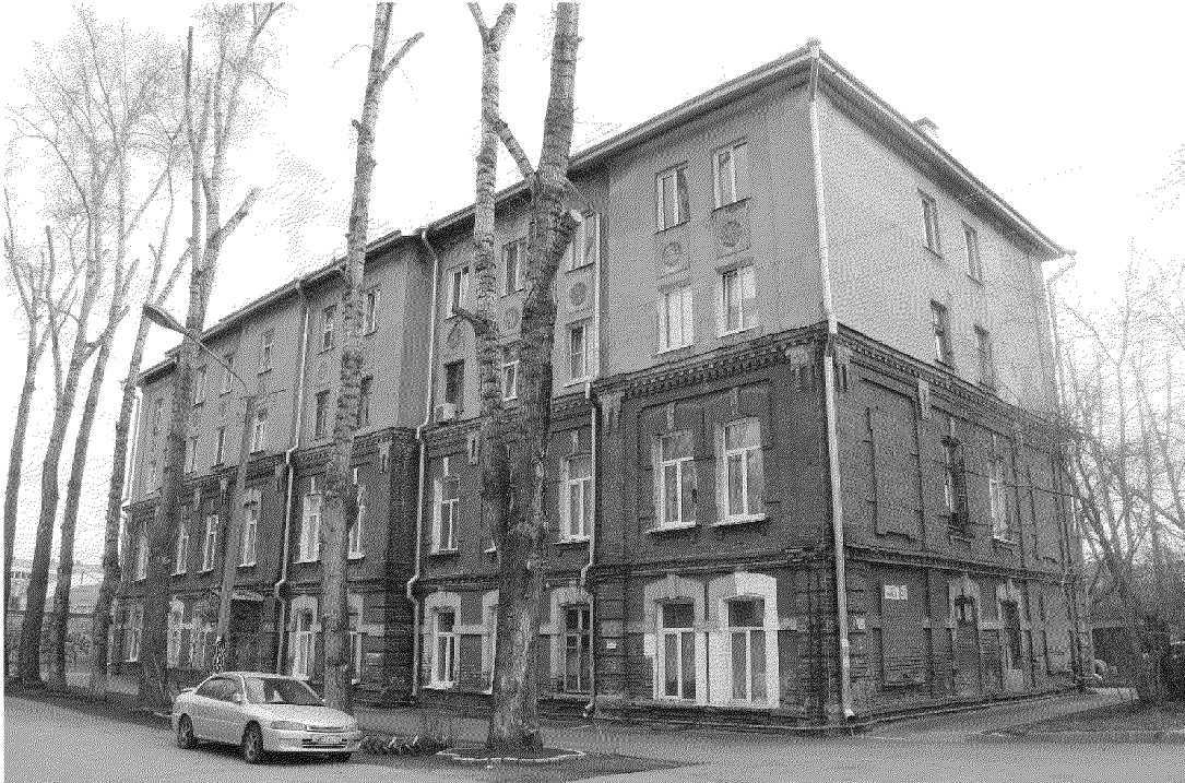
Видовая точка № 66. ул. Кулёва, 28. Общий вид здания с юго-западной стороны
