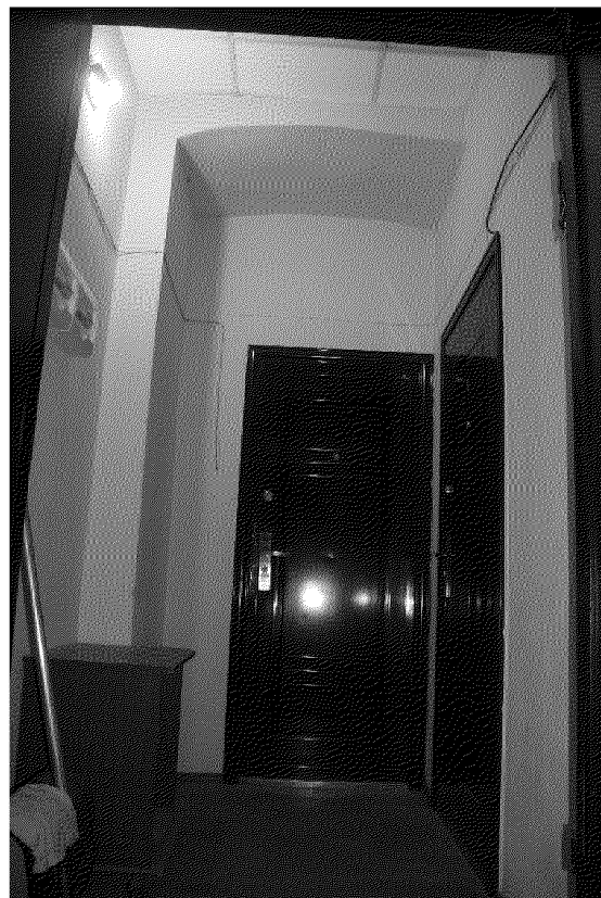
Видовая точка № 15. Подъезд №2. Дверной проём с лучковой перемычкой в коридоре 1 этажа
