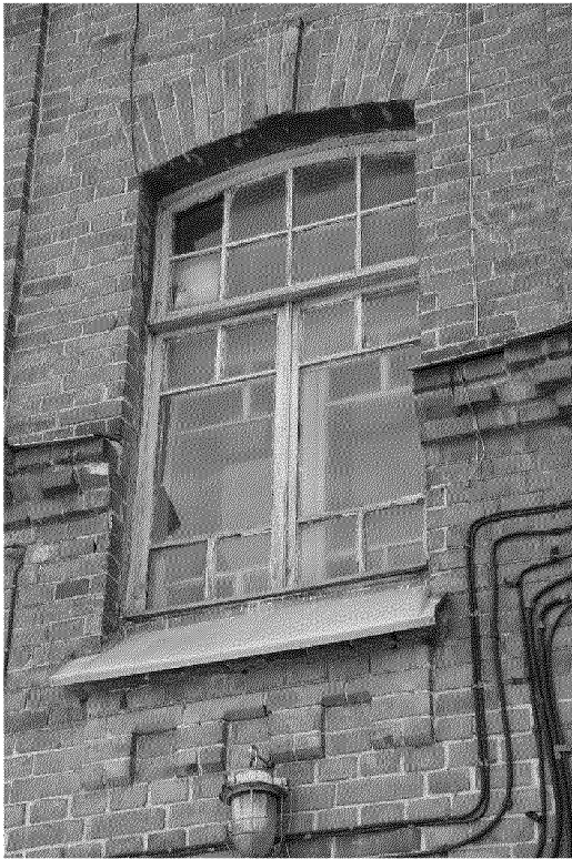
Видовая точка № 9. Подъезд №1. Окно 2-го этажа ризалита северного фасада
