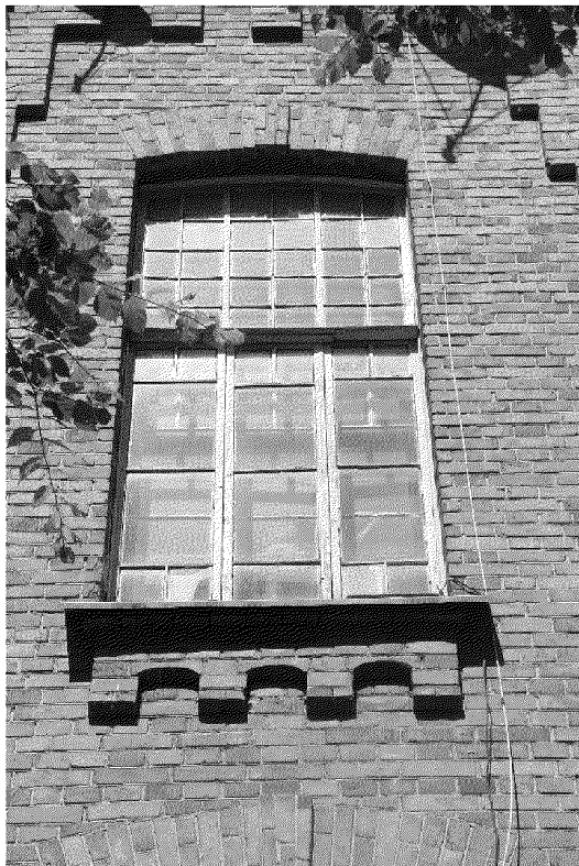
Видовая точка № 11. Подъезд №4. Окно ризалита южного фасада
