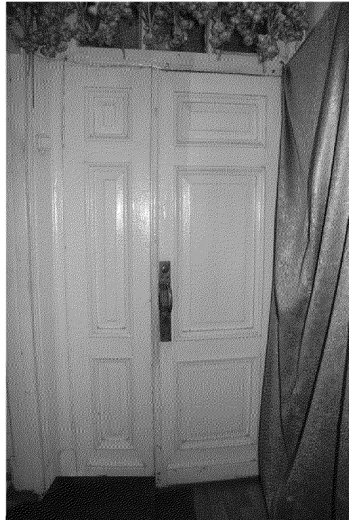
Видовая точка № 21. Подъезд №1. Внутренняя дверь тамбура с фрамугой (кв.1-го этажа)
