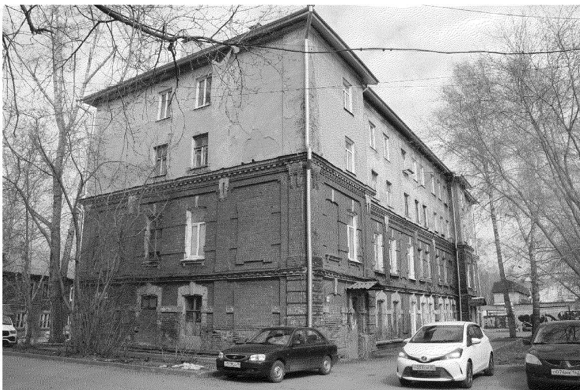
Видовая точка № 68. ул. Кулёва, 28. Общий вид здания с юго-восточной стороны
