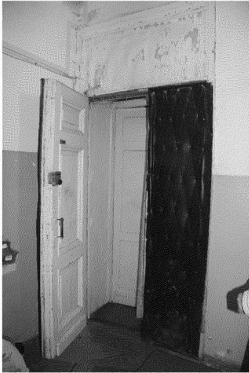
Видовая точка № 20. Подъезд №1. Дверь входа в квартиру 1-го этажа с тамбуром
