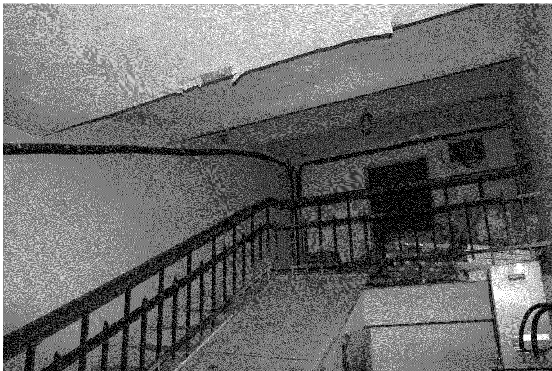
Видовая точка № 57. Лестница подъёма на чердак в южной части здания
