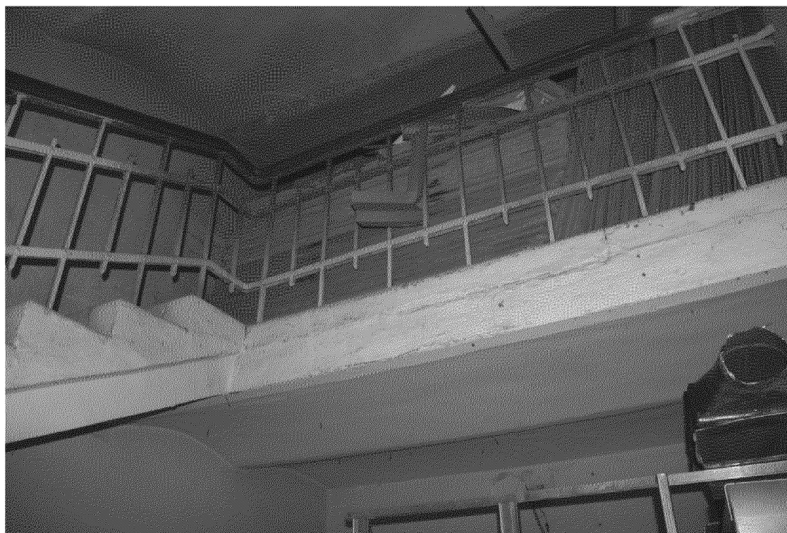
Видовая точка № 58. Лестничная площадка в уровне выхода на чердак северной части здания
