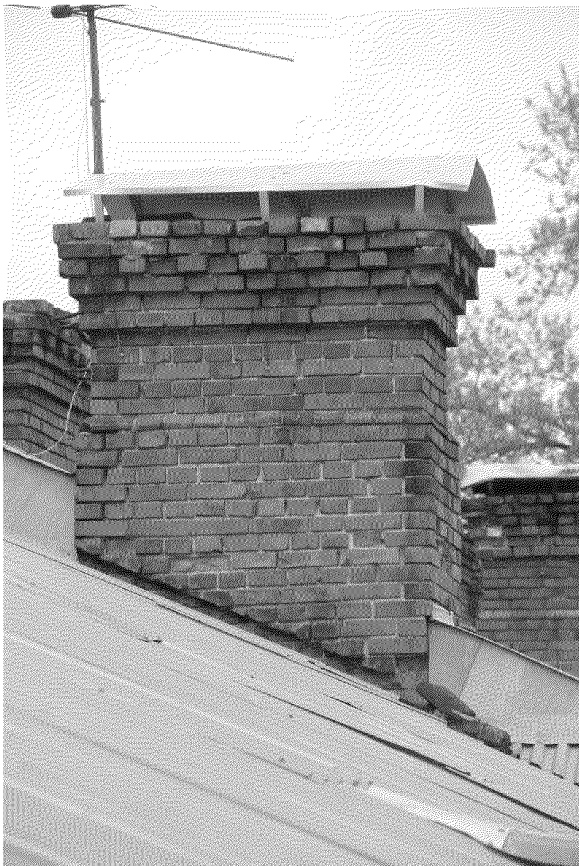
Видовая точка № 7. Дымовая труба (вид с крыши)
