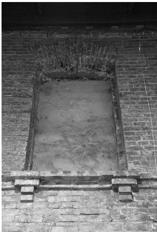
Видовая точка № 55. Оконный проём 2-го этажа западного фасада
