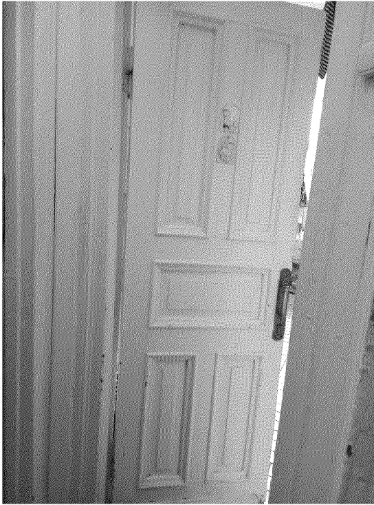
Видовая точка № 24. Подъезд №1. Дверь в санузел квартиры 1-го этажа
