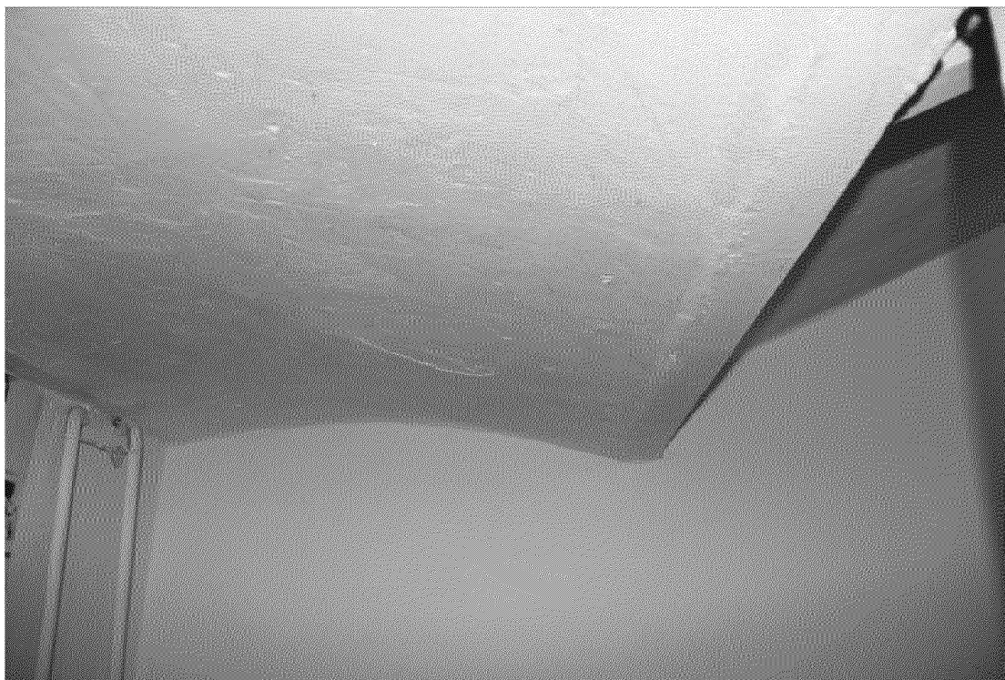
Видовая точка № 47. Кирпичный свод в конструкции междуэтажной площадки
