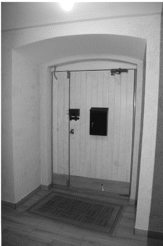
Видовая точка № 14. Подъезд №5. Дверной проём уличного входа (южная часть здания)
