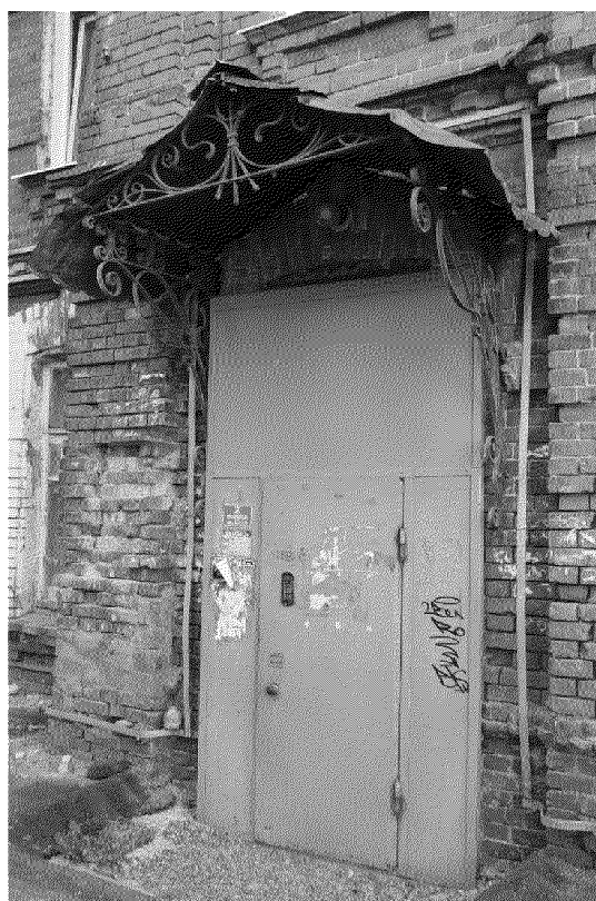
Видовая точка № 71. Дворовый вход с кованым козырьком восточного фасада
