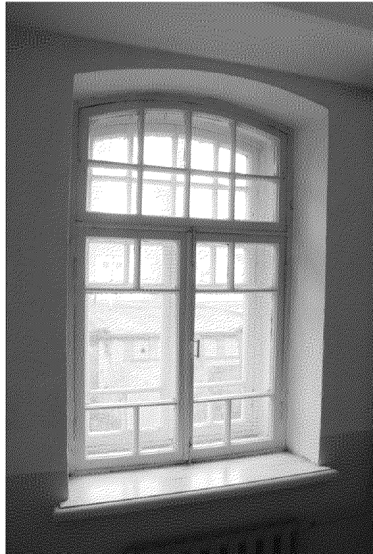
Видовая точка № 10. Подъезд №1. Окно 2-го этажа ризалита лестничного блока
