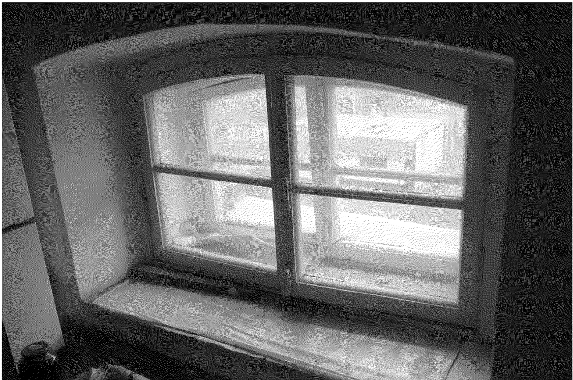
Видовая точка № 13. Подъезд №3. Окно в уровне чердака лестницы северной части здания
