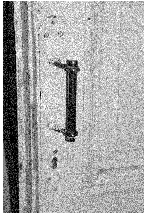
Видовая точка № 25. Подъезд №1. Ручка входной двери (железо)
