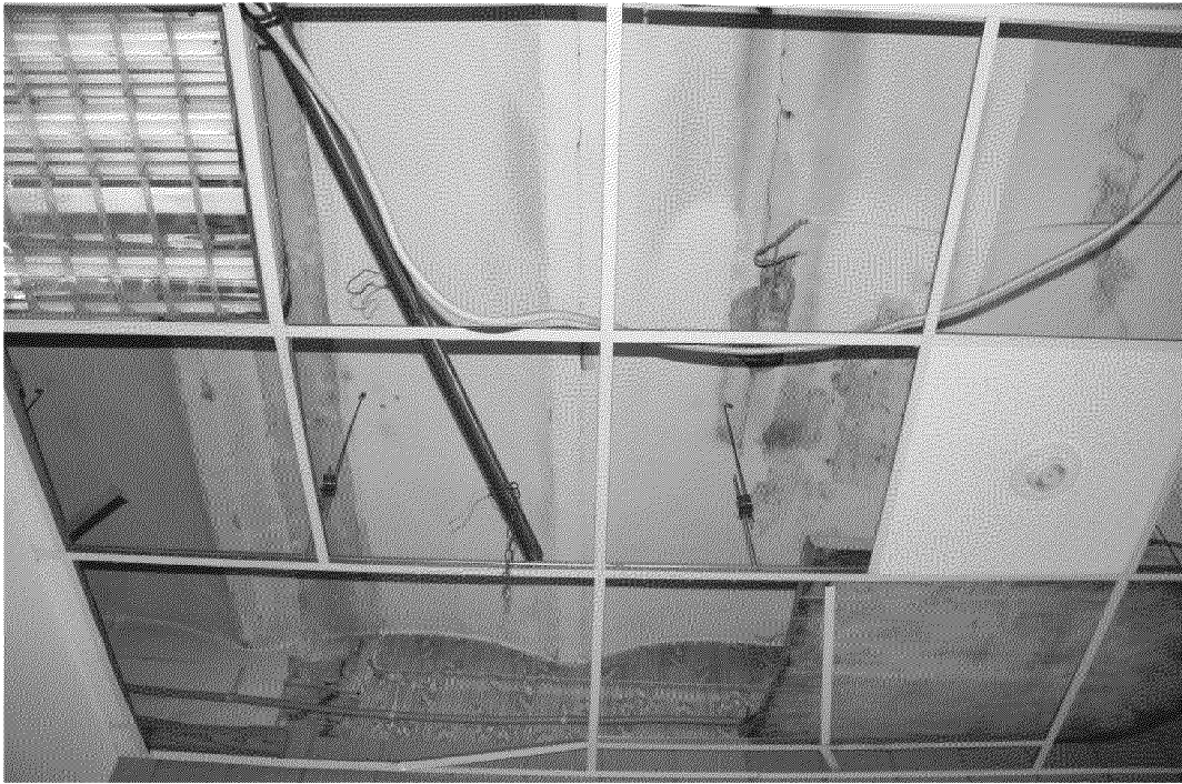
Видовая точка № 59. Перекрытие из кирпичных сводов по металлическим балкам в коридоре 2-го этажа южной части здания
