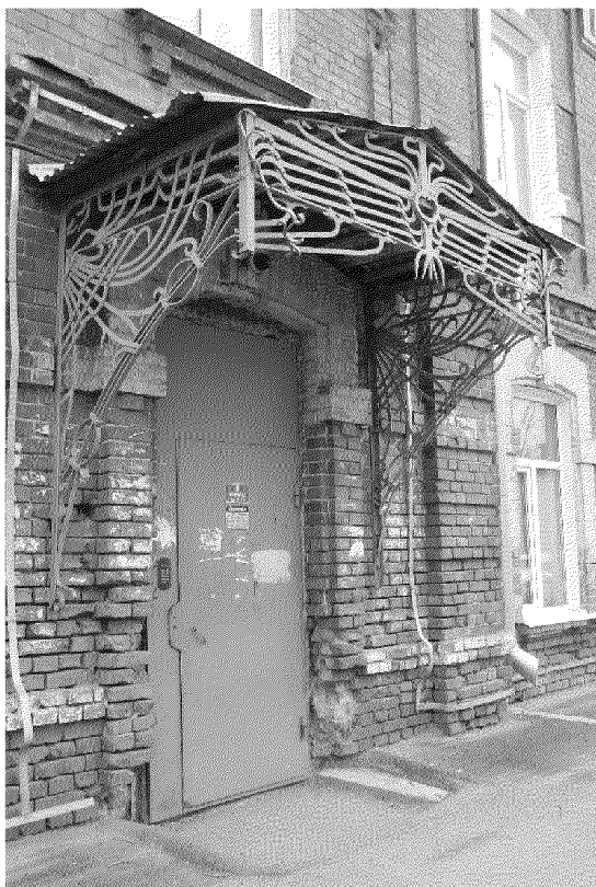
Видовая точка № 70. Парадный вход с кованым козырьком западного фасада
