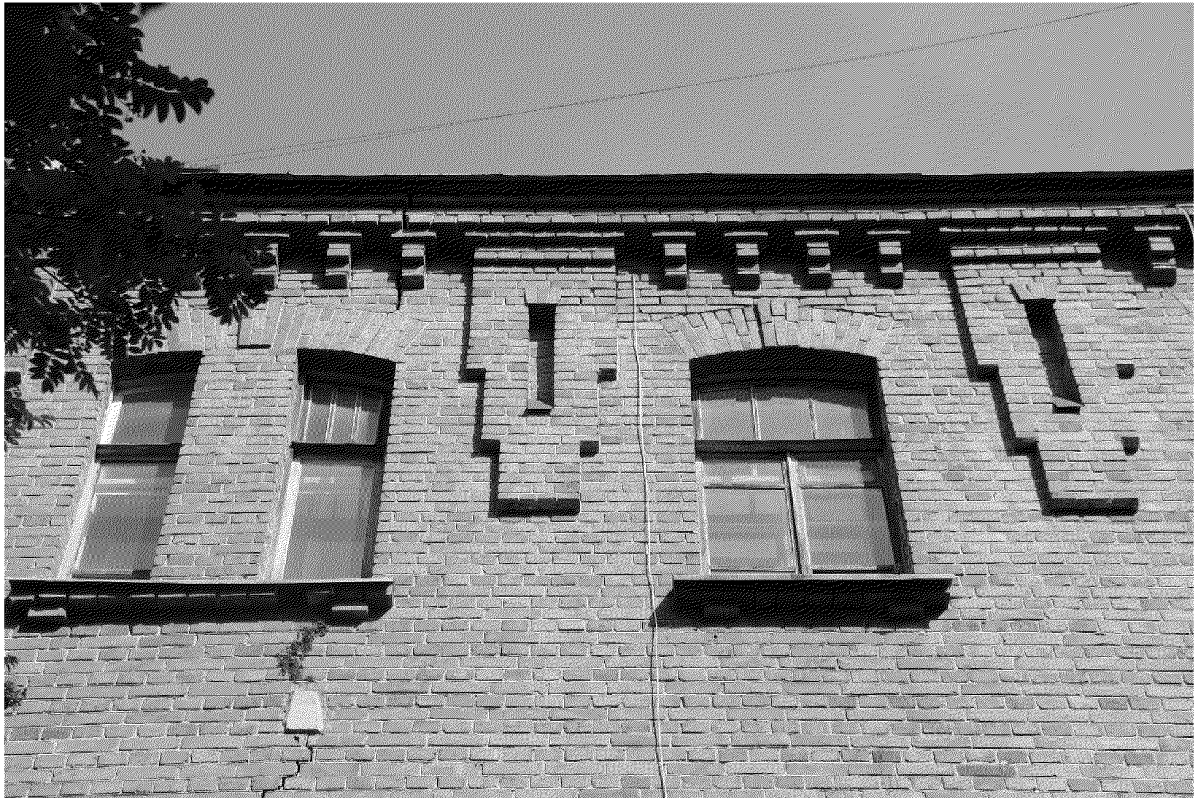
Видовая точка № 6. ул. Нахимова, 6. Окна 3-го этажа южного фасада
