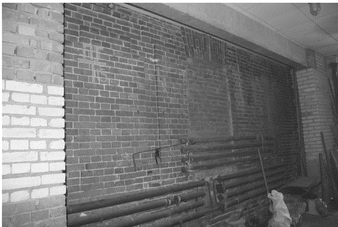
Видовая точка № 38. Фрагмент северного фасада здания
