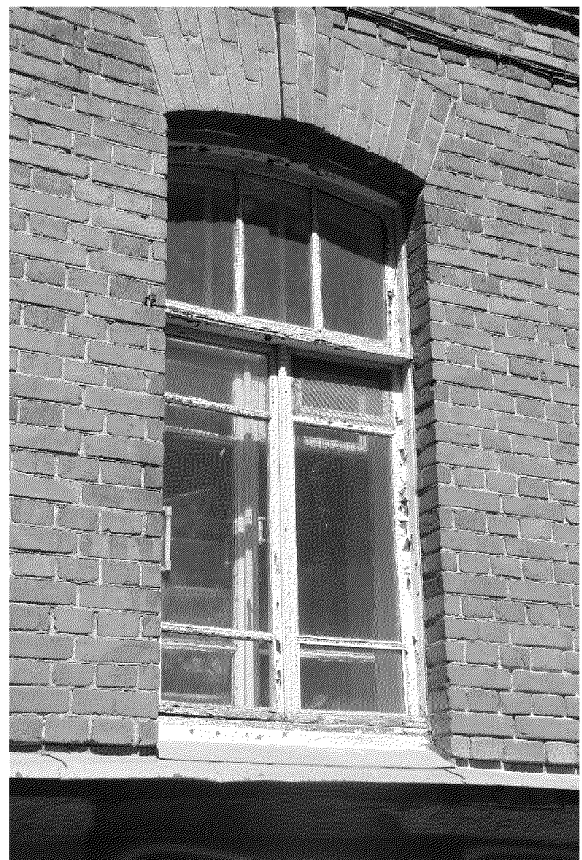
Видовая точка № 8. Окно 1-го этажа южного фасада
