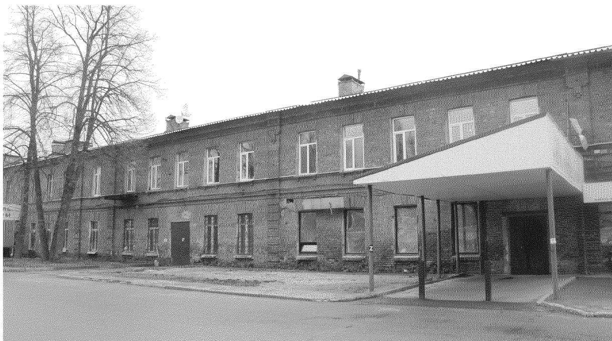
Видовая точка № 35. ул. Нахимова, 8/1. Фрагмент западного фасада здания (13.05.2025 г.)
