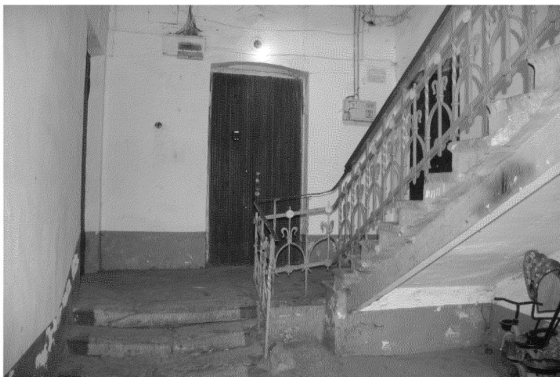
Видовая точка № 72. Парадная лестница со ступенями из песчаника и кованым ограждением (1 этаж)
