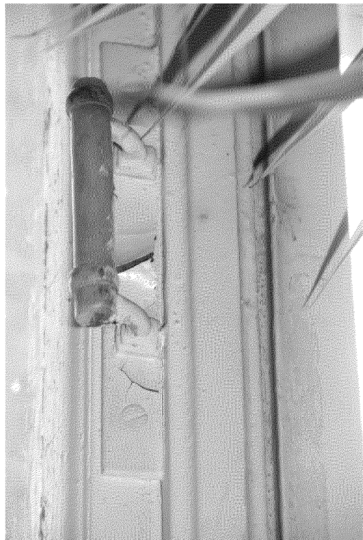
Видовая точка № 12. Подъезд №4. Скобяная фурнитура (ручка) окна 2-го этажа лестницы
