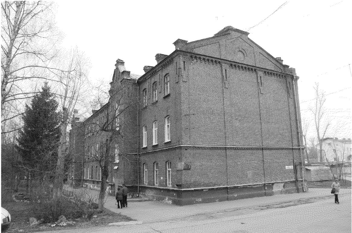
Видовая точка № 3. ул. Нахимова, 6. Общий вид здания с юго-восточной стороны
