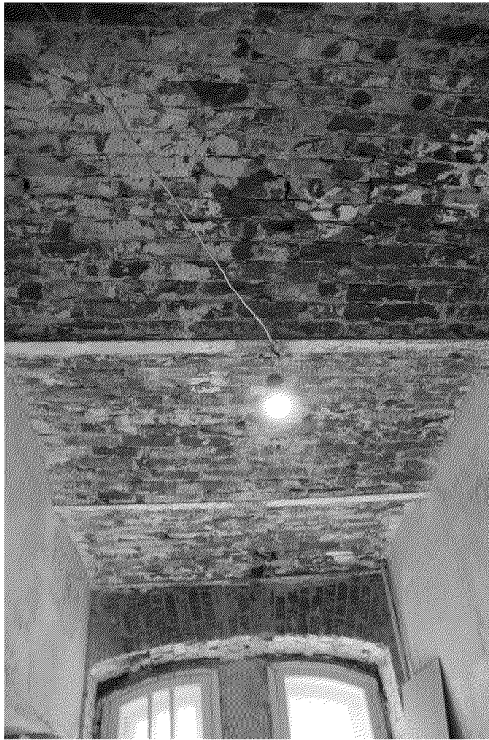
Видовая точка № 29. Подъезд №2. Перекрытие из кирпичных сводов по металлическим балкам
