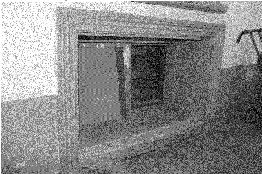
Видовая точка № 78. Окно-фрамуга над парадным входом, вид с междуэтажной площадки лестницы западной части дома
