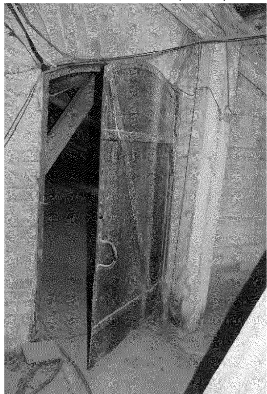
Видовая точка № 33. Дверной проём с кованой железной дверью на чердаке
