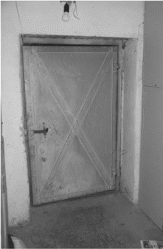
Видовая точка № 39. Металлическая дверь выхода на чердак (в южной части здания)
