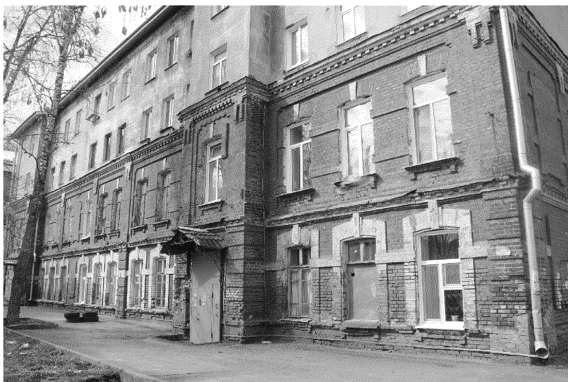
Видовая точка № 69. ул. Кулёва, 28. Дворовый восточный фасад здания
