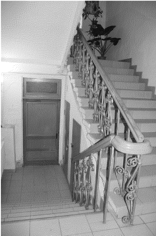
Видовая точка № 16. Подъезд №4. Лестница южной части здания с уличным входом (1 этаж)
