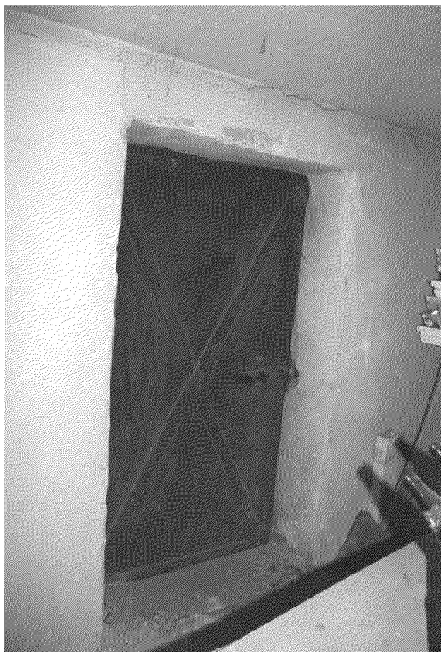
Видовая точка № 62. Железная дверь выхода на чердак в северной части здания.
