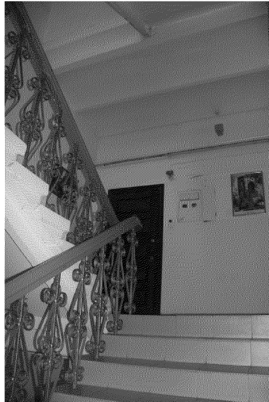
Видовая точка № 17. Подъезд №4. Общий вид лестницы (2 этаж)
