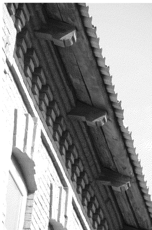
Видовая точка № 53. Венчающий карниз здания со свесом кровли на фигурных деревянных кобылках
