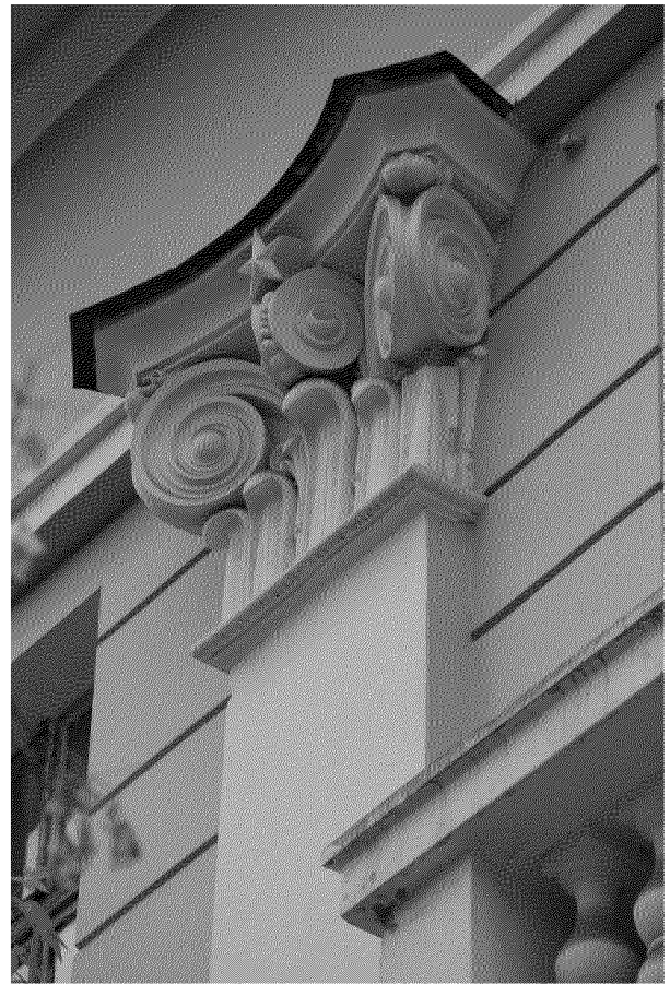
Видовая точка № 10 Фрагмент пилястры южного фасада
