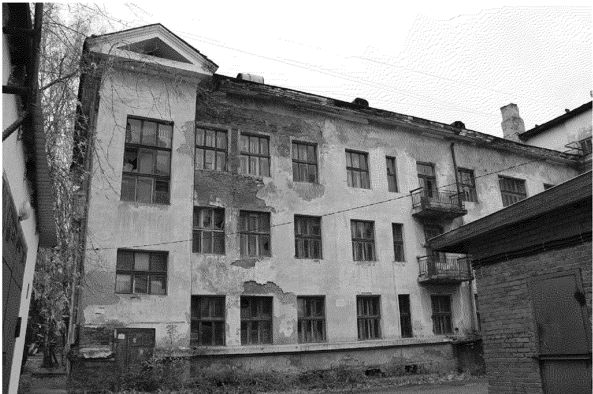
Видовая точка № 16 Дворовый северный фасад здания с ризалитом и балконами
