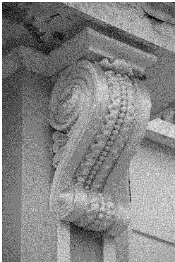
Видовая точка № 8 Кронштейн козырька портала главного входа
