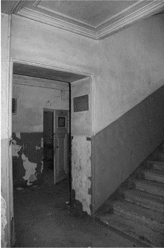
Видовая точка № 20 Штукатурный декор в отделке проёмов и площадки парадной лестницы (1 этаж)
