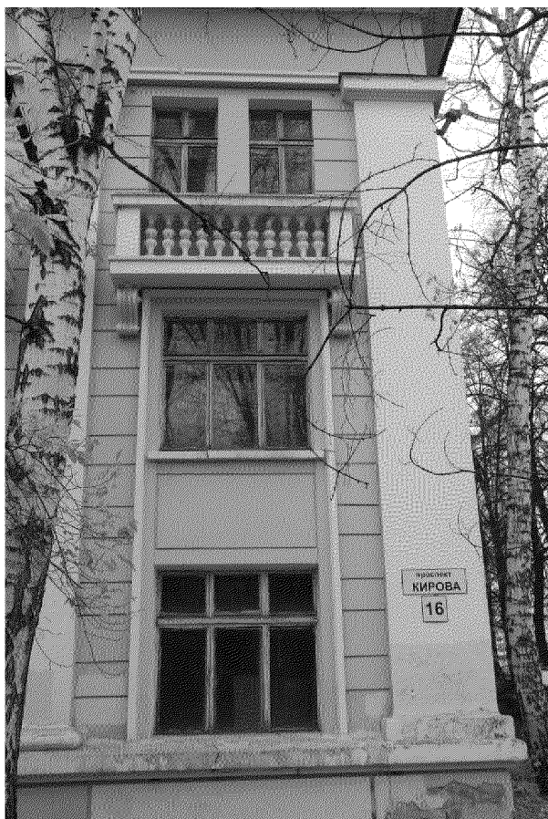
Видовая точка № 7 Фрагмент южного фасада
