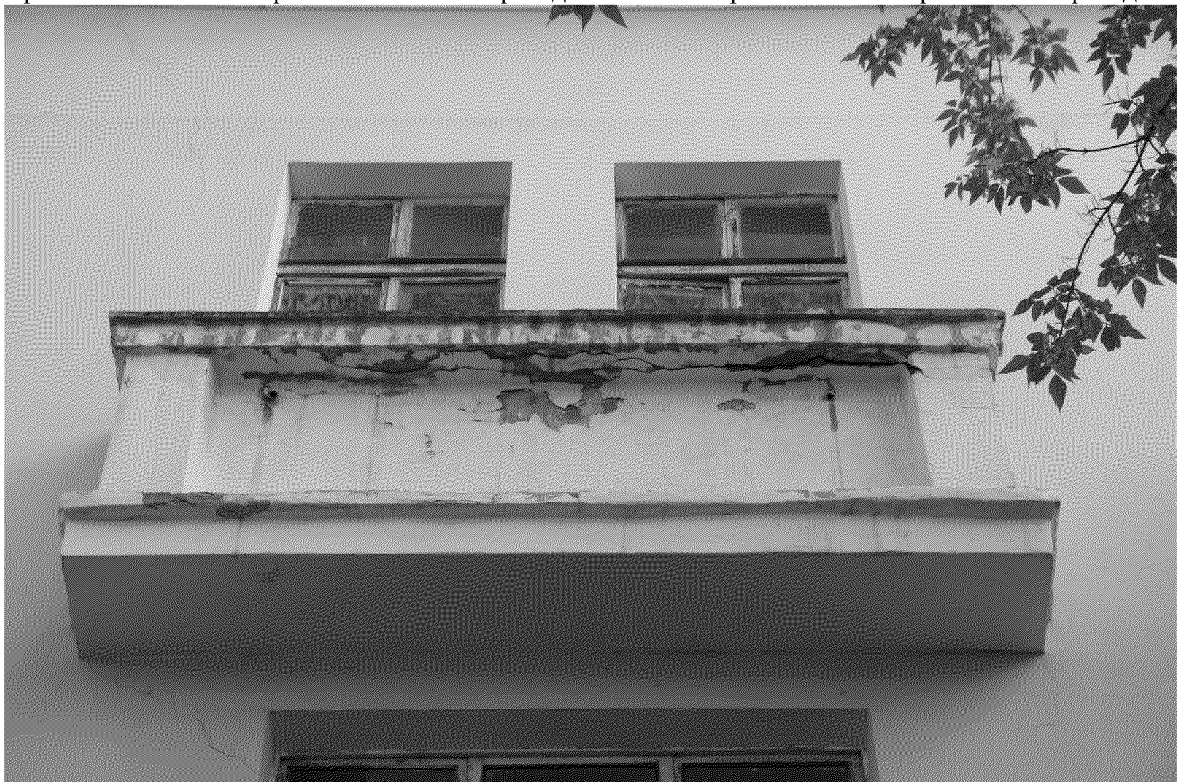
Видовая точка № 11 Балкон 3-го этажа западного фасада
