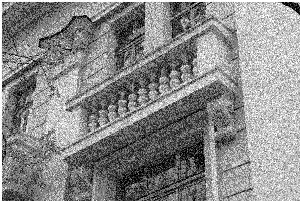
Видовая точка № 6 Фрагмент южного фасада (3-й этаж)
