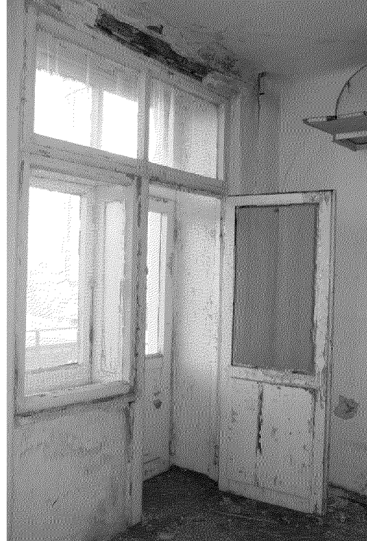
Видовая точка № 27 Балконная дверь помещения 2-го этажа
