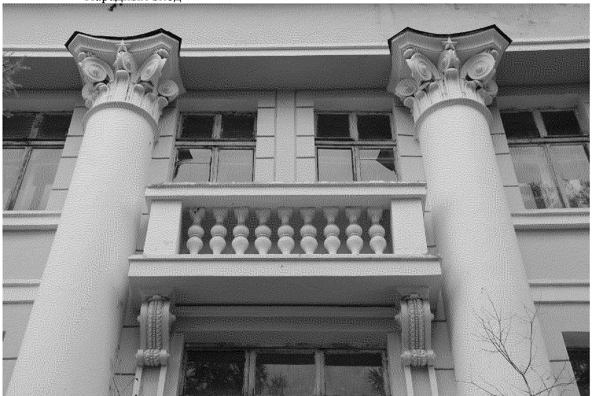
Видовая точка № 5 Фрагмент ризалита южного фасада (3-й этаж)
