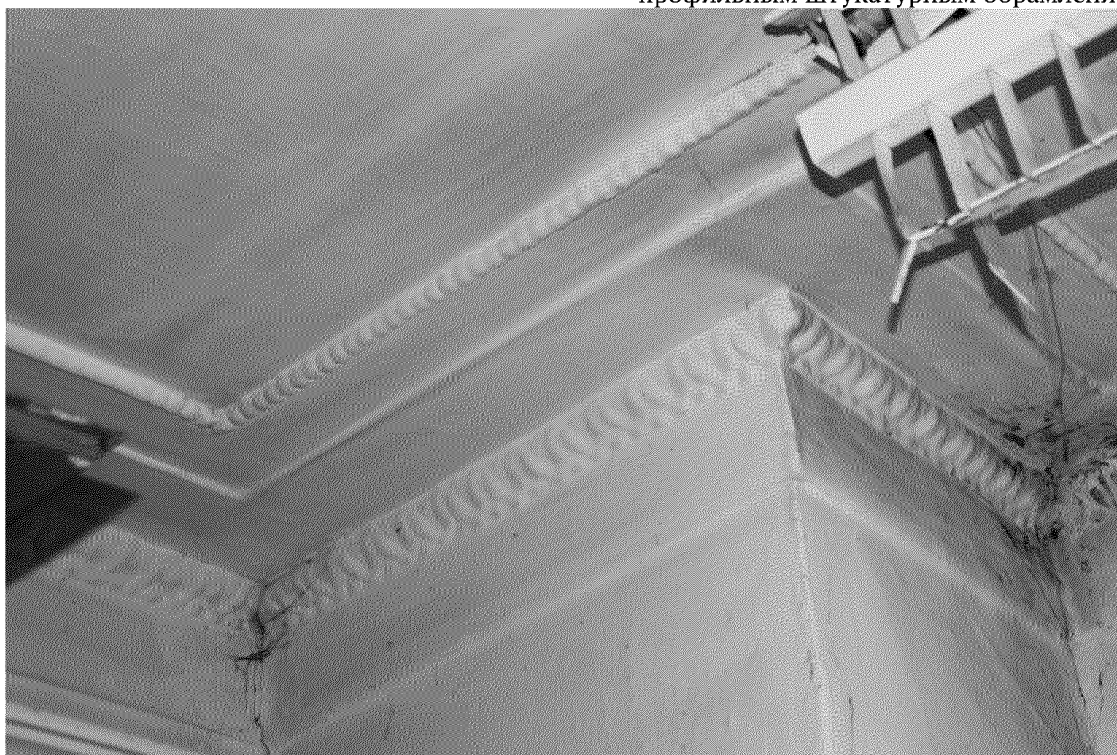
Видовая точка № 30 Потолочный карниз с лепным декором растительного орнамента в помещении 2-го этажа центральной части здания
