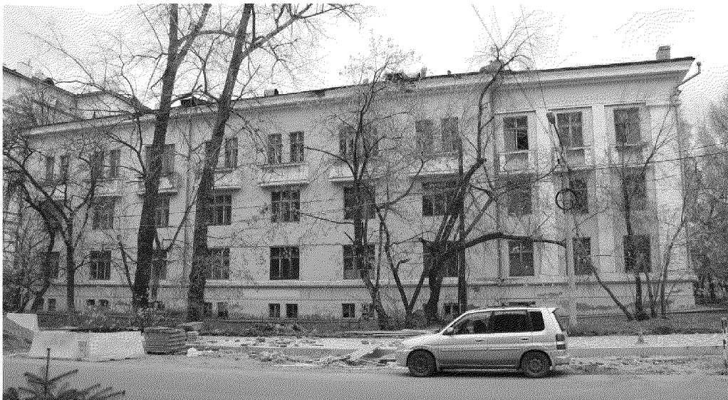
Видовая точка № 2 Западный фасад здания, вид с ул. Белинского
