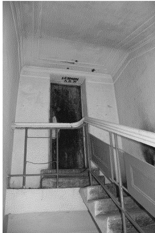
Видовая точка № 25 Лестница западного крыла здания (выход на чердак)
