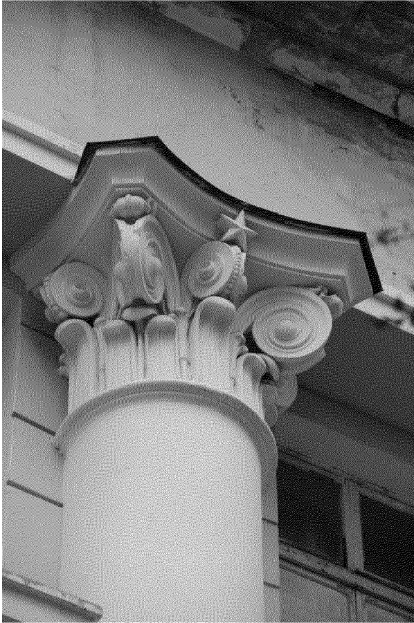
Видовая точка № 9 Фрагмент \frac{3}{4} колонны ризалита южного фасада
