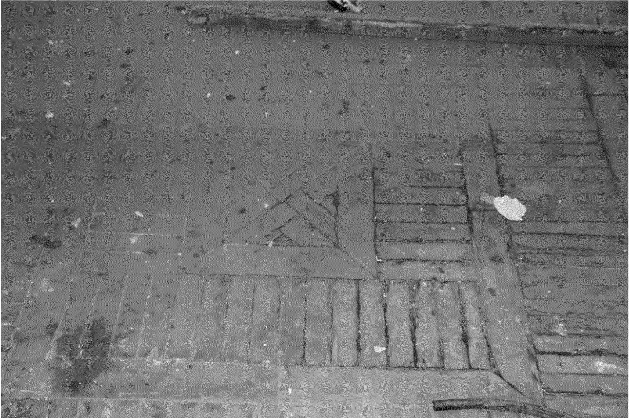
Видовая точка № 33 Паркетный пол в помещении 2-го этажа южной части здания
