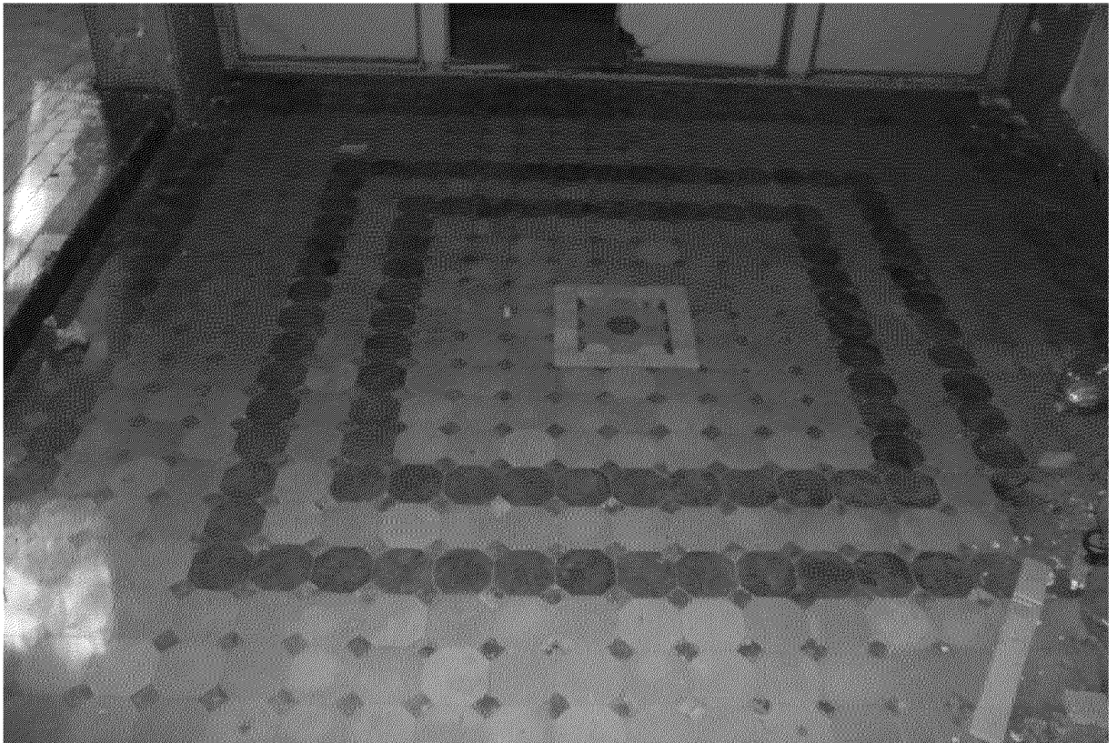
Видовая точка № 34 Покрытие пола из метлахской плитки в центральном помещении вестибюля
