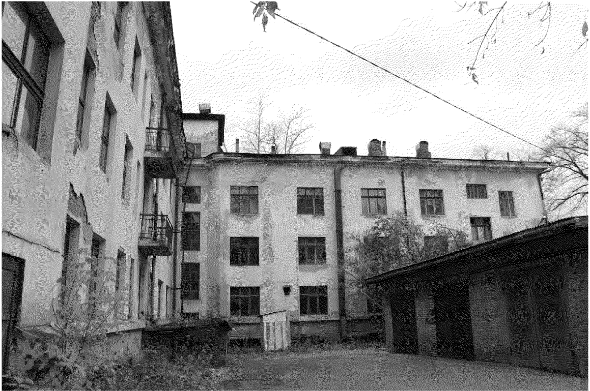
Видовая точка № 15 Дворовый восточный фасад здания
