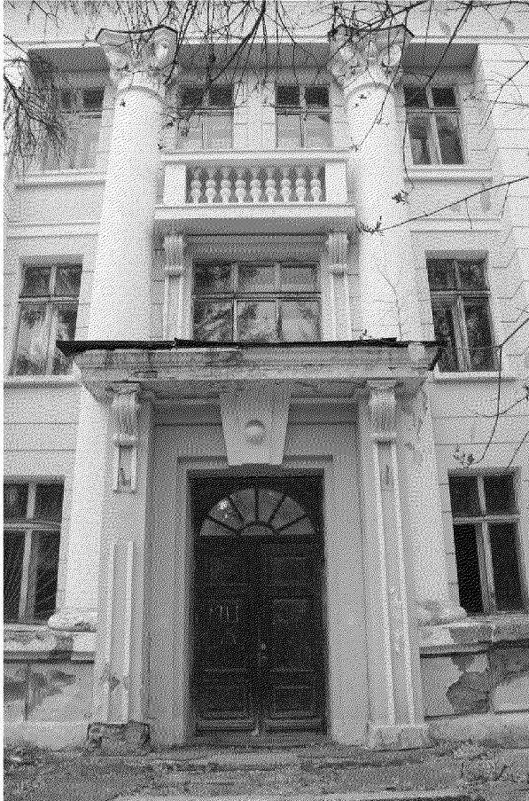
Видовая точка № 3 Фрагмент ризалита южного фасада. Парадный вход
