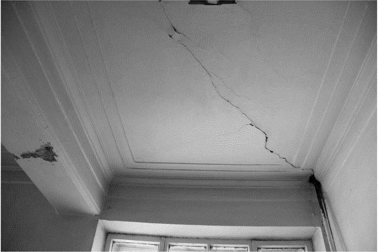
Видовая точка № 31 Фрагмент штукатурного карниза в отделке потолка коридора 3-го этажа
