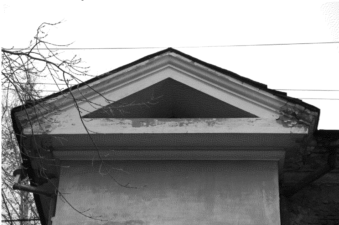
Видовая точка № 14 Фронтон ризалита дворового северного фасада
