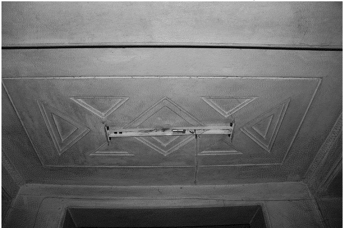
Видовая точка № 19 Декоративная отделка потолка коридора 1-го этажа при входе на парадную лестницу
