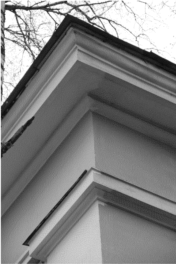
Видовая точка № 12 Фрагмент венчающего карниза и угловой пилястры
