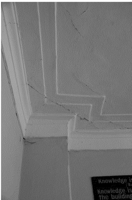
Видовая точка № 28 Фрагмент штукатурного карниза помещения
