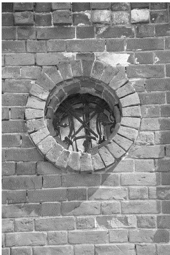
Видовая точка № 8. Набережная р. Томи, 27. Окно 2-го этажа (Яблонская М.А., 04.05.2022)
