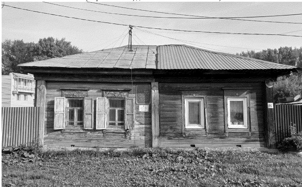
Видовая точка № 2. Главный южный фасад здания, 01.09.2022 г.
