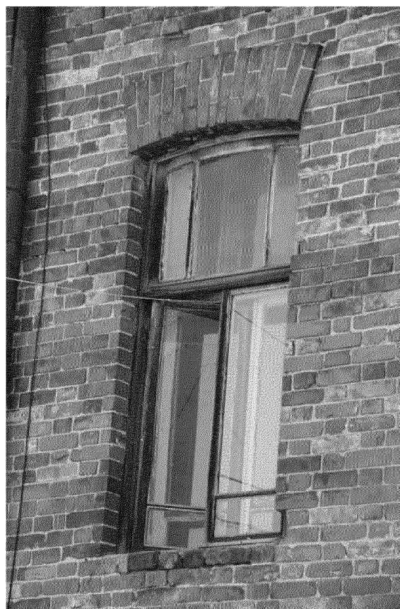
Видовая точка № 14. Окно второго этажа дворового фасада (Верховая К.Е., 09.04.2021 г.)
