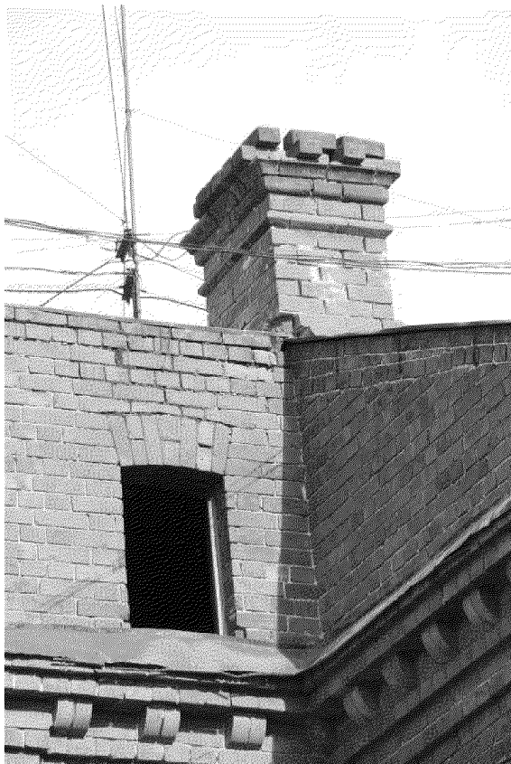
Видовая точка № 11. Фрагмент дворового фасада: карниз, слуховое окно и печная труба (Яблонская М.А., 2022 г.)
