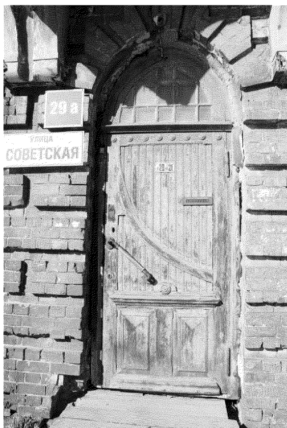
Видовая точка № 9. Дверь парадного входа с остекленной фрамугой главного фасада (Верховая К.Е., 09.04.2021 г.)
