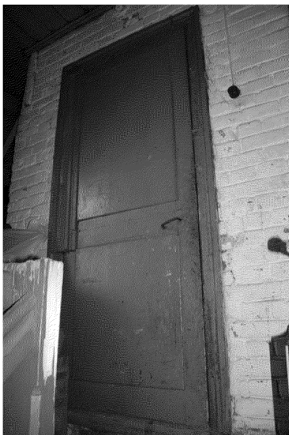
Видовая точка № 20. Деревянная дверь входа из пристройки в квартиру второго этажа (Яблонская М.А., 2022 г.)
