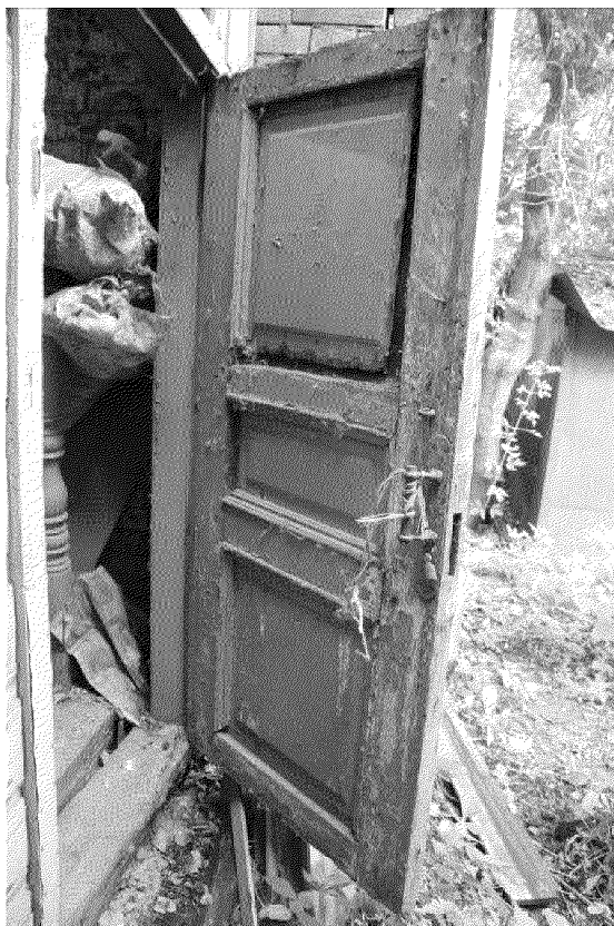
Видовая точка № 18. Деревянная дверь входа в дворовую пристройку (Рыжикова А.Ю., 2017 г.)
