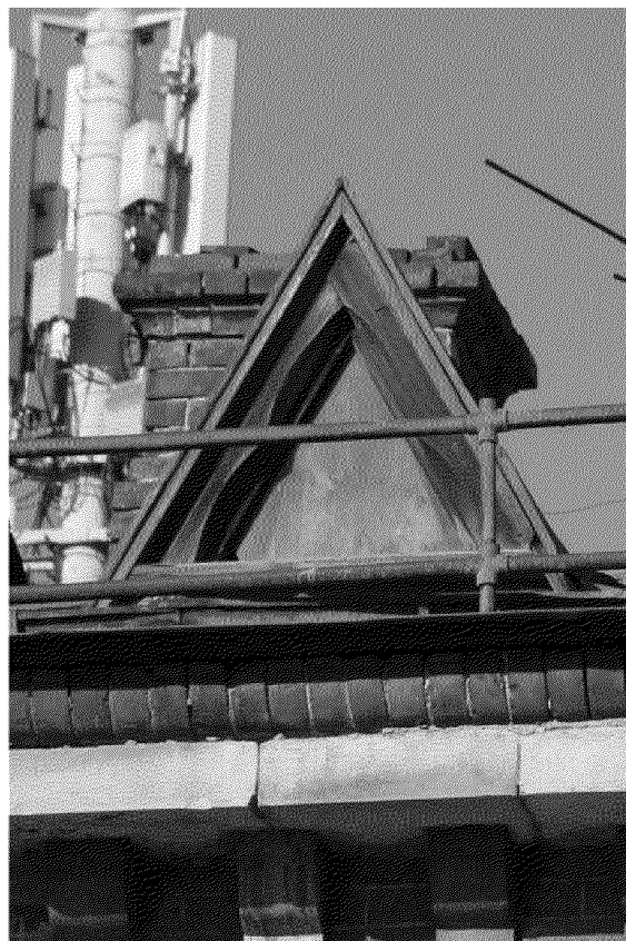
Видовая точка № 12. Слуховое окно восточного фасада и печная труба (Верховая К.Е., 09.04.2021 г.)
