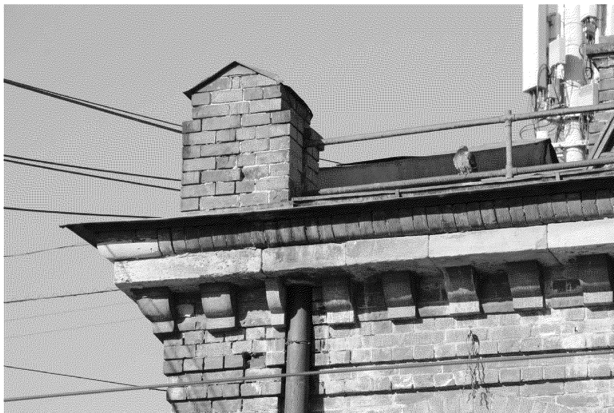
Видовая точка № 4. Фрагмент венчающего карниза главного фасада (Верховая К.Е., 09.04.2021 г.)
