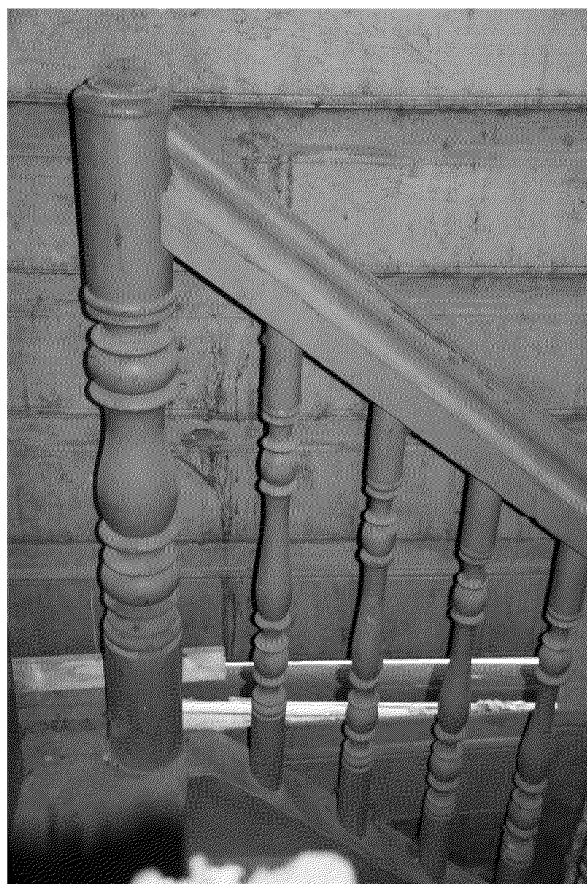
Видовая точка № 17. Фрагмент ограждения лестницы (Яблонская М.А., 2022 г.)
