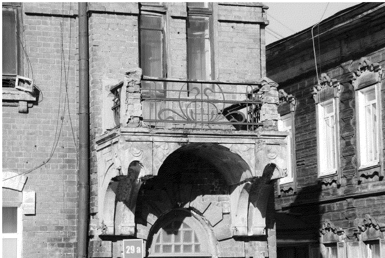
Видовая точка № 5. Балкон главного восточного фасада (Верховая К.Е., 09.04.2021 г.)
