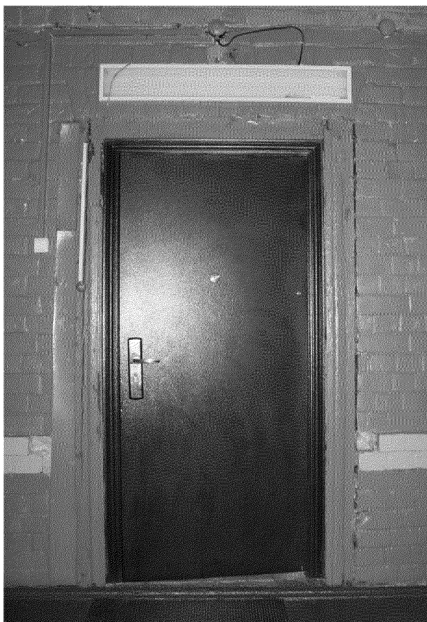
Видовая точка № 12. Вход на первый этаж основного объема, дверной проем с клинчатой перемычкой (Яблонская М.А., 25.05.2022 г.)
