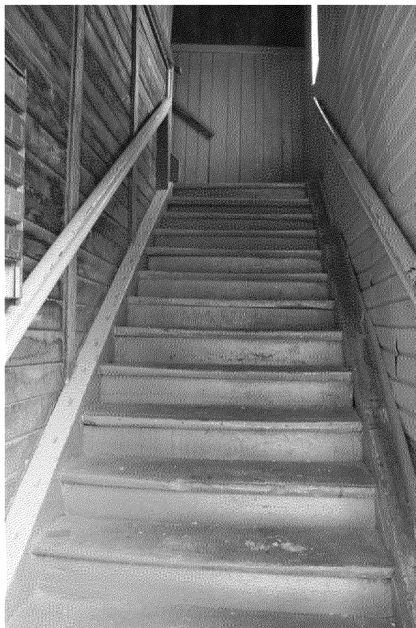
Видовая точка № 13. Деревянная Г-образная лестница на второй этаж (пристройка)
