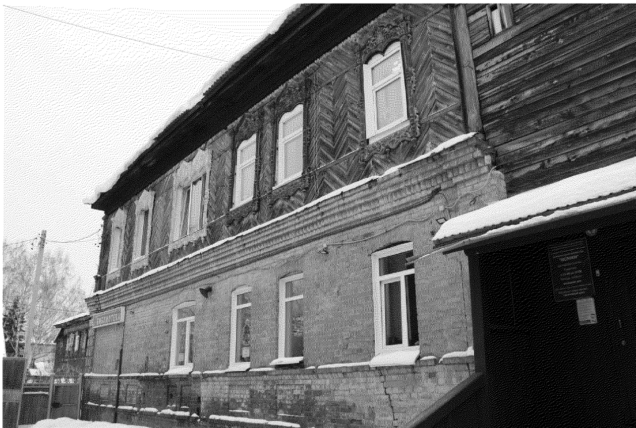
Видовая точка № 9. Боковой северный фасад здания (Олейник А.Ю., 03.12.2020 г.)
