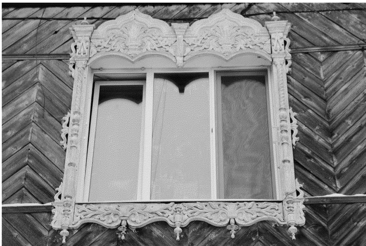
Видовая точка № 10. Наличник сдвоенного окна 2-го этажа северного фасада с резным декором (Яблонская М.А., 24.11.2021 г.)
