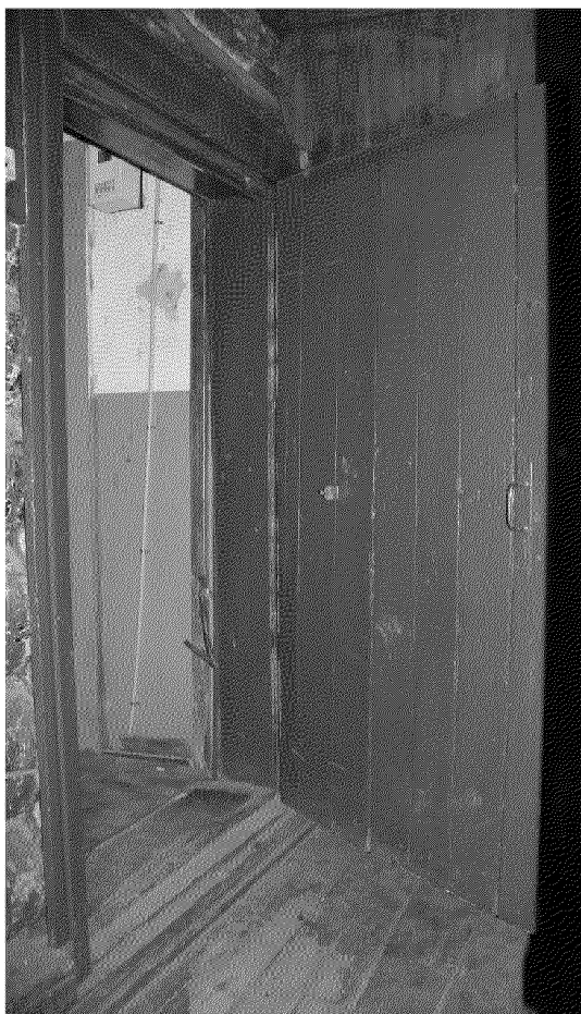
Видовая точка № 16. Дверной блок входной двери на второй этаж (Яблонская М.А., 25.05.2022 г.)
