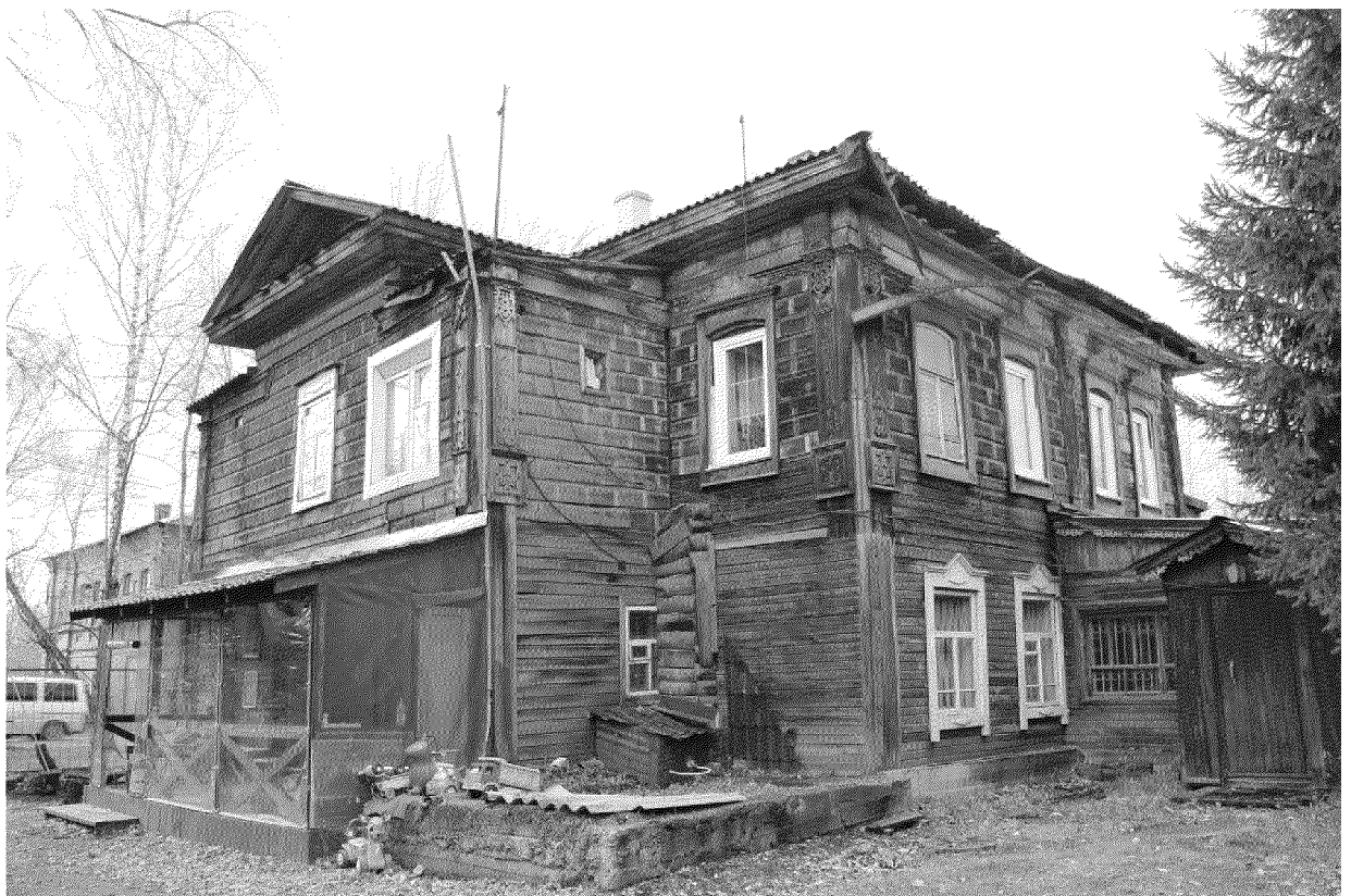
Видовая точка № 4. Общий вид дома с северо-восточной стороны
