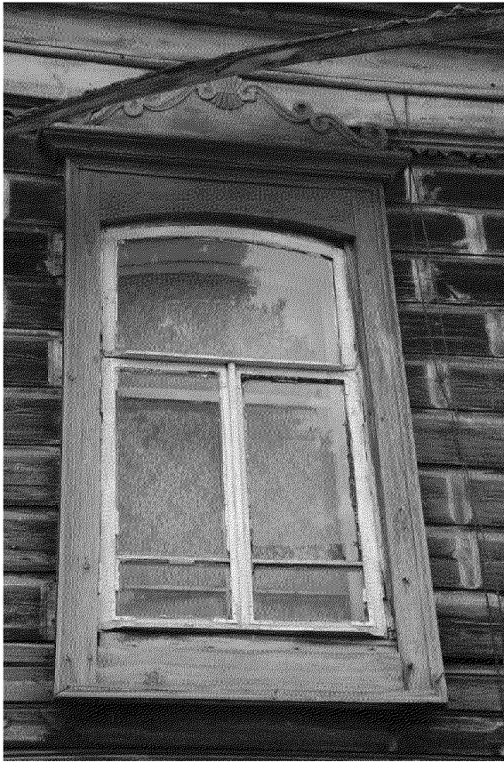
Видовая точка № 11. Окно 2-го этажа северного фасада с наличником
