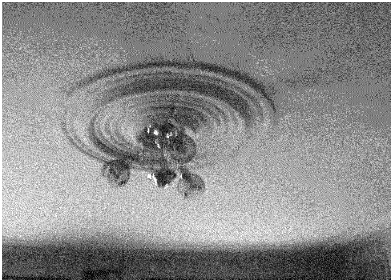
Видовая точка № 21. Профильная штукатурная потолочная розетка (Вакер И.С., 27.11.2014 г.)
