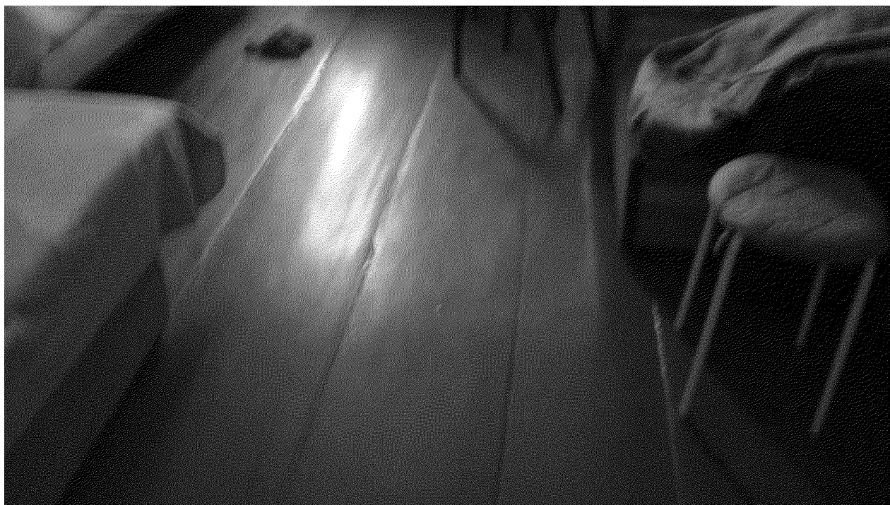
Видовая точка № 22. Покрытие пола из плах (Вакер И.С., 27.11.2014 г.)
