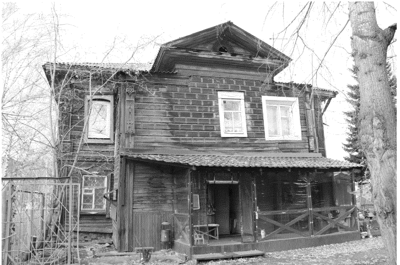
Видовая точка № 3. Боковой восточный фасад дома
