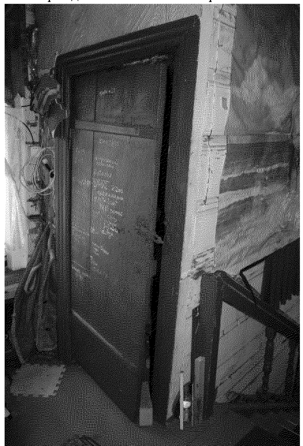
Видовая точка № 18. Деревянная дверь выхода на чердак
