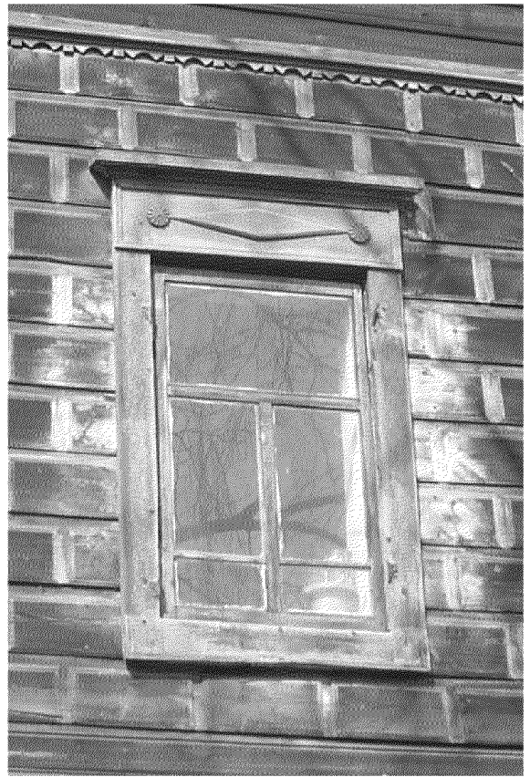
Видовая точка № 12. Окно 2-го этажа пристройки с наличником (Яблонская М.А., 2011 г.)
