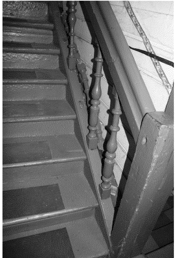
Видовая точка № 16. Ограждение лестничного марша из балясин
