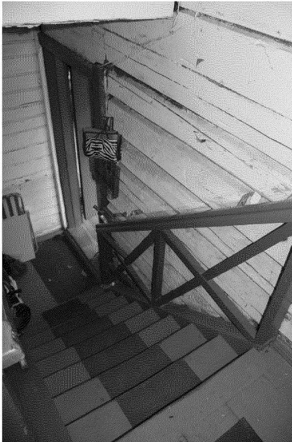
Видовая точка № 15. Деревянная лестница в прирубе
