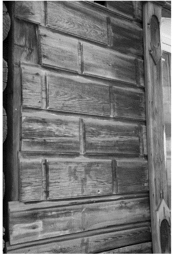
Видовая точка № 16. Фрагмент рустованной обшивки фасада
