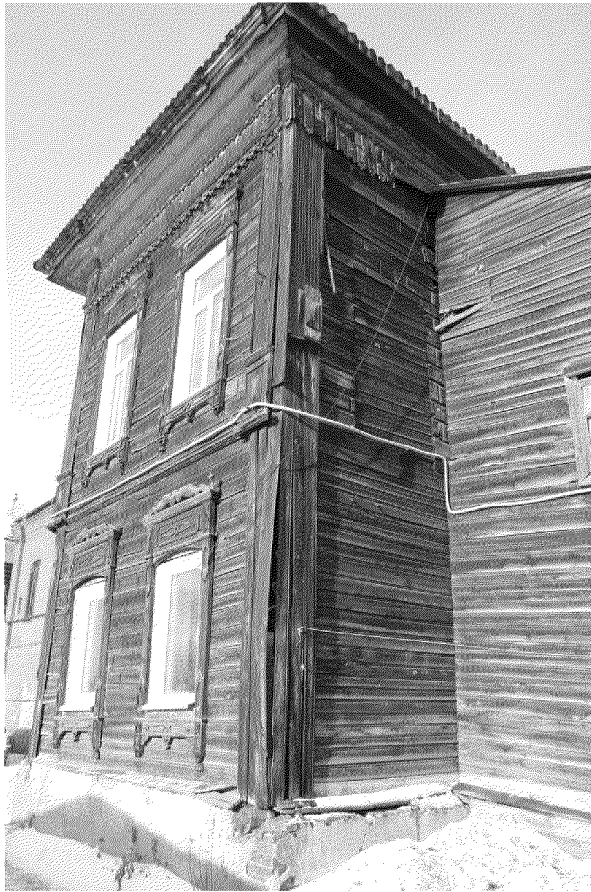
Видовая точка № 5. Дворовый фасад западного крыла
