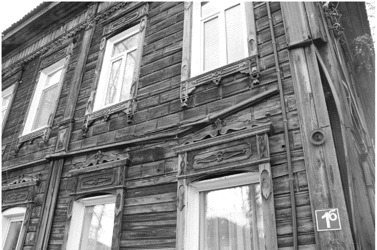
Видовая точка № 17. Фрагмент главного фасада, рустованная обшивка, профильный междуэтажный пояс (Лырова Е.В., 2019 г.)
