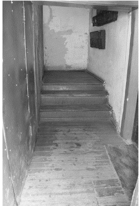
Видовая точка № 19. Фрагмент помещения лестницы восточного дворового крыла
