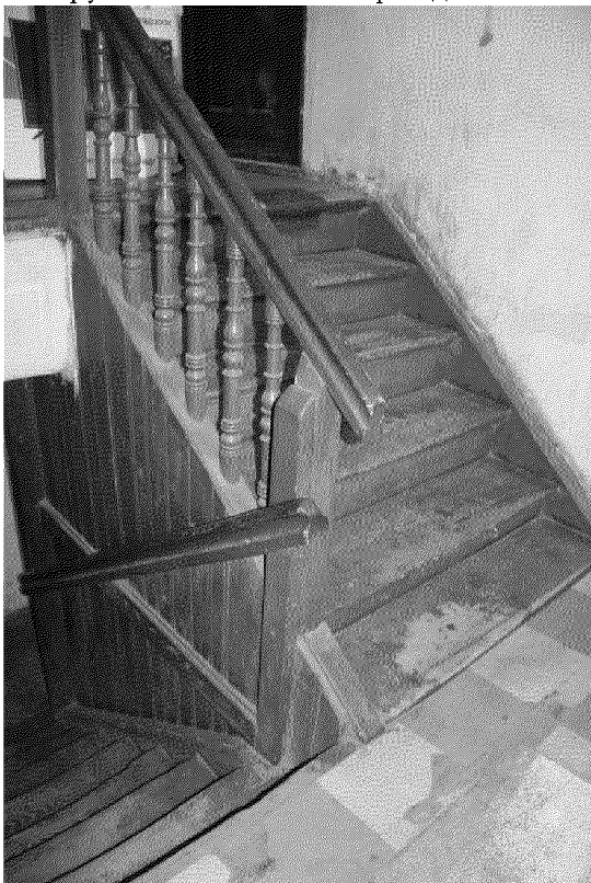
Видовая точка № 20. Деревянная лестница восточного дворового крыла с ограждением из балясин
