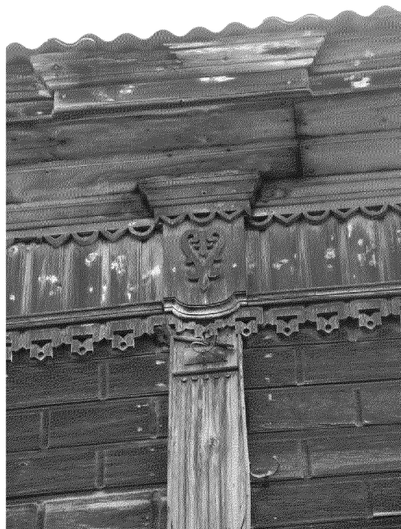
Видовая точка № 11. Венчающий карниз с двухъярусным резным фризом, рустованная обшивка, фрагмент декора пилястры (Лырова Е.В., 2019 г.)
