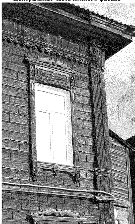
Видовая точка № 10. Фрагмент дворового фасада: наличник окна 2-го этажа с накладной резьбой тонкого рисунка, венчающий карниз с фризом, рустованная обшивка (Лырова Е.В., 2019 г.)
