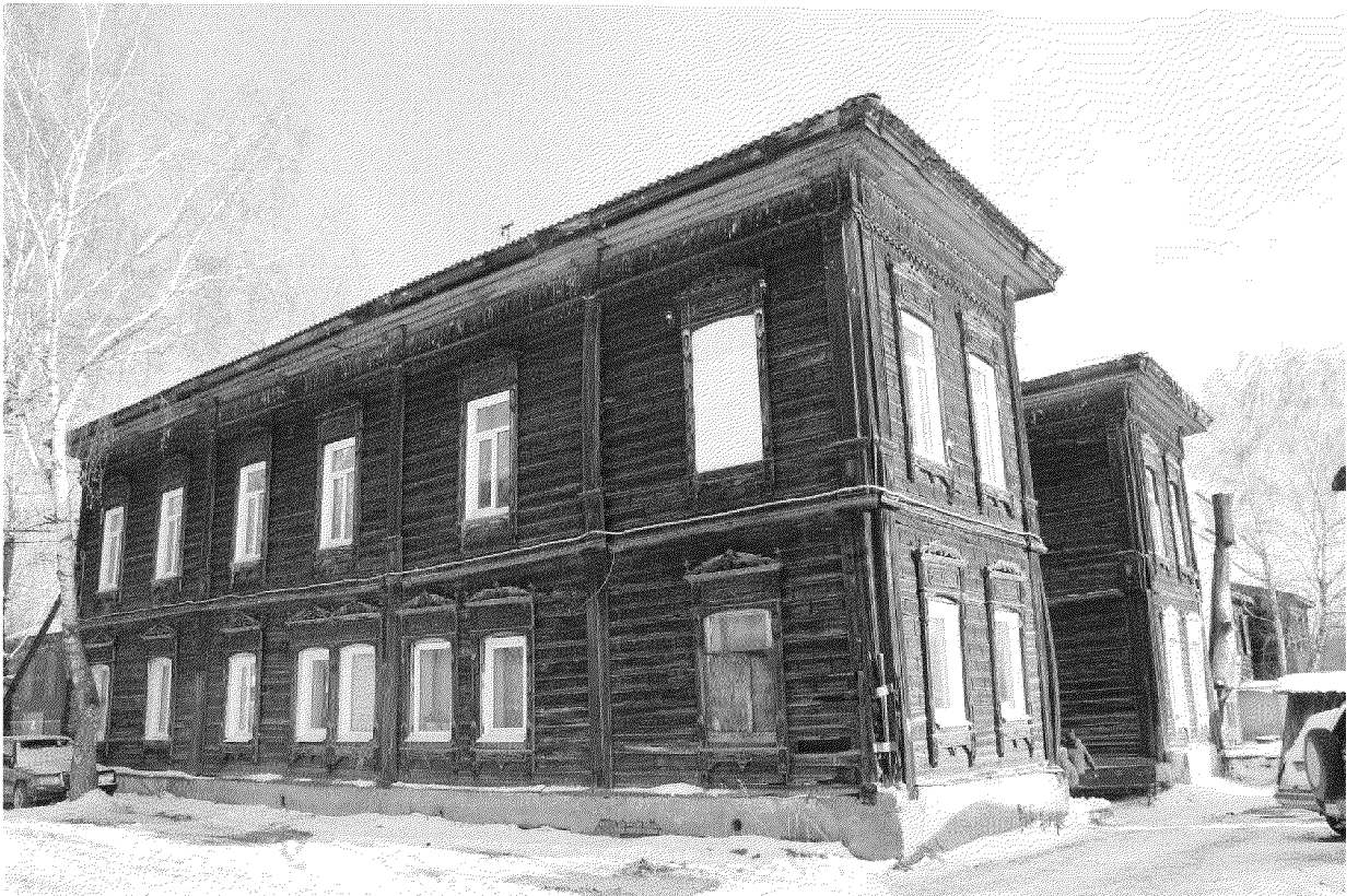
Видовая точка № 4. Общий вид дома с юго-западной стороны (с территории двора)
