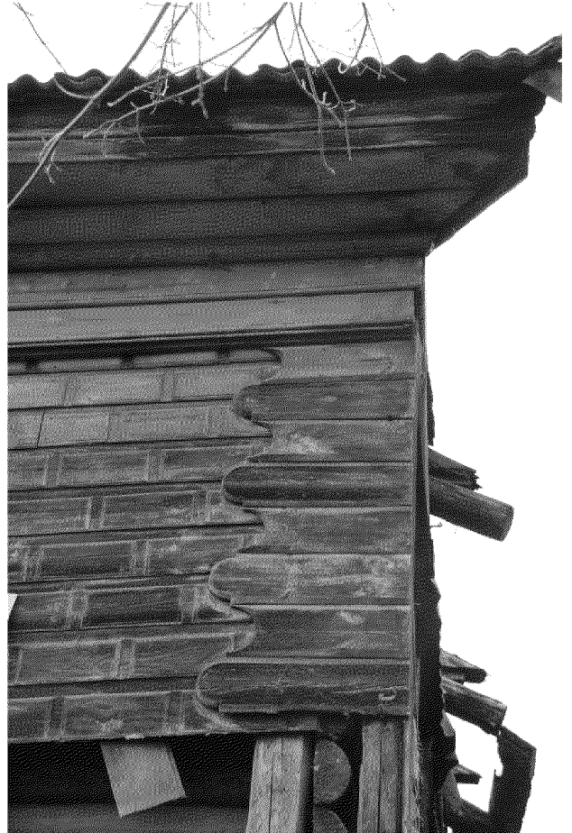
Видовая точка № 8. Фрагмент восточного фасада: профильный карниз, рустованная обшивка фасада, лопатка из фигурной обшивки
