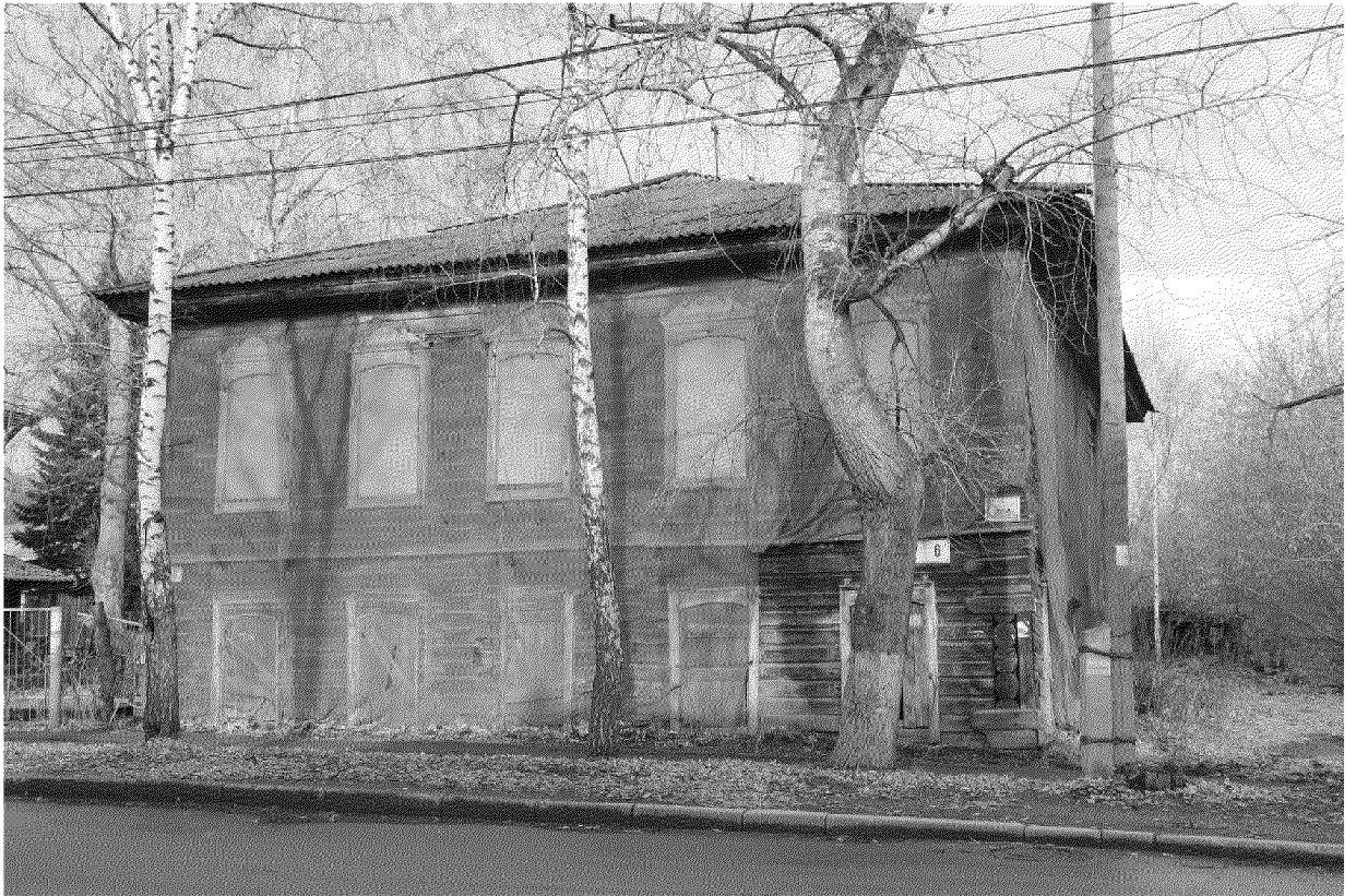
Видовая точка № 3. Главный южный фасад здания
