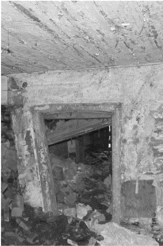
Видовая точка № 10. Коробка лучковой двери 1-го этажа (Яблонская М.А., 25.10.2021)
