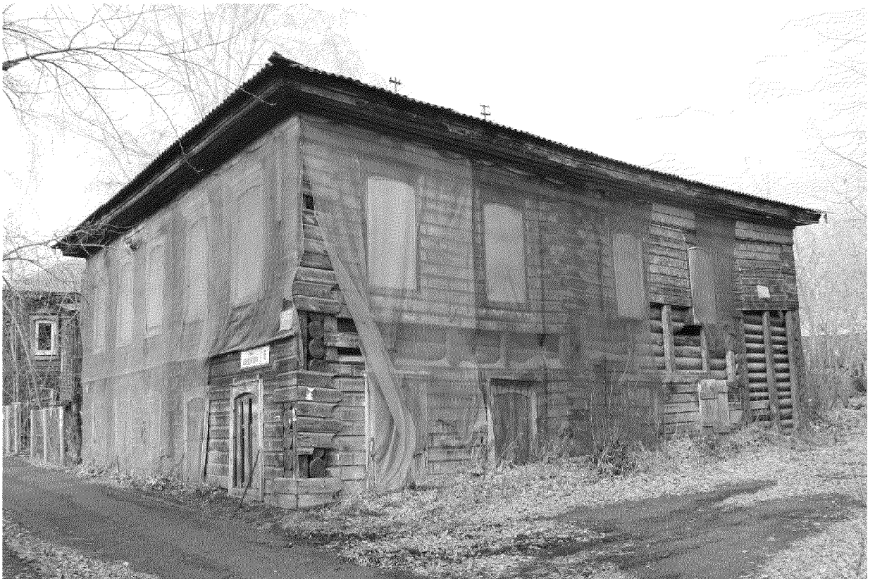
Видовая точка № 4. Боковой восточный фасад здания
