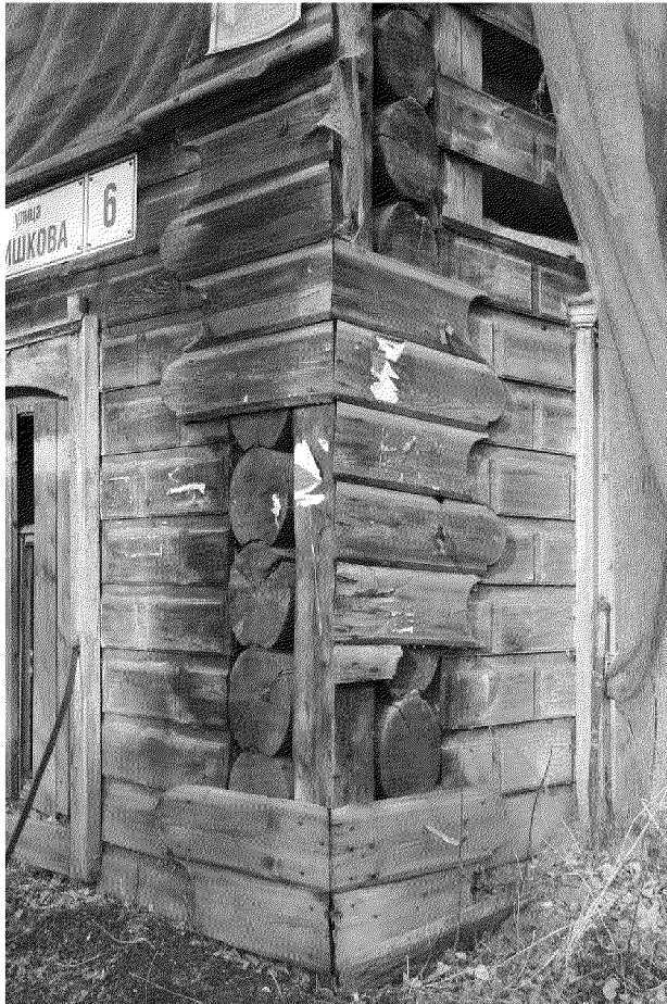
Видовая точка № 7. Фрагмент угловой лопатки из фигурной обшивки, междуэтажный пояс
