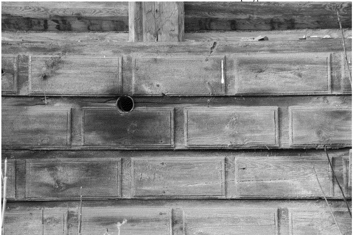
Видовая точка № 9. Рустованная обшивка бревенчатых стен сруба
