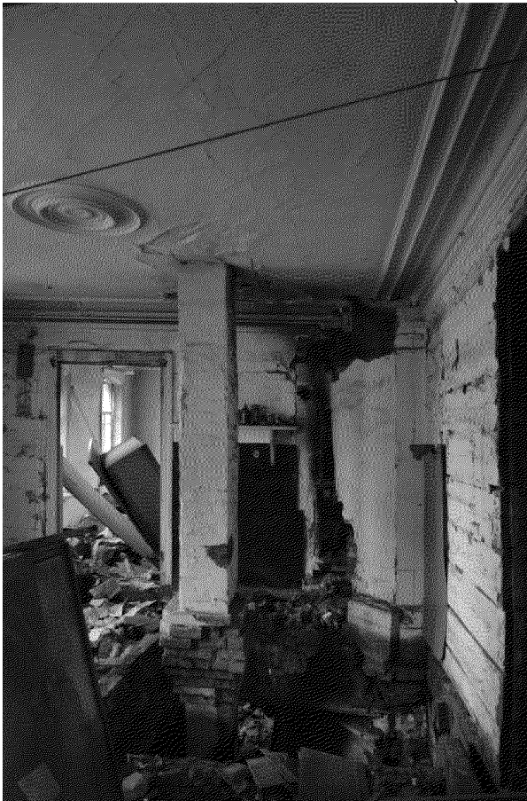
Видовая точка № 15. Помещение 2 этажа. Угловая печь и элементы штукатурного декора (ТГАСУ, 2012 г.)
