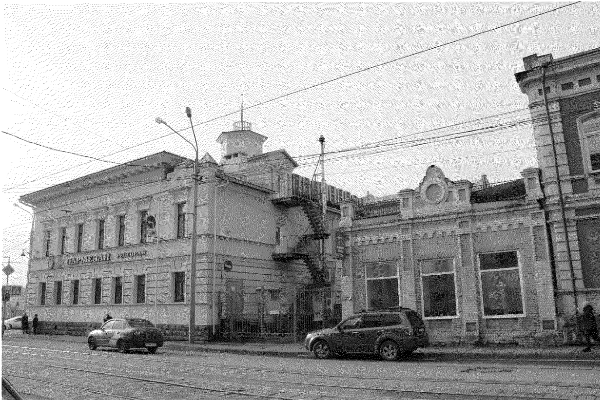
Видовая точка № 8. Общий вид здания с северо-восточной стороны, с ул. Розы Люксембург
