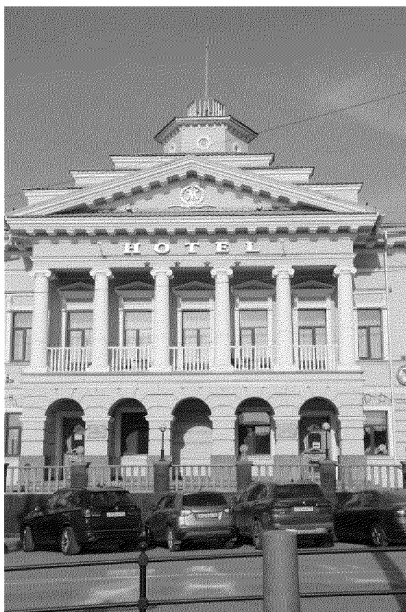
Видовая точка № 6. Центральный ризалит главного фасада
