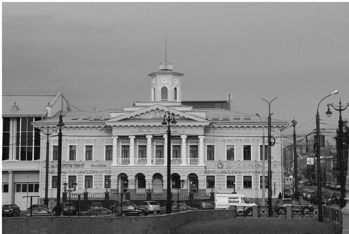
Видовая точка № 5. Главный южный фасад здания
