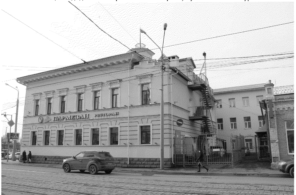
Видовая точка № 9. Восточный фасад здания, вид с ул. Розы Люксембург
