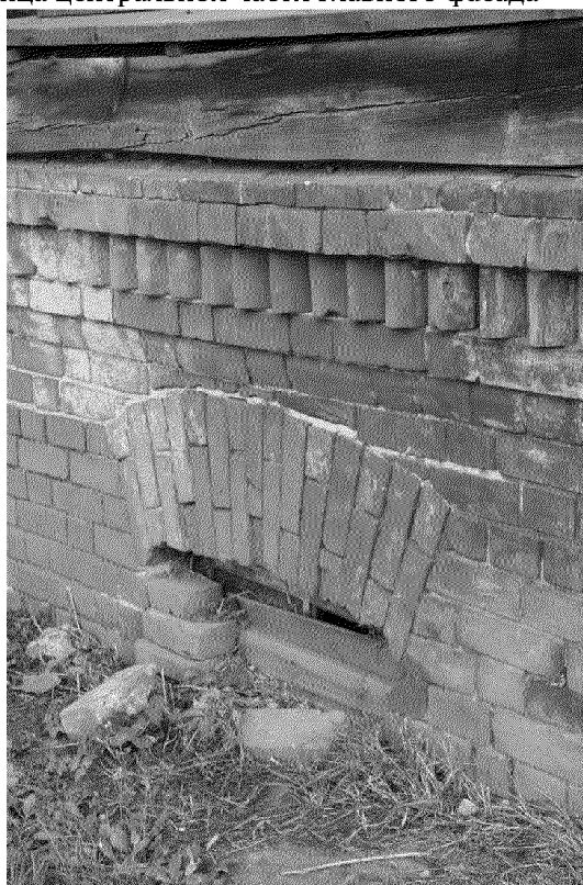
Видовая точка № 8. А. Иванова ул., 2а. Фрагмент цокольной части восточного фасада
