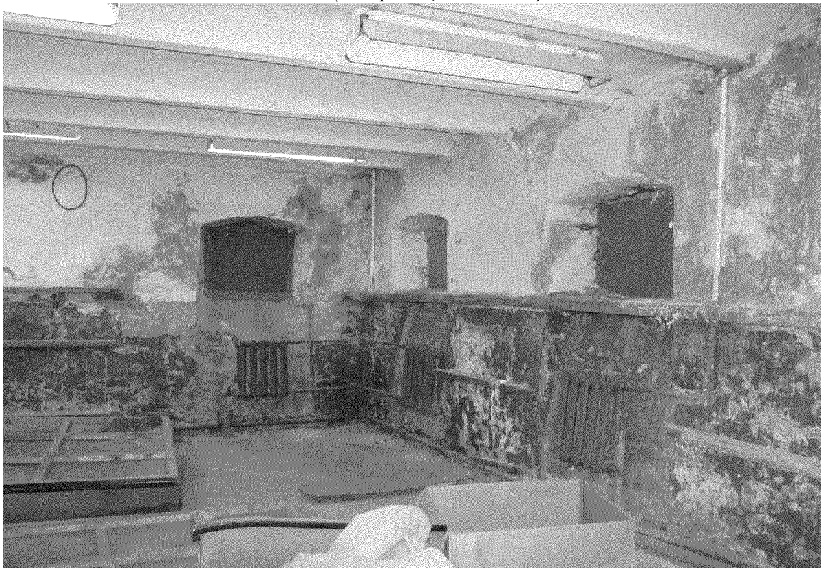
Видовая точка № 35 А. Иванова ул., 2/1. Общий вид помещения подвала с перекрытием из кирпичных сводов (Вакер И.С., 11.12. 2012)
