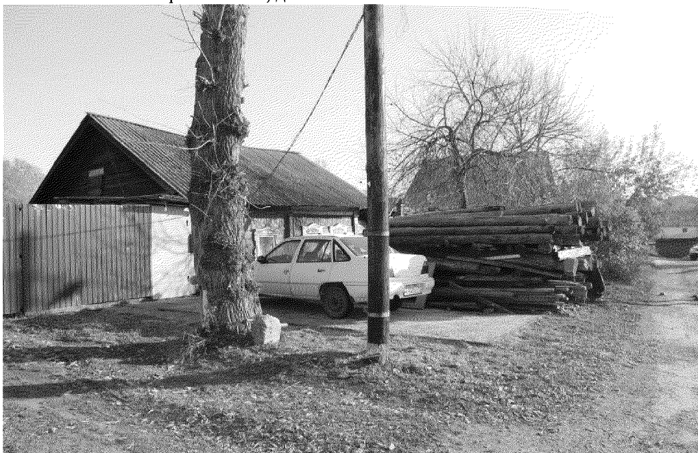
Видовая точка № 1. Общий вид здания с юго-западной стороны (с пер. Красного Пожарника)
