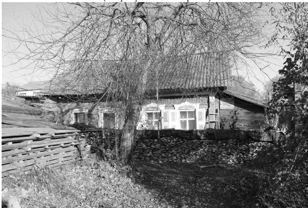
Видовая точка № 2. Главный южный фасад здания
