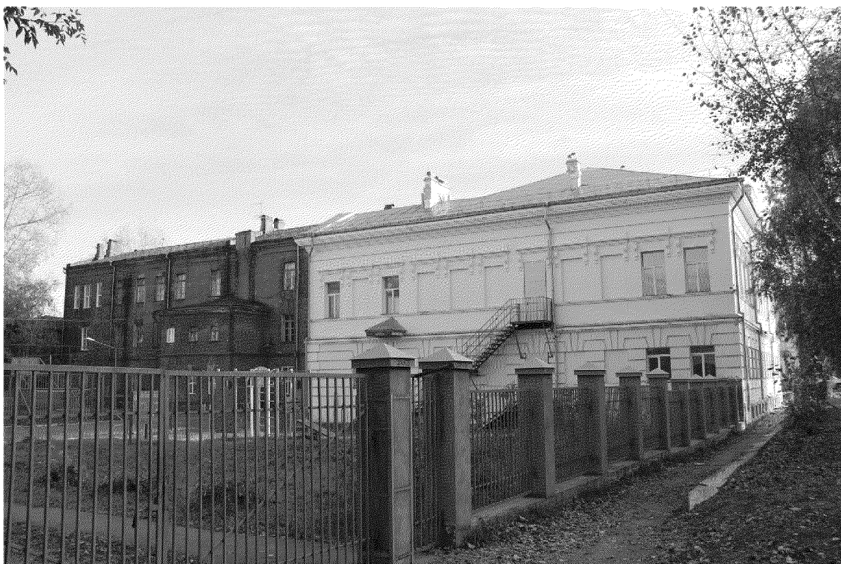
Видовая точка № 5 Северный фасад здания
