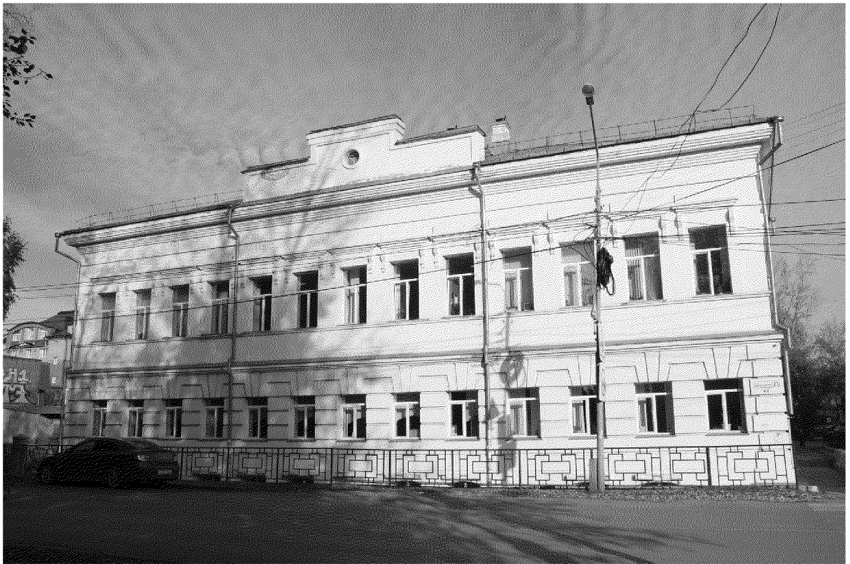
Видовая точка № 3 Главный западный фасад здания, вид с ул. К. Маркса
