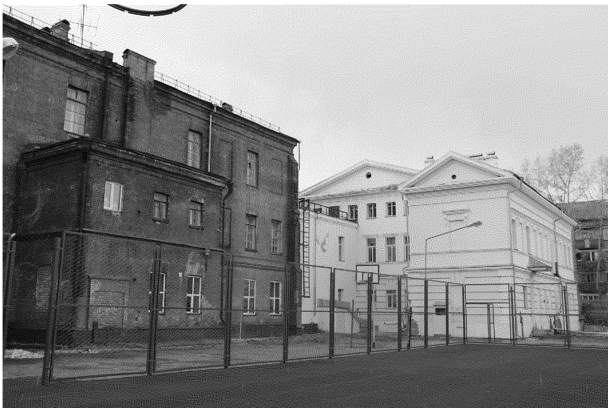
Видовая точка № 6 Дворовый восточный фасад здания (дата съемки: 29.04.2015 г.)
