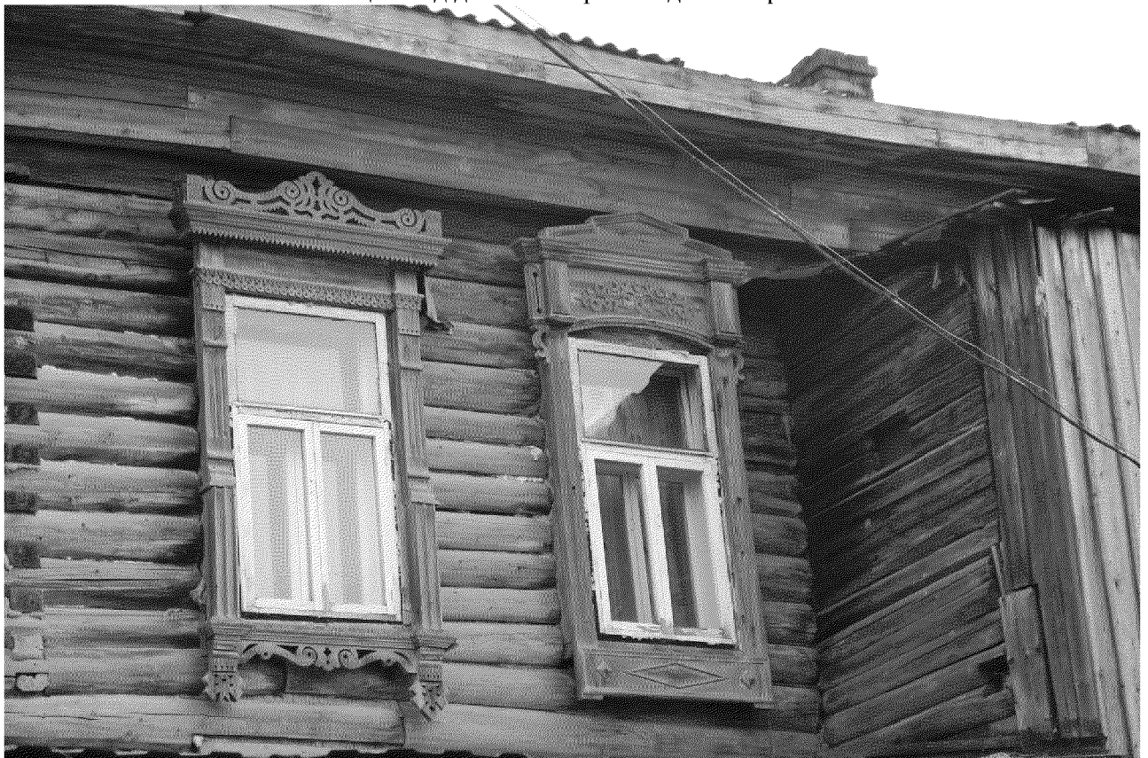
Видовая точка № 10. Фрагмент северного фасада, окна 2-го этажа с наличниками (крайний правый наличник перенесен с проема 1-го этажа), бревенчатая пристройка лестничного блока
