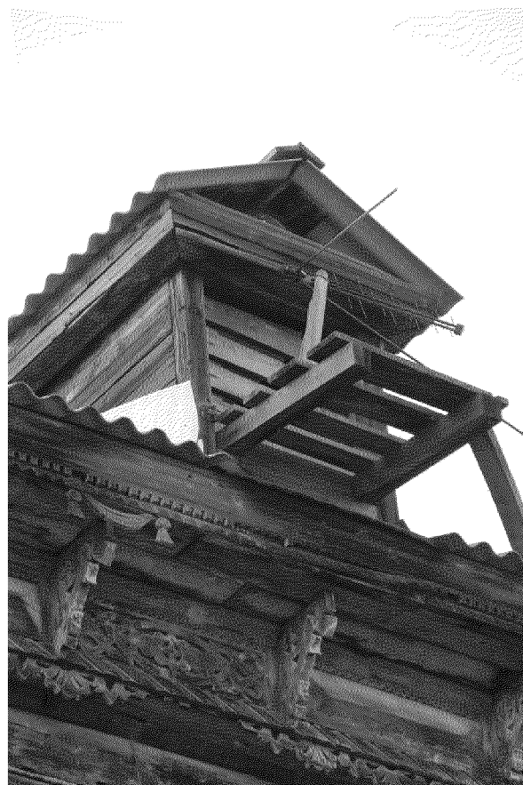
Видовая точка № 12. Слуховое окно со стороны восточного фасада
