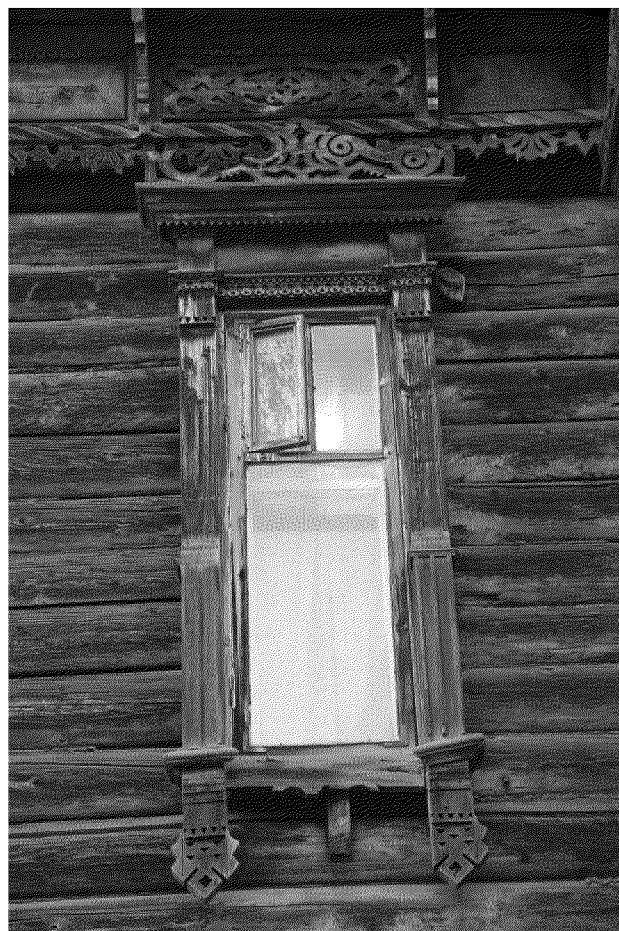
Видовая точка № 7. Окно 2-го этажа южного фасада с наличником
