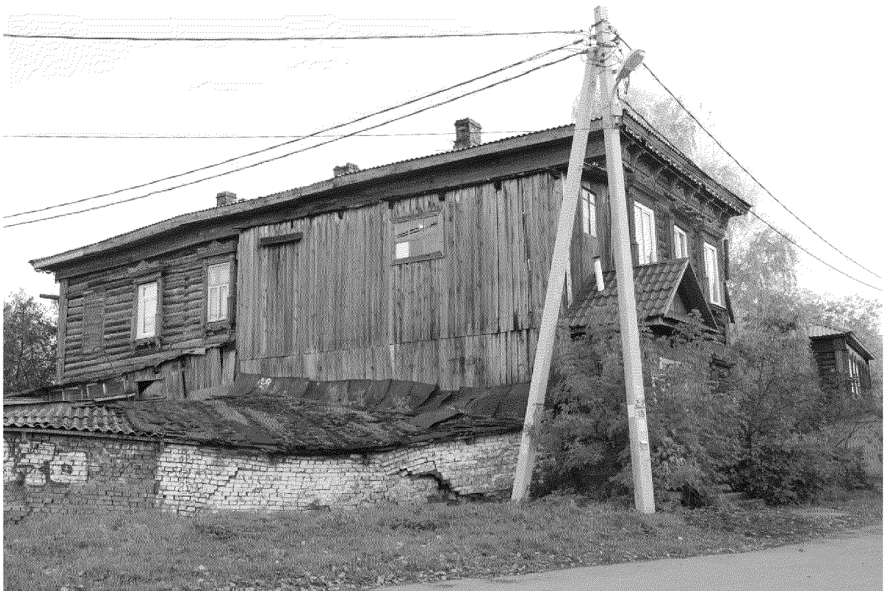
Видовая точка № 9. Общий вид дома с северо-западной стороны
