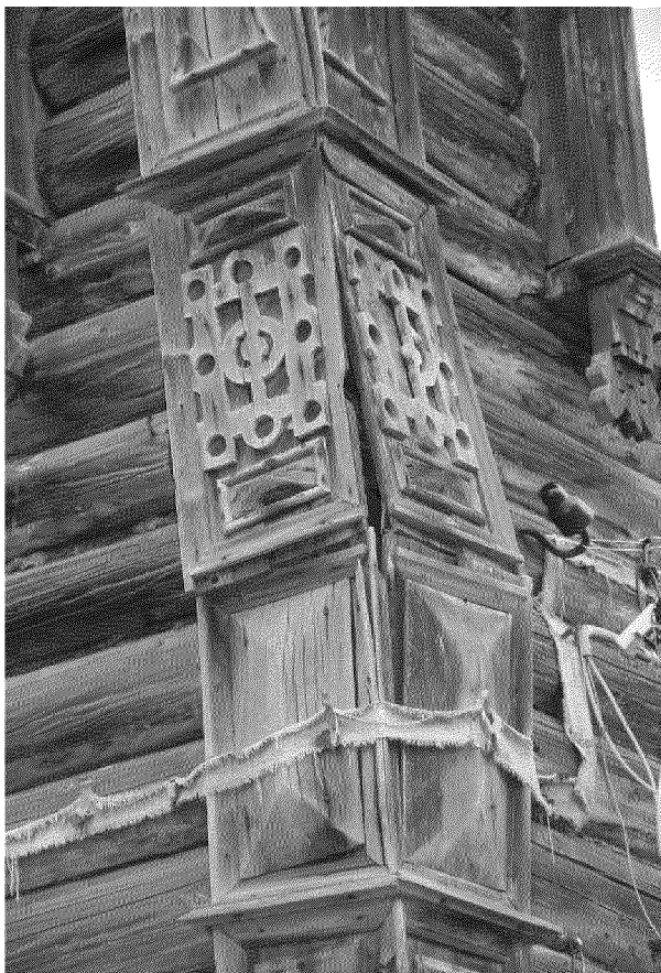
Видовая точка № 11. Фрагмент декора угловой пилястры южного фасада
