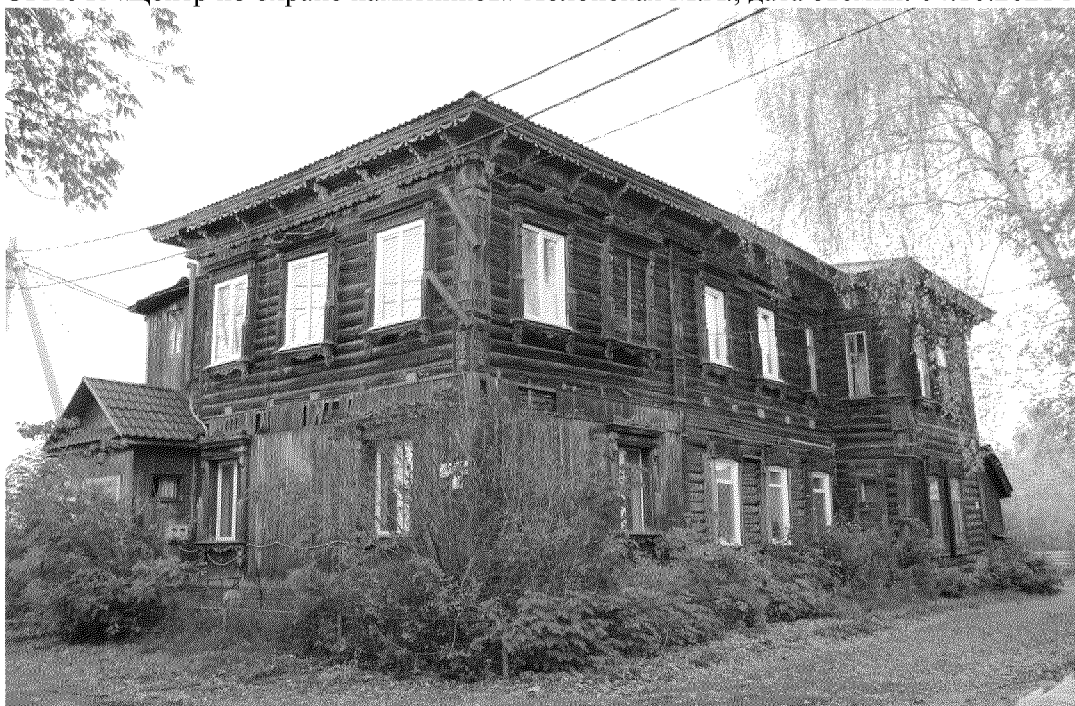
Видовая точка № 1. Общий вид дома с улицы М.Горького
