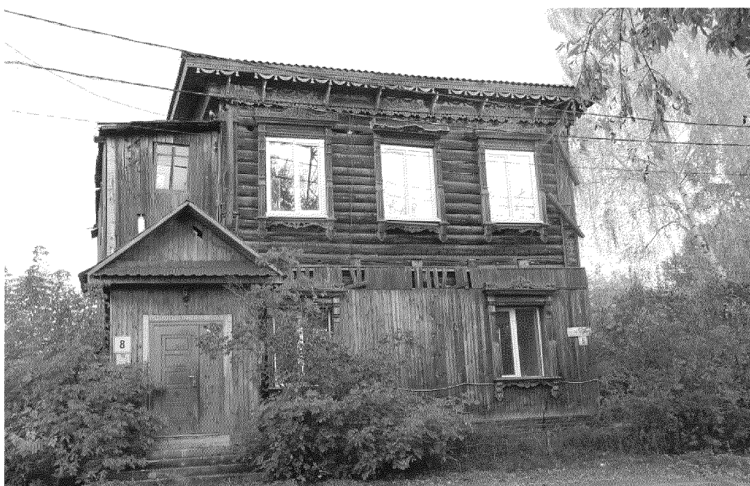
Видовая точка № 2. Главный западный фасад
