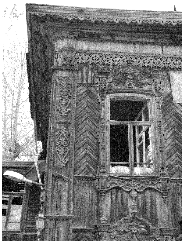
Видовая точка № 7. Фрагмент дворового восточного фасада (Олейник А.Ю., 02.10.2020 г.)
