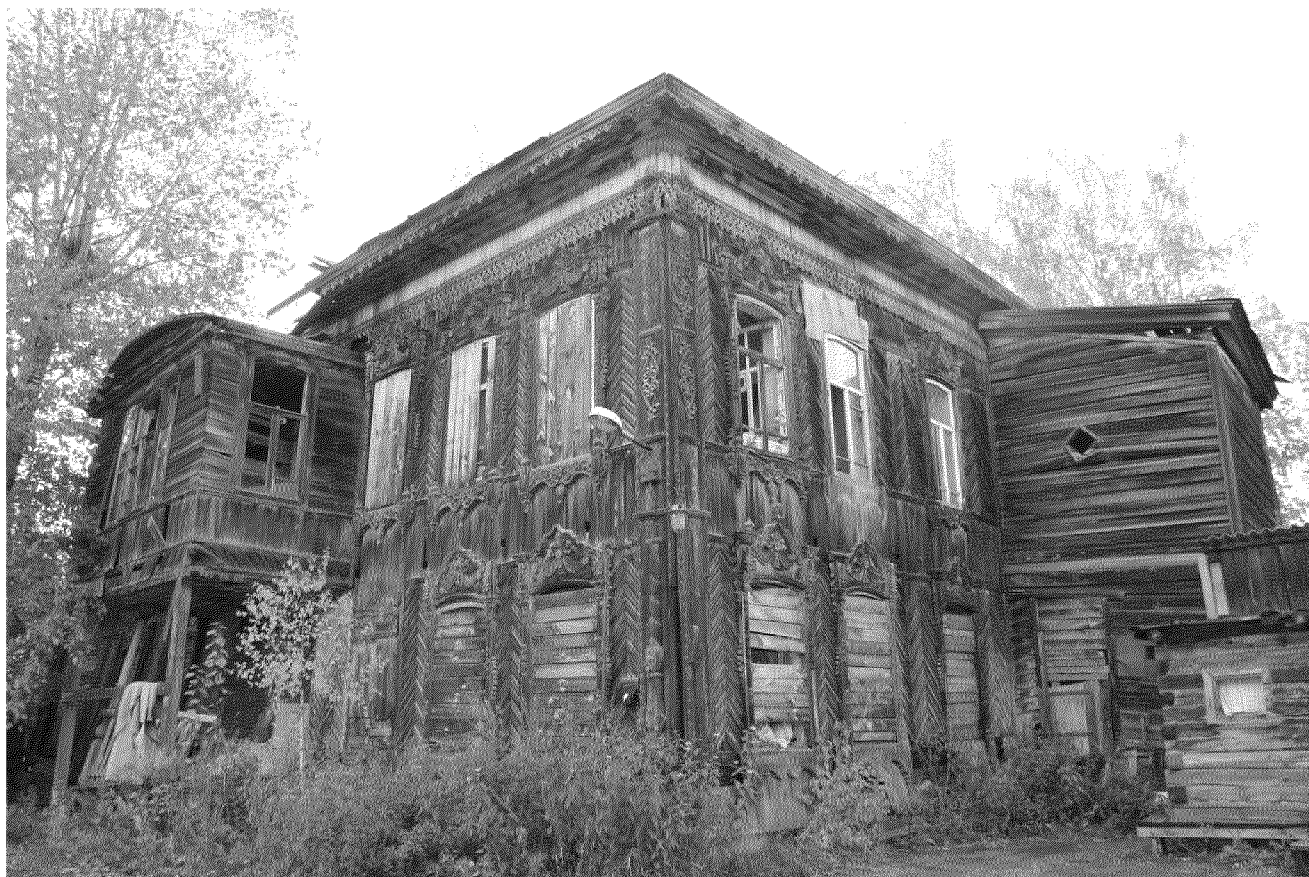
Видовая точка № 6. Общий вид дома с юго-восточной стороны (со двора) (Яблонская М.А., 04.10.2021)
