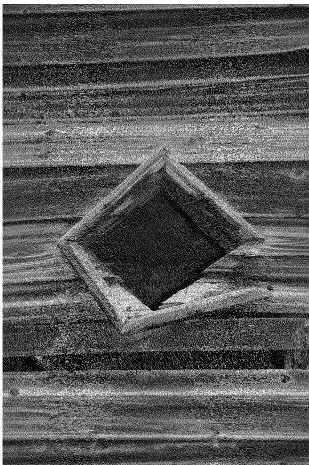
Видовая точка № 16. Оконное отверстие дворовой пристройки (Яблонская М.А., 04.10.2021)
