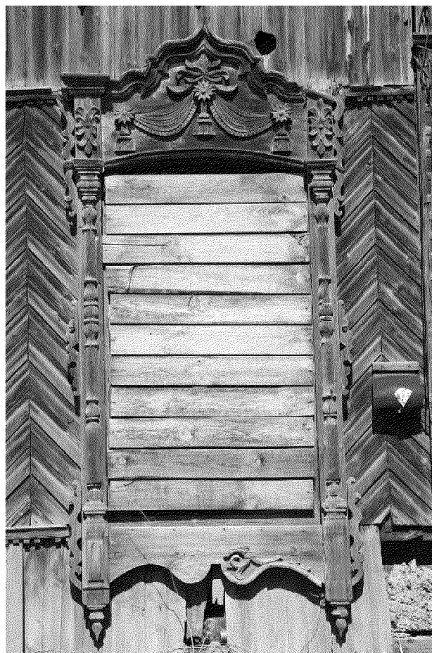
Видовая точка № 17. Наличник окна 1-го этажа западного фасада (Лырова Е.В., 16.05.2019 г.)
