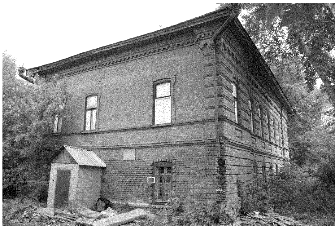
Видовая точка № 2. Западный фасад здания (Яблонская М.А., 12.09.2018 г.)
