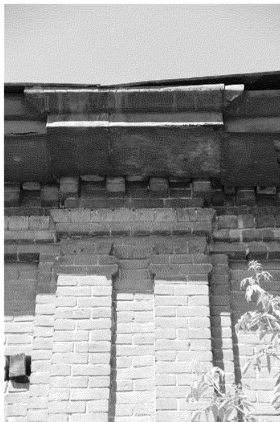
Видовая точка № 9. Фрагмент карниза южного фасада (29.06.2021 г.)
