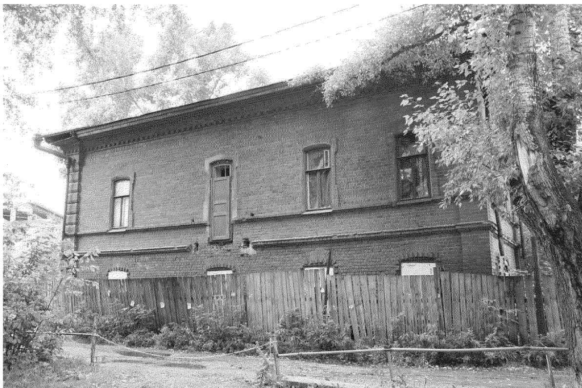
Видовая точка № 4. Восточный фасад (Яблонская М.А., 12.09.2018 г.)
