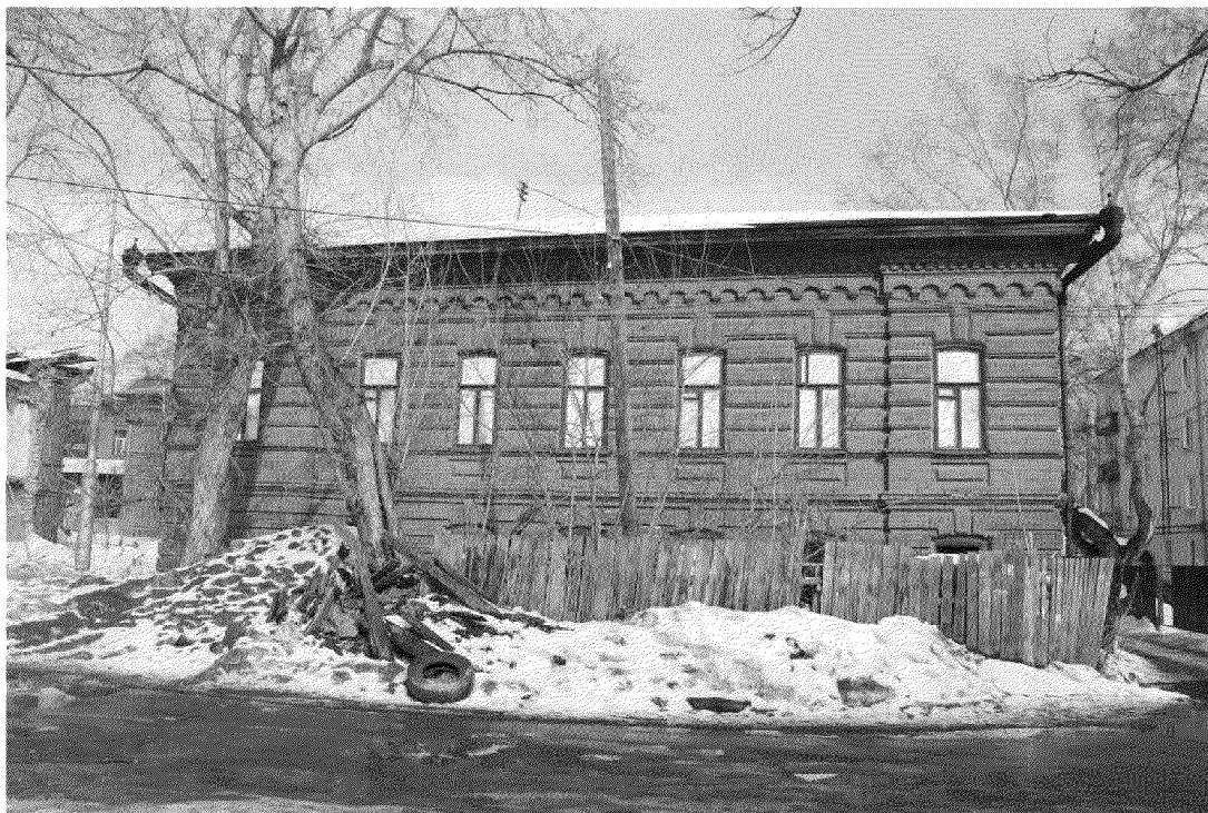
Видовая точка № 1. Южный фасад здания (Олейник А.Ю., 29.03.2021)
