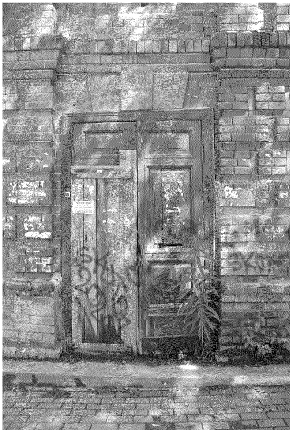
Видовая точка № 6. Деревянная филенчатая дверь главного фасада (29.06.2021 г.)
