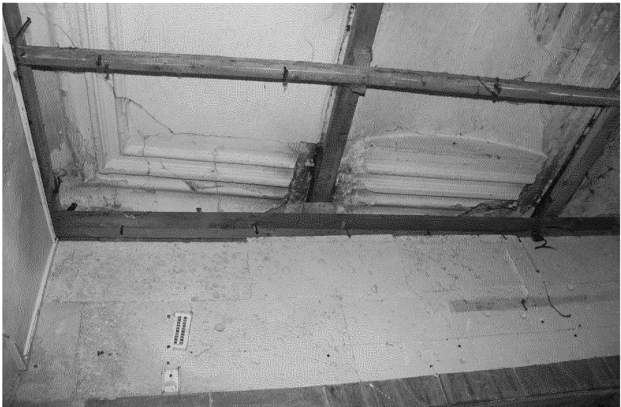
Видовая точка № 19. Фрагменты штукатурного декора сводчатого перекрытия (Олейник А.Ю., 29.03.2021)
