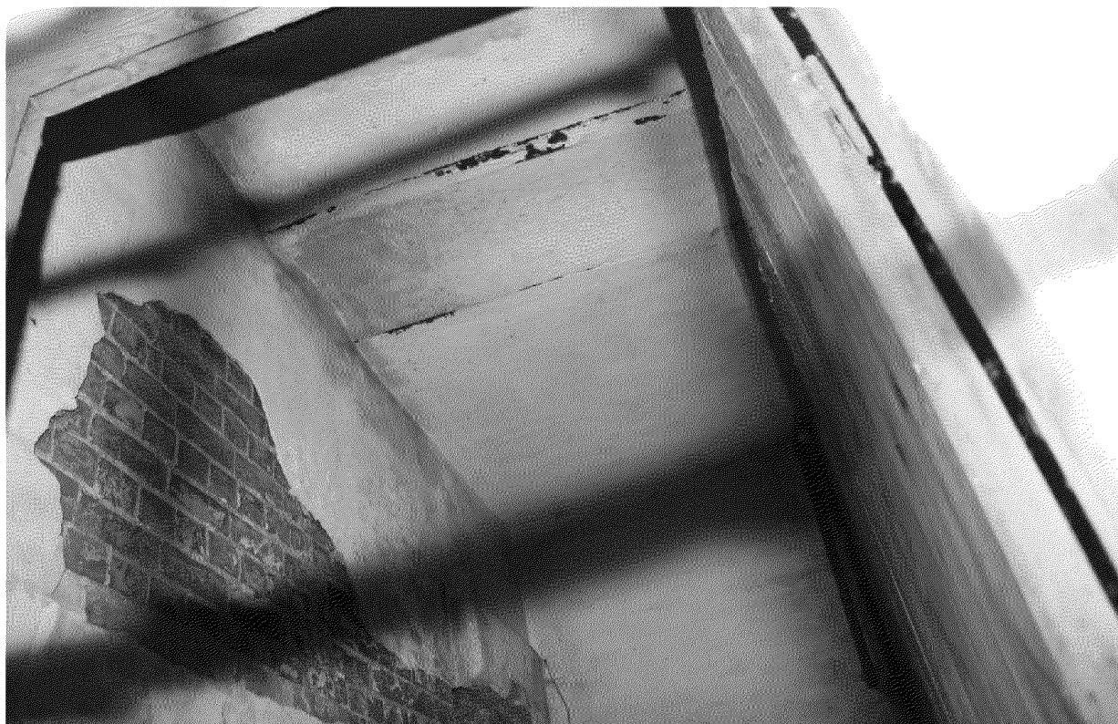
Видовая точка № 21. Помещение северной части здания с дворовым входом и фрагментом перекрытия из кирпичных сводов (Яблонская М.А., 12.09.2018)
