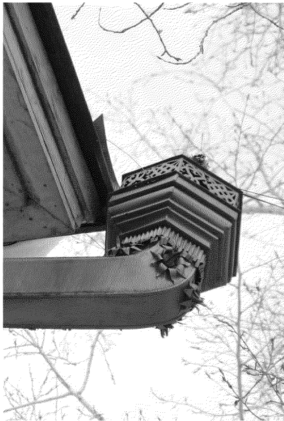
Видовая точка № 12. Водосточная труба (Олейник А.Ю., 29.03.2021)
