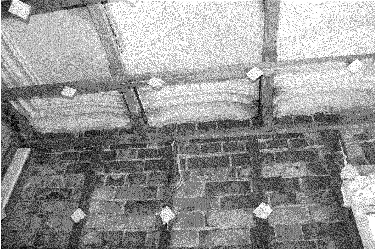
Видовая точка № 18. Фрагменты штукатурного декора сводчатого перекрытия (Олейник А.Ю., 29.03.2021)
