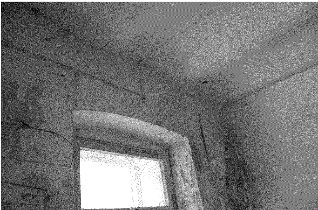
Видовая точка № 17. Фрагмент помещения 1-го этажа. Кирпичные своды перекрытия (Олейник А.Ю., 29.03.2021)
