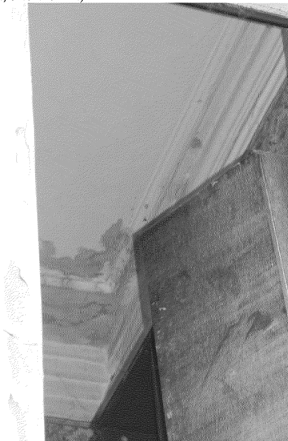
Видовая точка № 12. Профильные штукатурные тяги в отделке потолков помещений 2-го этажа
