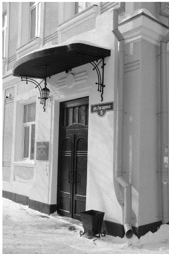
Видовая точка № 7. Парадный вход главного фасада
