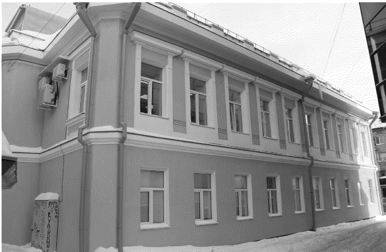
Видовая точка № 10. Боковой южный фасад здания
