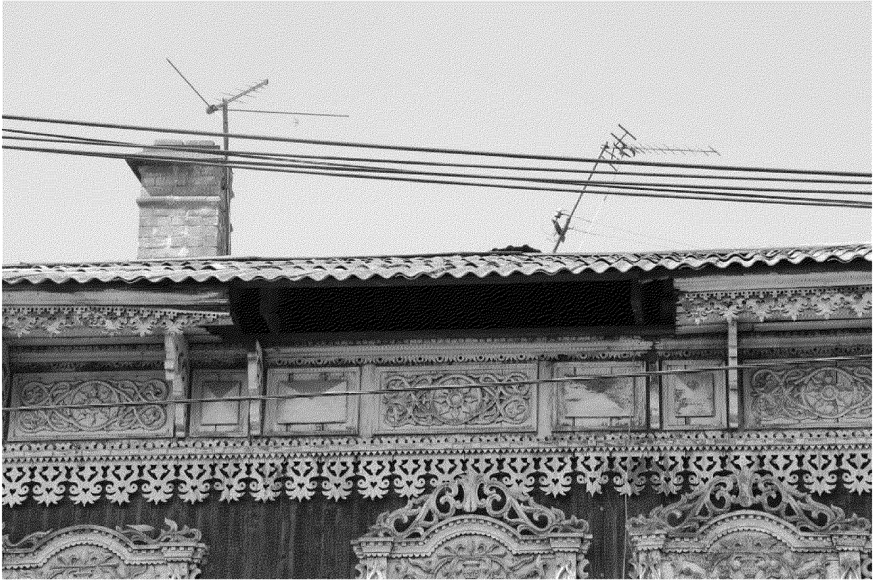
Видовая точка № 5. Фрагмент карниза главного фасада с элементами резного декора. Место расположения треугольного фронтона
