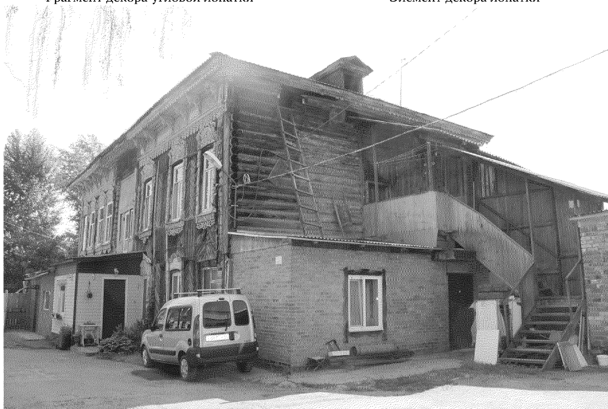
Видовая точка № 13. Дворовый западный фасад здания, вид с территории двора
