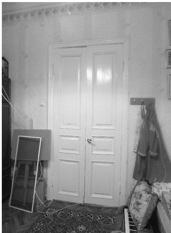
Видовая точка № 16. Деревянная двупольная филленчатая дверь (Воловодова О.В., 2014 г.)
