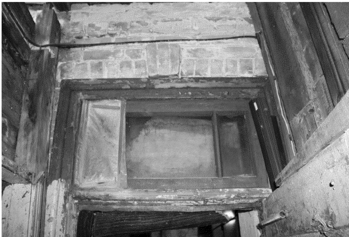
Видовая точка № 14. Дверной блок основного входа с остекленной фрамугой (восточный фасад). (Олейник А.Ю., 02.10.2020 г.)
