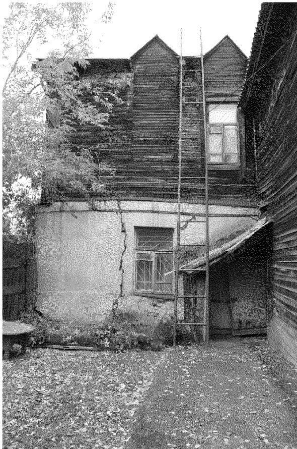
Видовая точка № 5. Фрагмент дворового восточного фасада (Олейник А.Ю., 02.10.2020 г.)
