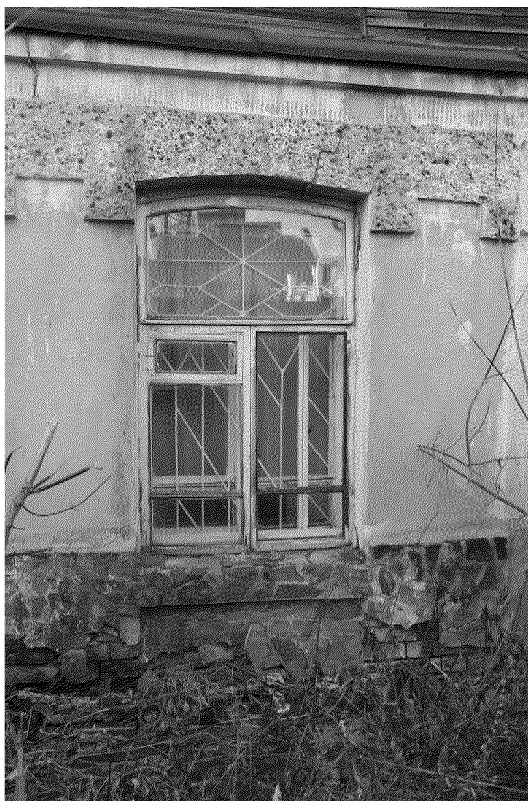
Видовая точка № 10. Лучковое окно 1-го этажа западного фасада, штукатурный пояс с фактурной отделкой, фрагмент облицовки цоколя (Рыжикова А.Ю., 26.10.2018 г.)
