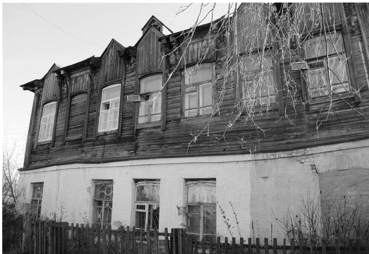
Видовая точка № 4. Северный фасад здания, вид с территории двора (фото: Рыжикова А.Ю., 26.10.2018 г.)
