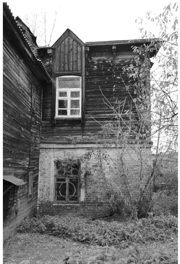
Видовая точка № 6. Фрагмент дворового восточного фасада (Олейник А.Ю., 02.10.2020 г.)
