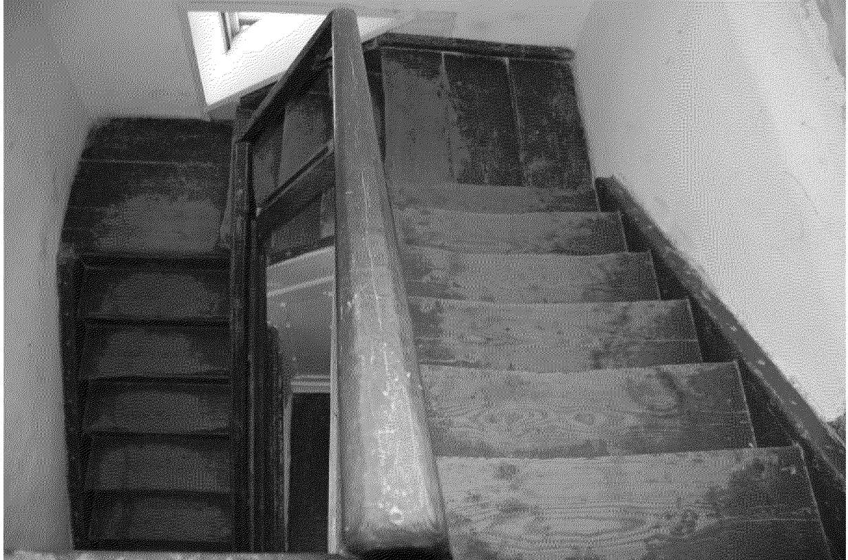
Видовая точка № 21 Деревянная трехмаршевая парадная лестница
