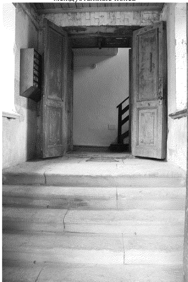
Видовая точка № 15 Пристройка парадного входа. Лестница из песчаника, филенчатые двери
