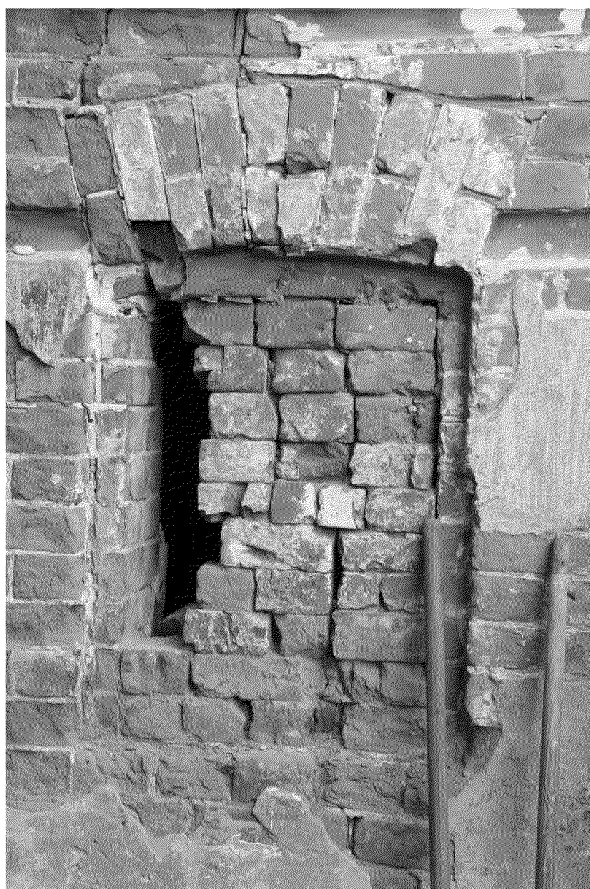
Видовая точка № 9 Лучковый оконный проем дворового ризалита
