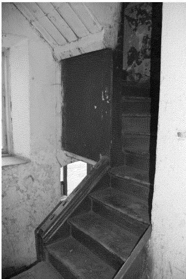
Видовая точка № 26 Деревянная с забежными ступенями лестница дворового ризалита
