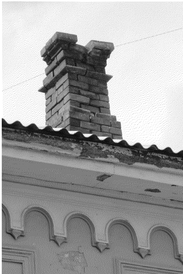
Видовая точка № 7 Кирпичная печная труба
