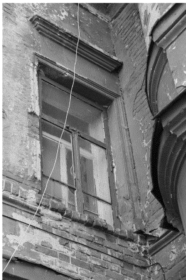
Видовая точка № 11 Окно 2-го этажа дворового фасада.
