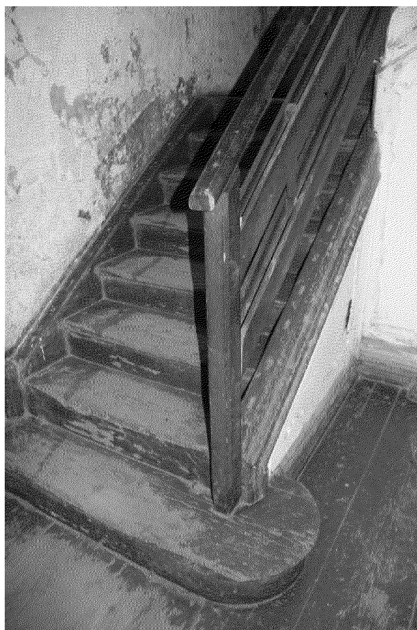
Видовая точка № 19 Фрагмент парадной лестницы
