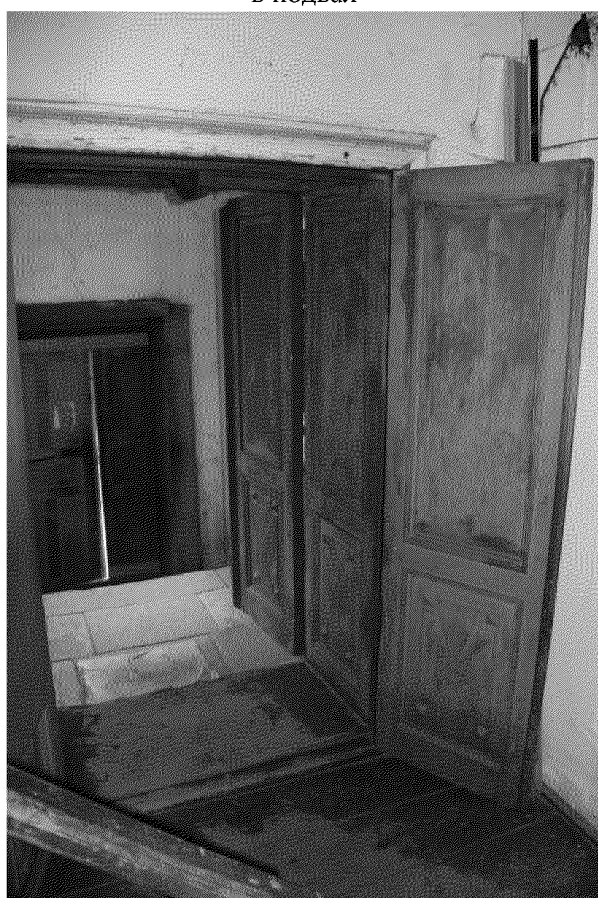
Видовая точка № 16 Деревянный филенчатый тамбур парадного входа
