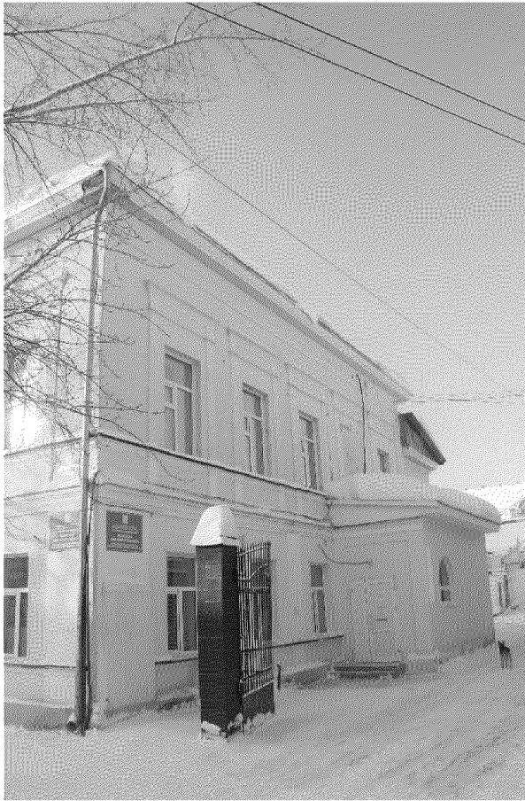
Видовая точка № 5. Боковой северный фасад здания
