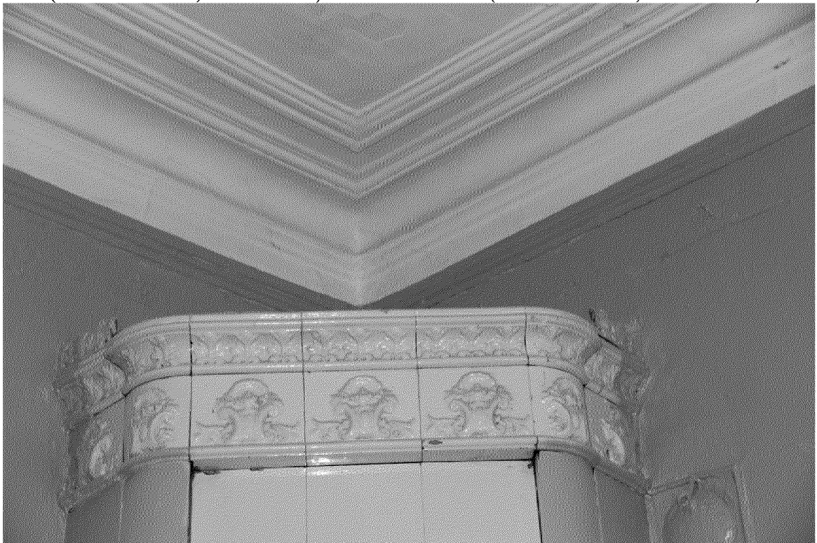
Видовая точка № 22. Фрагмент венчающего карниза угловой изразцовой печи (2 этаж) (Яблонская М.А., 11.08.2015 г.)
