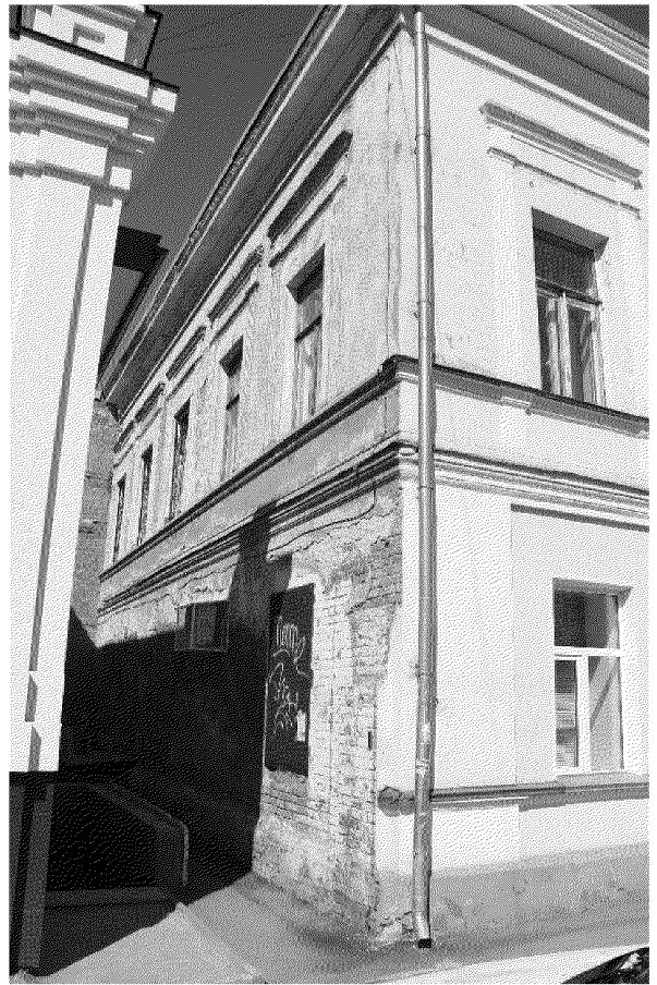
Видовая точка № 6. Боковой южный фасад здания
