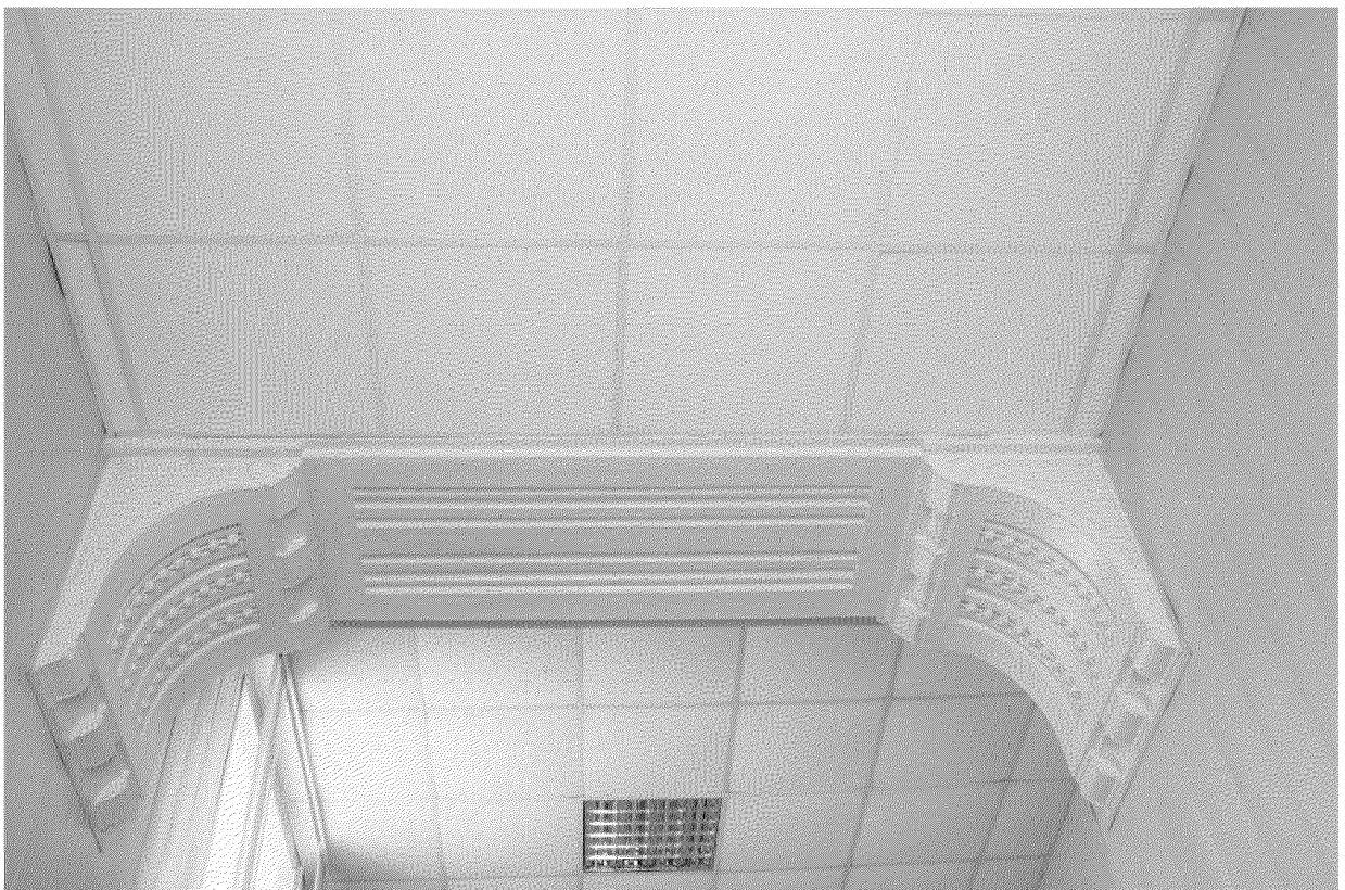
Видовая точка № 11. Профильная тяга над парадной лестницей с фигурными кронштейнами
