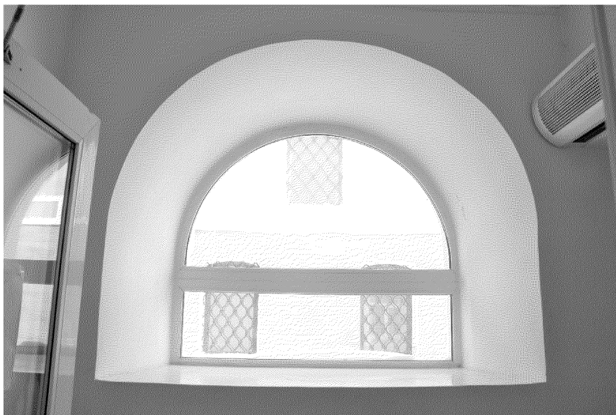
Видовая точка № 9. Арочное окно входного тамбура
