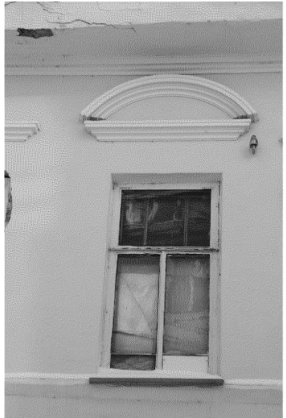
Видовая точка № 11 Окно 2-го этажа северного фасада
