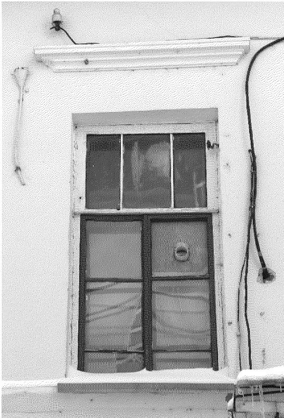
Видовая точка № 10 Окно 2-го этажа северного фасада
