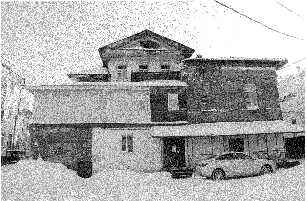
Видовая точка № 5 Западный дворовый фасад здания
