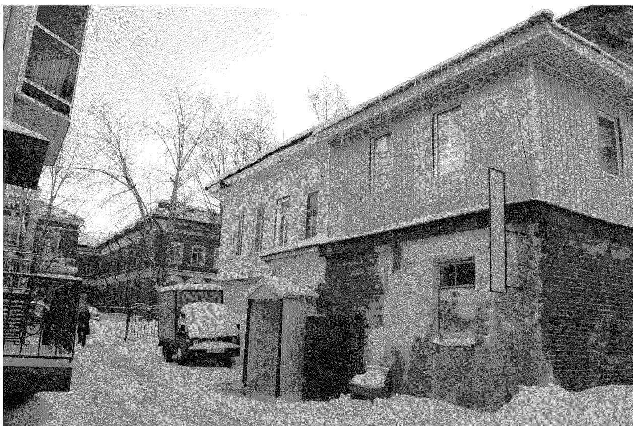
Видовая точка № 4. Северный фасад здания, вид с дворовой территории
