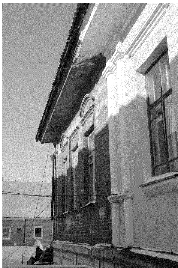
Видовая точка № 9 Фрагмент южного фасада
