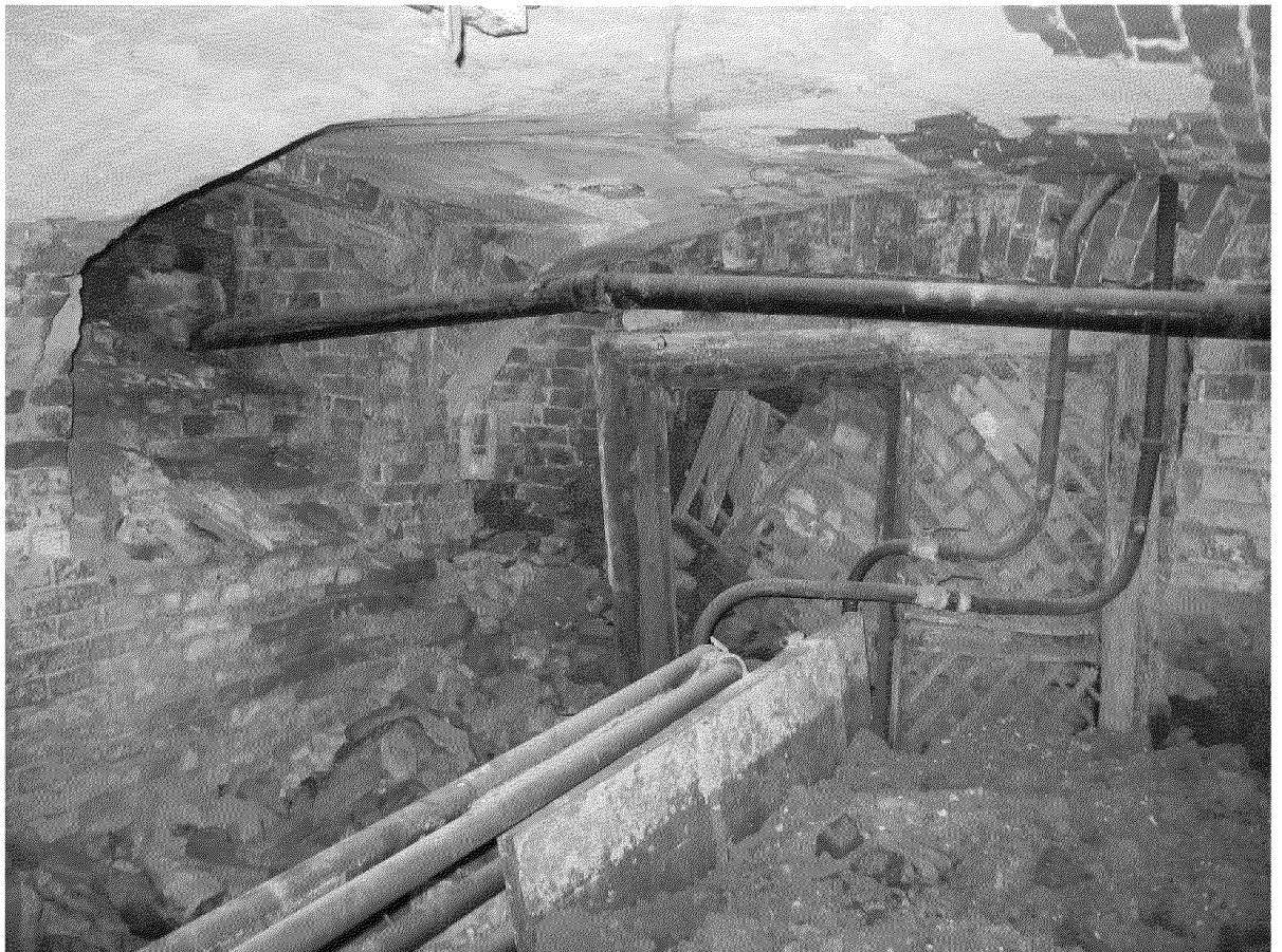
Видовая точка № 22 Фрагмент помещения подвала. Кирпичный свод перекрытия с распалубками в местах расположения окон (2009 г.)
