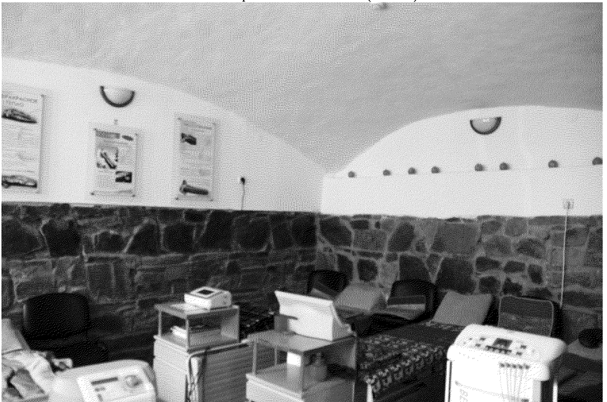
Видовая точка № 23 Кирпичный парусный свод в помещении подвального этажа (Рыжикова А.Ю., 2015 г.)
