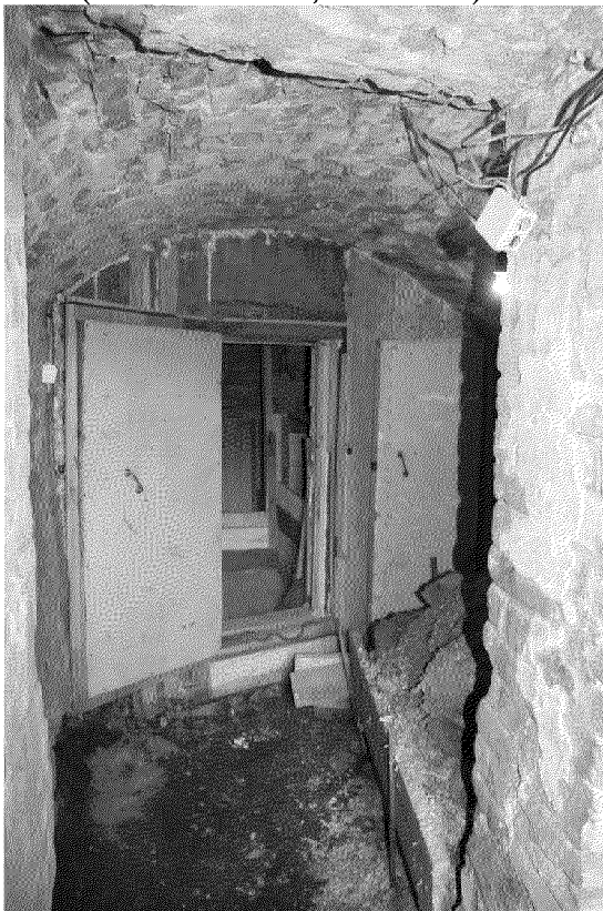
Видовая точка № 20 Помещение подвала с кирпичным сводом (Яблонская М.А., 31.05.2021)
