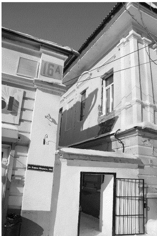
Видовая точка № 8 Фрагмент южного фасада
