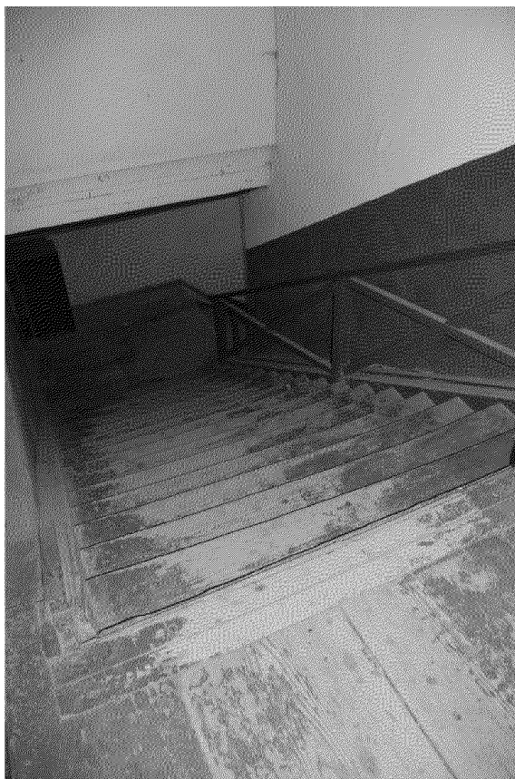
Видовая точка № 14 3-х маршевая деревянная лестница (Яблонская М.А., 31.05.2021)
