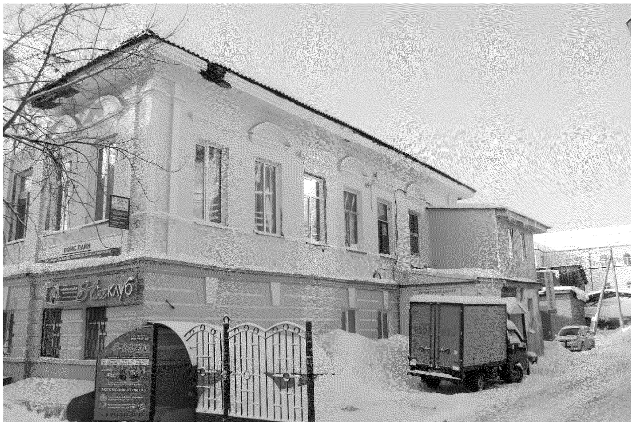
Видовая точка № 3. Северный фасад здания
