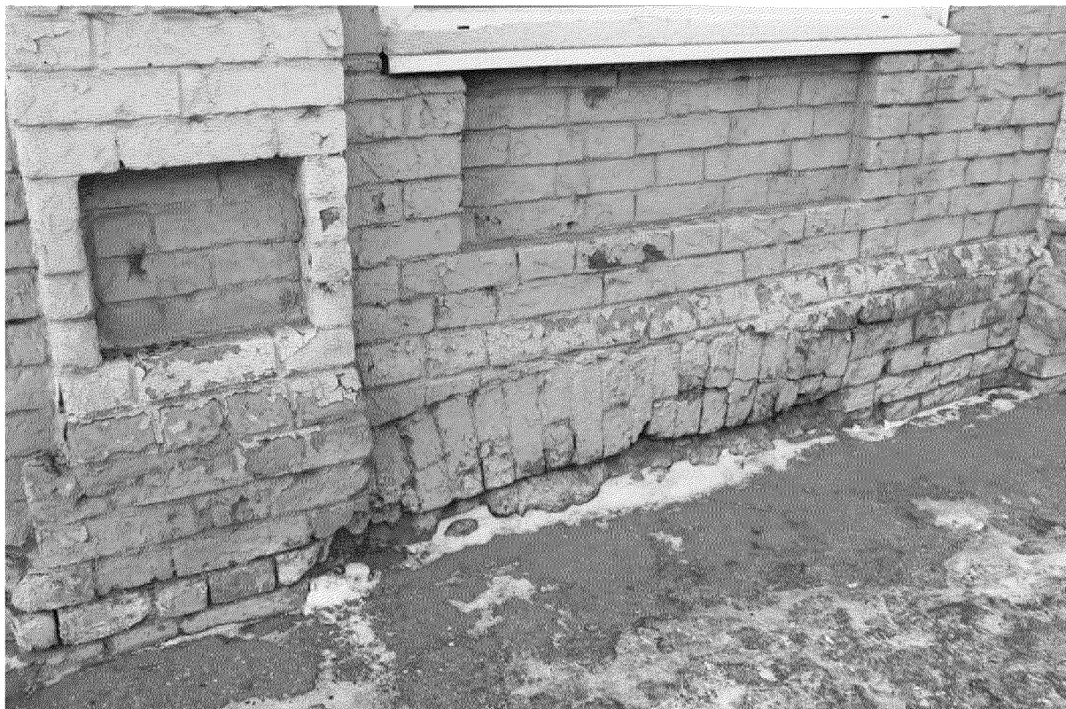
Видовая точка № 7. Клинчатая лучковая перемычка окна цокольной части здания
