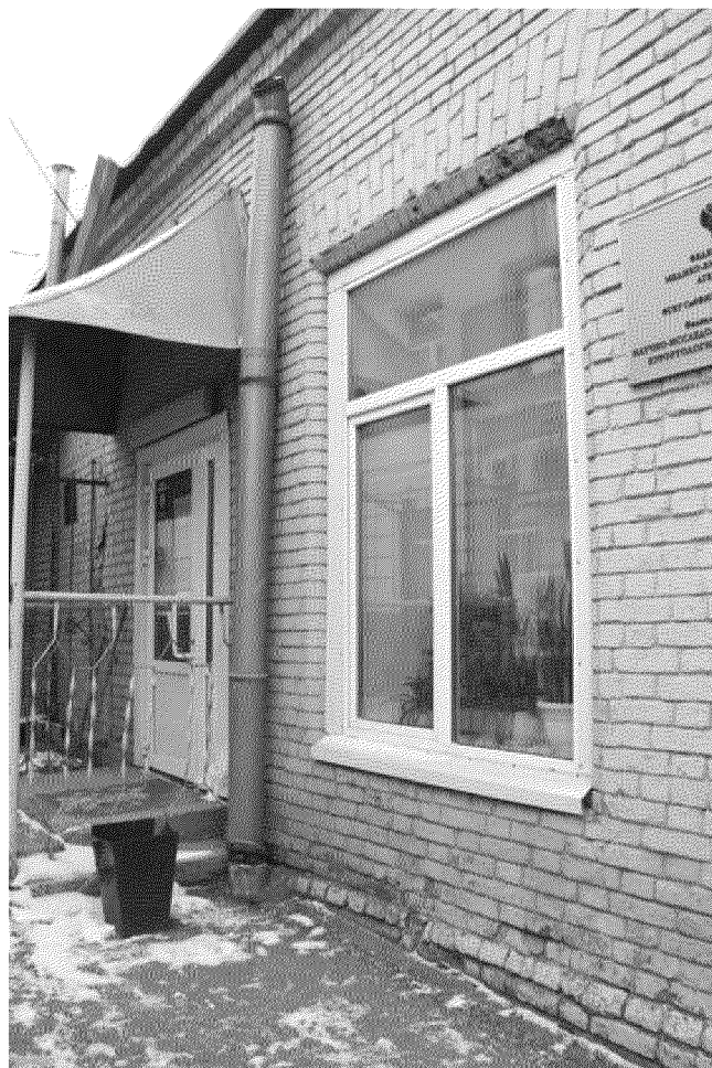
Видовая точка № 11. Стеновая кладка и оконный проём с прямой клинчатой перемычкой
