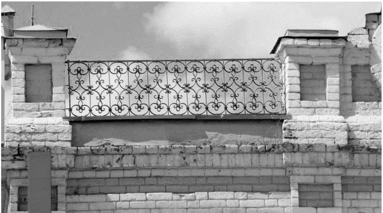
Видовая точка № 6. Кованая решётка ограждения парапета
