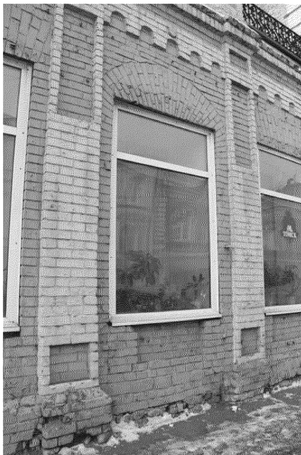
Видовая точка № 4. Фрагмент стеновой кладки. Пилястры. Арочная перемычка центрального оконного проёма. Фрагмент фриза с арками.
