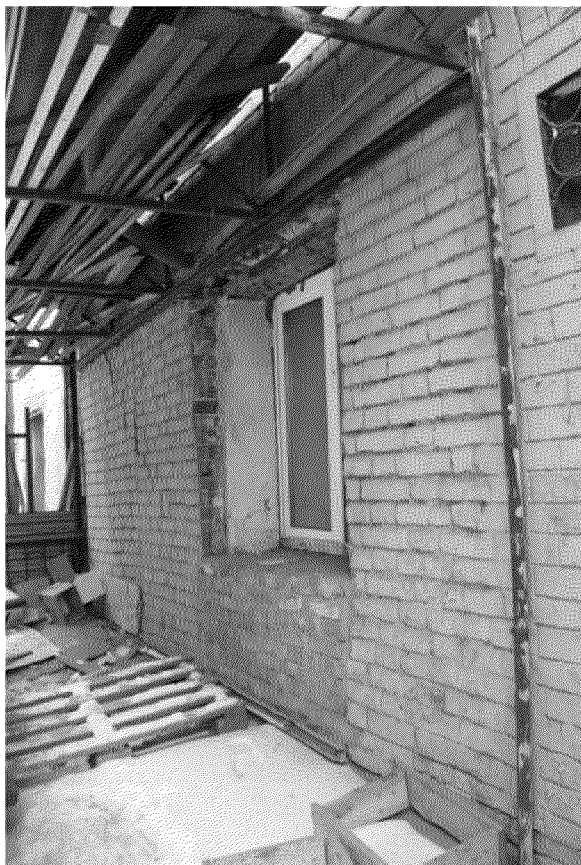
Видовая точка № 9. Фрагмент стеновой кладки и дверной проём с клинчатой лучковой перемычкой
