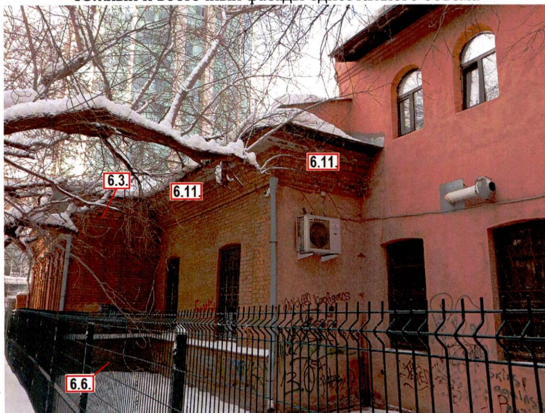
Южный и восточный фасады одноэтажного объема
