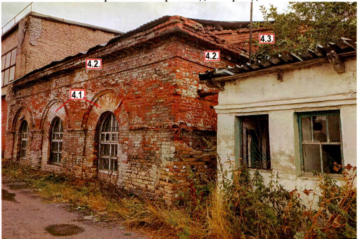
Фрагмент северо-западного фасада
