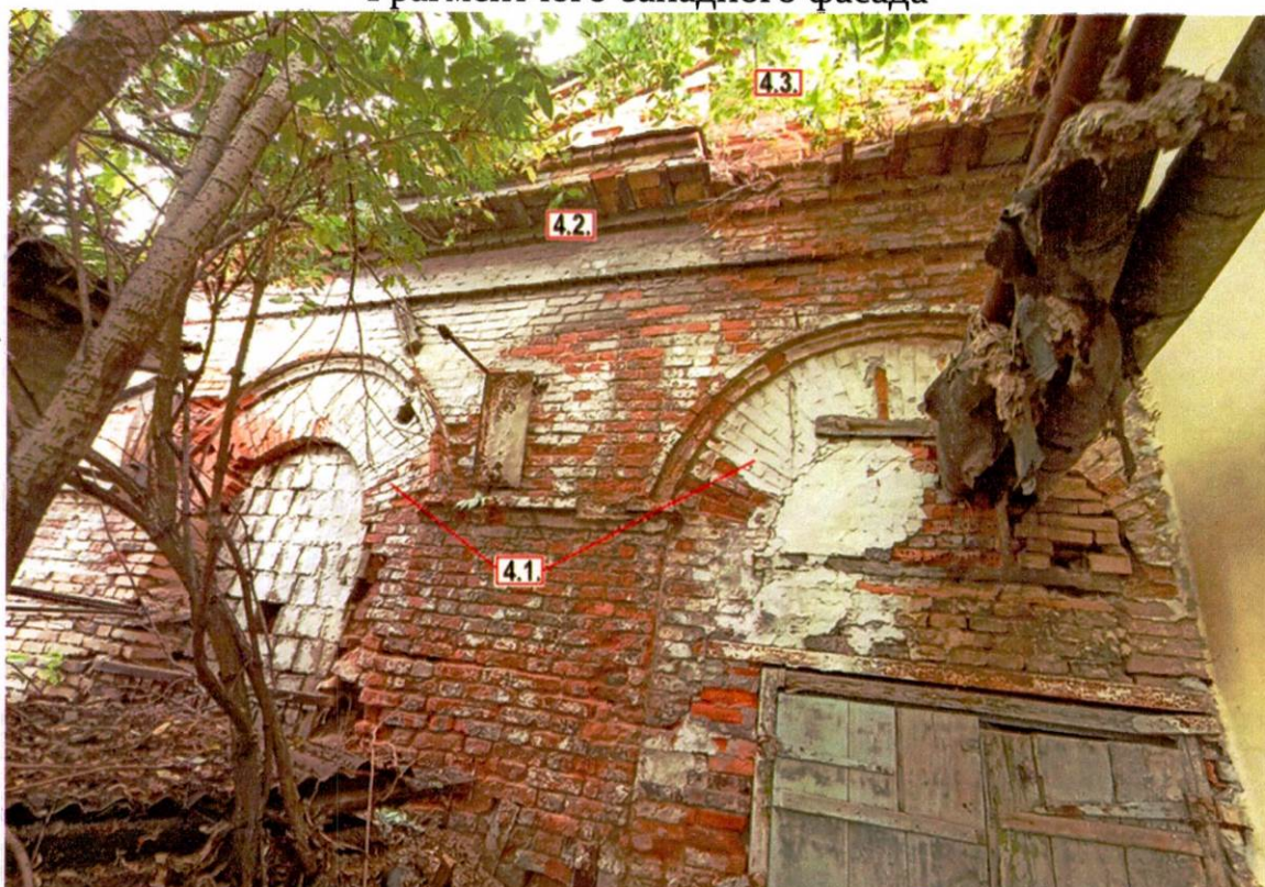
Фрагмент юго-западного фасада
