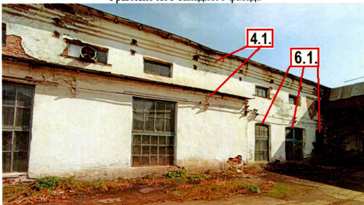
Фрагмент юго-западного фасада
