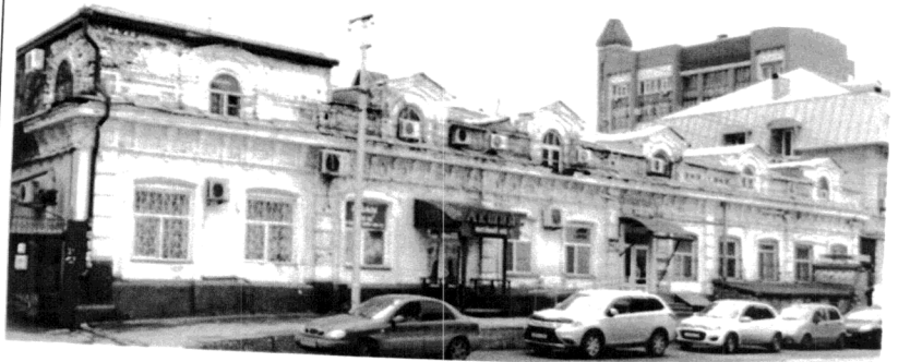
«Корпус № 7» (ул. им. Кутякова И.С., 9)
