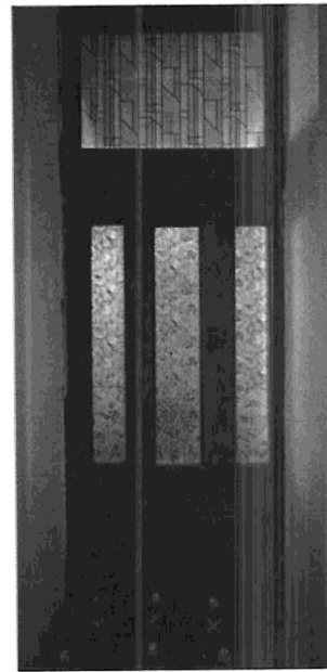
Форма, габариты и рисунок расстекловки дверей тамбура.
