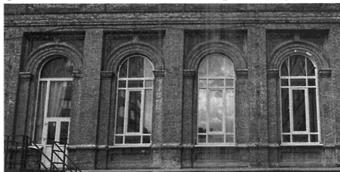
Арочная форма завершения и габаритные размеры оконных проемов здания лит. А1.
