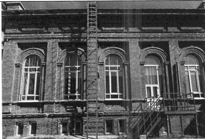
Общий вид художественной кирпичной кладки фасада 2 здания лит.А1.
