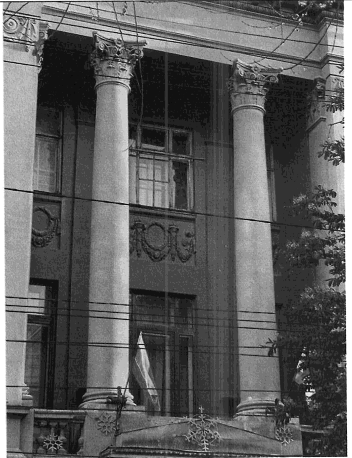
Две колонны коринфского ордера и пилястры коринфского ордера, расположенные в нише между окон.
