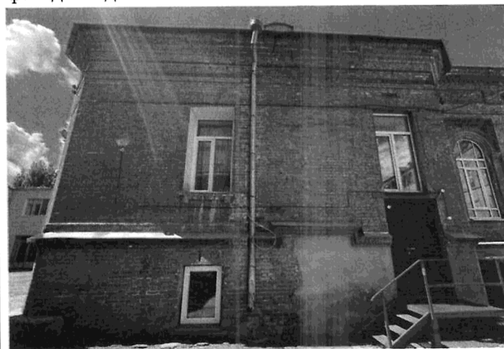
Общий вид открытой кирпичной кладки фасада 1 здания лит.А2.
