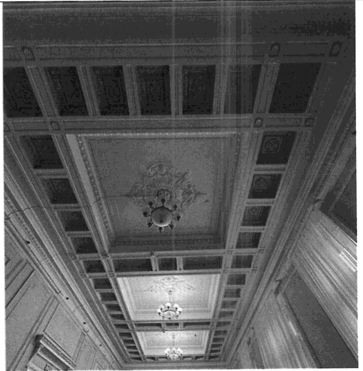
Кессонные потолки с тянутыми карнизами и лепным декором на 2 этаже здания (выставочный зал).
