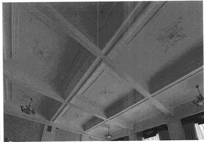
Кессонные потолки с тянутыми карнизами и лепным декором на 2 этаже здания.
