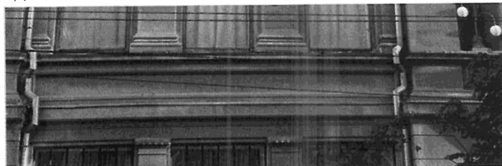
Горизонтальные тяги между 1 и 2 этажами.
