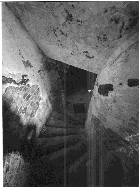
Лестница в подвал.
