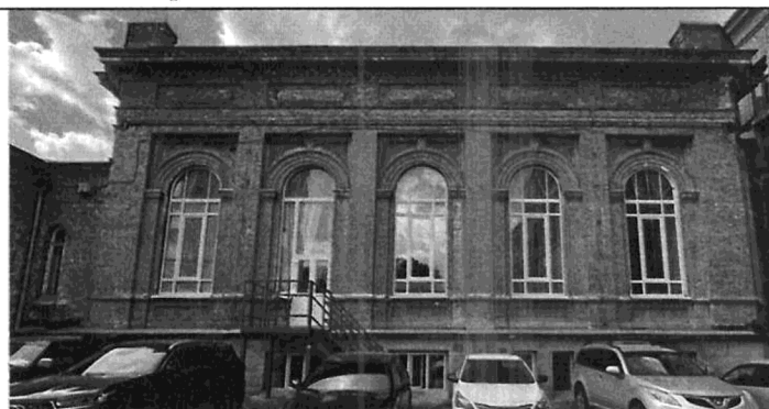
Общий вид художественной кирпичной кладки фасада 1 здания лит. А1.
