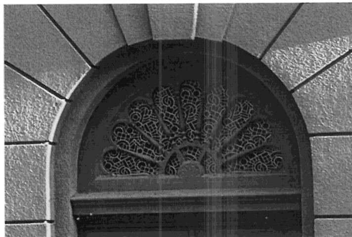
Деревянные арочные фрамуги дверных проемов 1 этажа.
