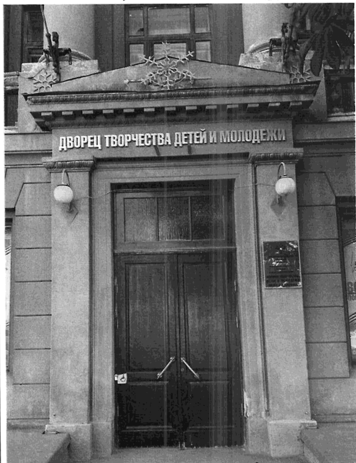
Фронтон с барельефом, карниз, пилястры и входная дверь с фрамугой центрального входа в здание
