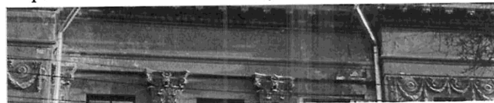
Горизонтальная тяга над окнами 3 этажа.
