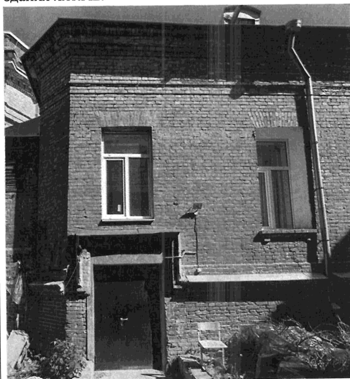
Общий вид открытой кирпичной кладки фасада 2 здания лит.А2.
