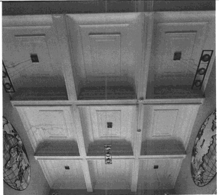
Кессонные потолки с тянутыми карнизами на 2 этаже здания.
