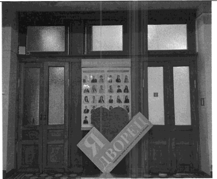
Деревянные порталы с подлинными дверями.
