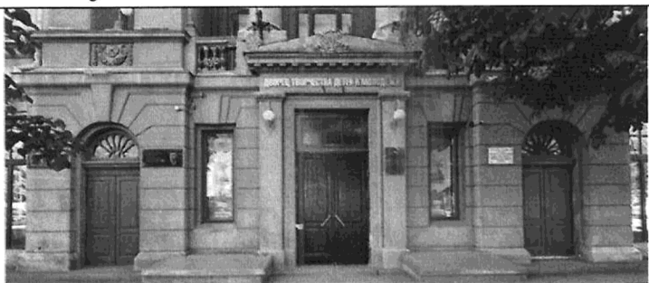
Рустовка стен в уровне 1 этажа, имитация замкового камня увеличенной высоты руста.
