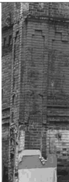
ступенчатая филленка с зубцами в уровне 1 этажа
