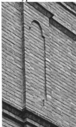
филленка в уровне 2, 3 этажей и в нижнем уровне 4 этажа
