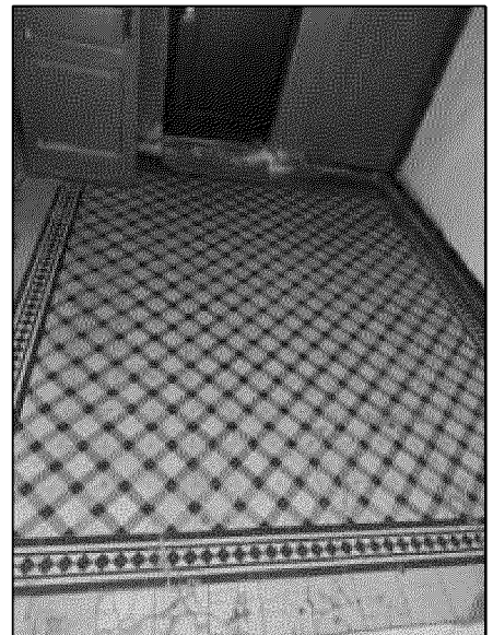
лестничная площадка в уровне второго этажа парадной лестницы, облицованная керамической плиткой.
