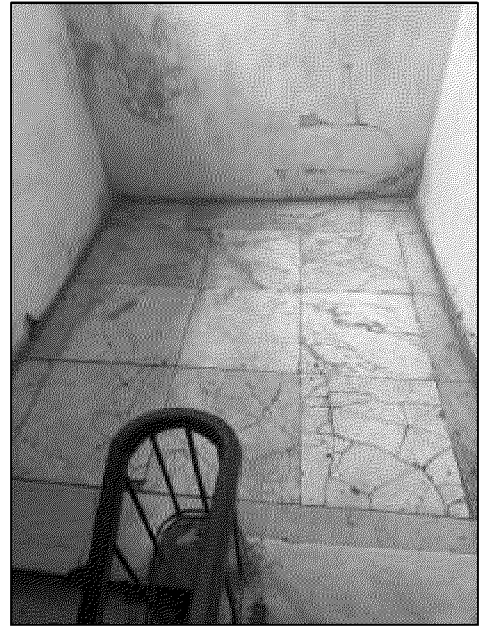
междуэтажная площадка парадной лестницы, облицованная плитами мрамора
