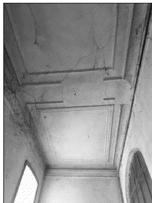
декор потолка и стен в помещении парадной лестничной клетки объекта культурного наследия
