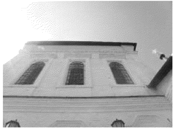
окна второго яруса центральной части
