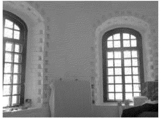
распалубка оконных проемов.
