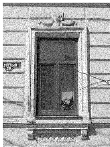
окно в уровне 1-го этажа
