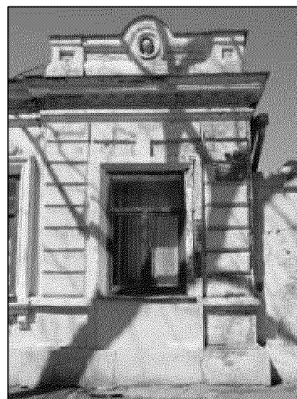
северо-восточная раскреповка главного фасада
