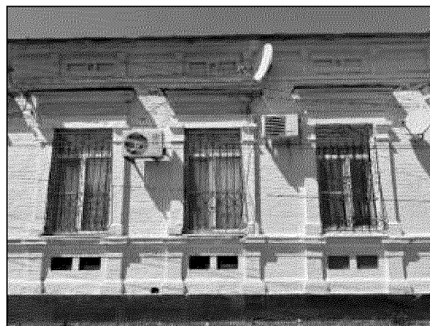
окна на основном поле фасада
