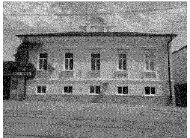
главный северо-западный фасад
